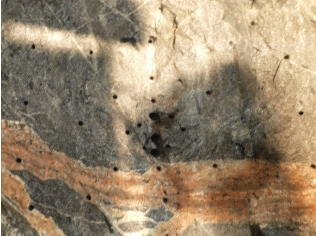
Kuva 9: Avauksen avarretut reiät
