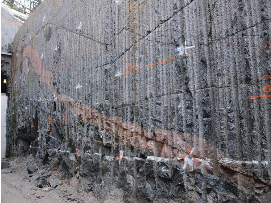
Kuva 13: Avoleikkauksen harjateräspultitus
