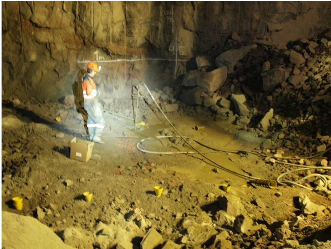
Kuva 4: Kulun esi-injektointi käynnissä
