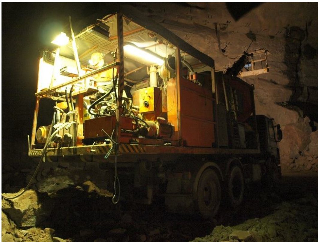
Kuva 5: Kuorma-auton päälle rakennettu injektointiyksikkö
