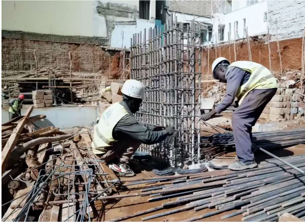
Kuva 25. Raudoitustyötä rakennustyömaalla Nairobissa.
