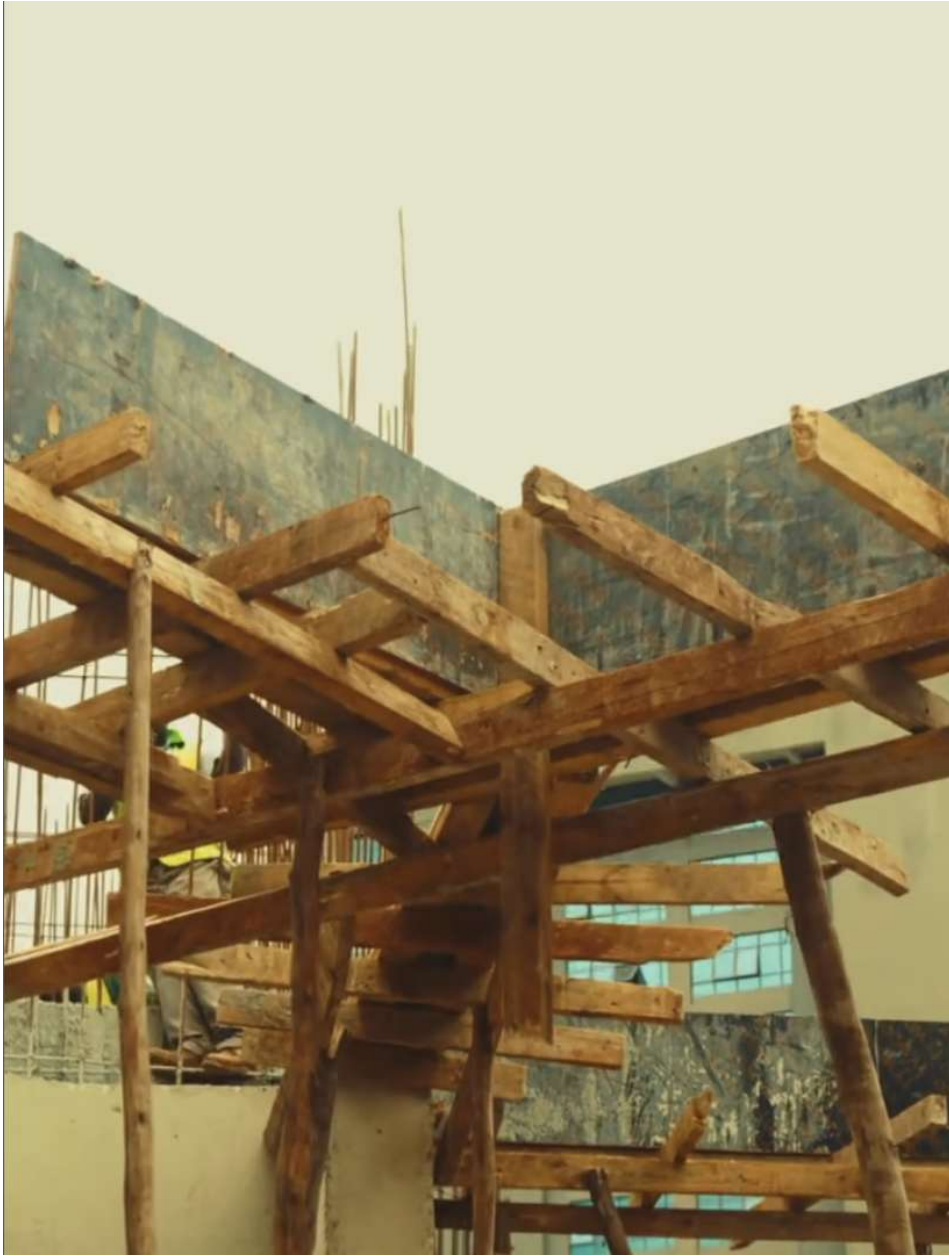
Kuva 11. Rakenteiden väliaikainen tuenta ja muottirakenne asuinrakennustyömaalla Keniassa. Kuvassa näkyy puinen teline- ja muottijärjestelmä, joka siirtää kuormia väliaikaisesti ennen betonin kovettumista. Tällaiset ratkaisut ovat yleisiä, mutta niiden jäykkyys ja turvallisuus vaihtelevat huomattavasti (Urban Glow Real Estate Ltd, 2025). Kuva on otettu Urbanglow-projektin Finsbury Heights -työmaalla Nairobissa
