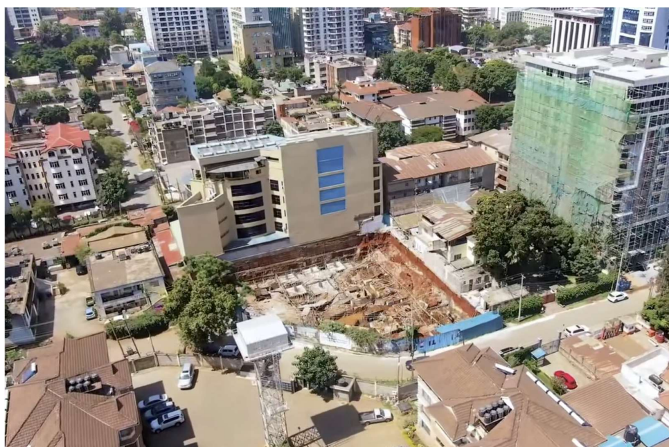
Kuva 1. Finsbury Heights-rakennustyömaa Nairobissa (Urban Glow Real Estate Ltd, 2025).
