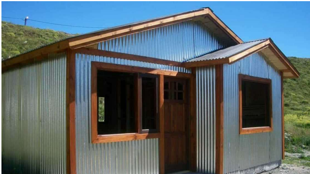
Kuva 20. Kevyt metallilevyseinäinen asuinrakennus Keniassa esimerkki ohutseinärakenteesta, jonka ääneneristävyys on heikko (TUKO.co.ke 2023).
