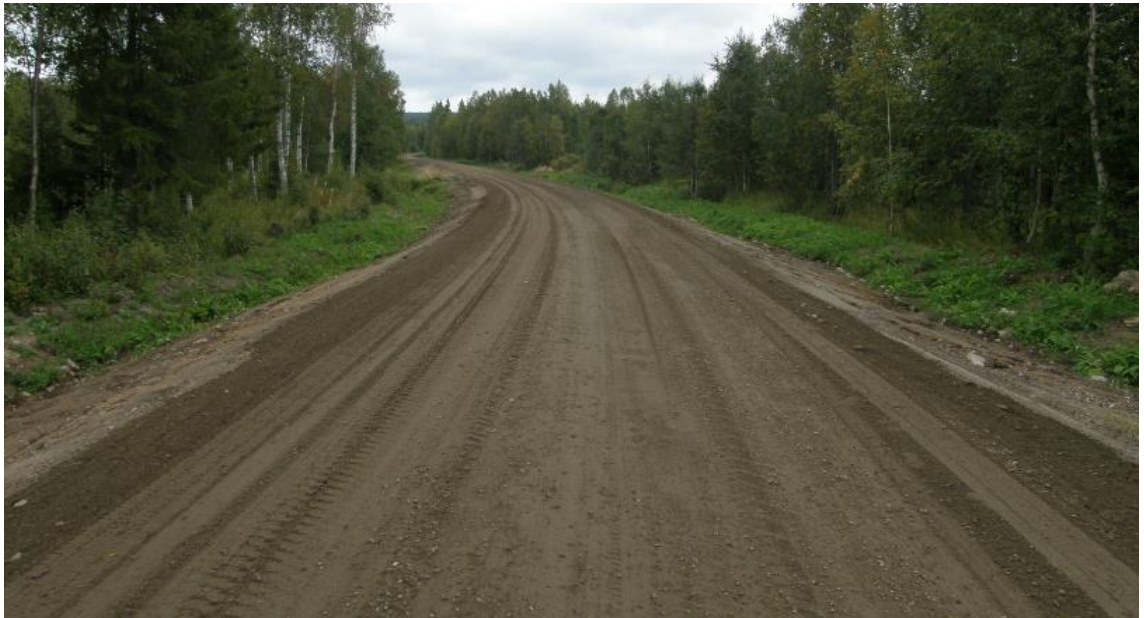
Kuvio 20. Liikenne on kiinteyttänyt tienpintaa
