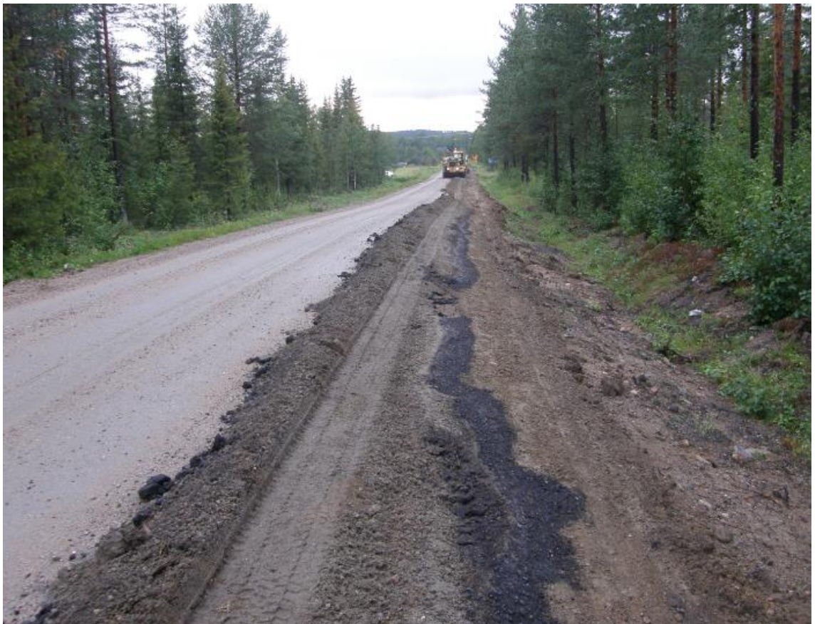
Kuvio 14. Reunannosto on suoritettu ja materiaali jyrskitään takaisin tierakenteeseen. Vanha öljysorapäälyste tuli myös esiin.
