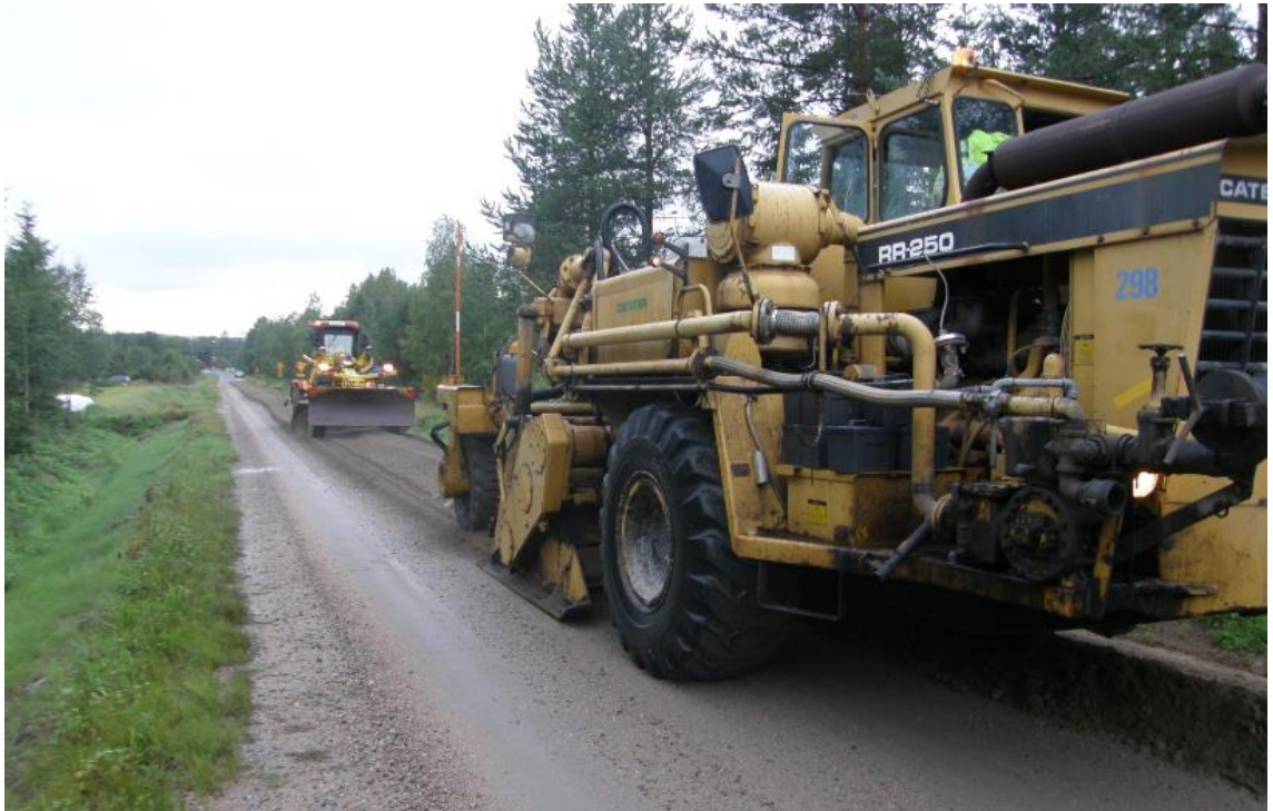
Kuvio 15. Sekoitusjyrsintätyö käynnissä ja tiehöylä poljettaa perässä
