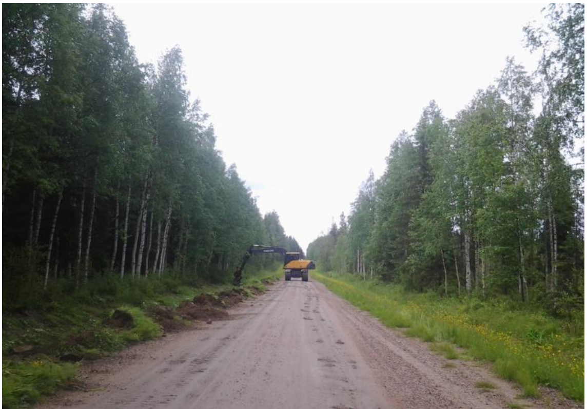
Kuvio 13. Sivuojien kaivuuta ja hyödynnettävän luiskamateriaalin nostoa tien pientareille
