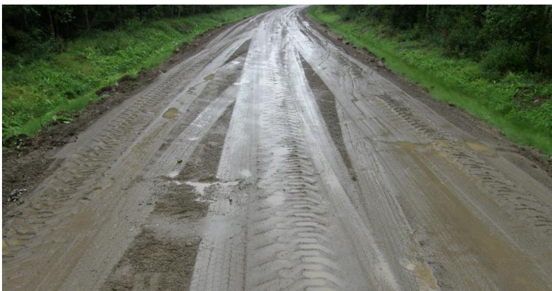
Kuvio 18. Sadekuuron jälkeen liettyä tienpintaa
