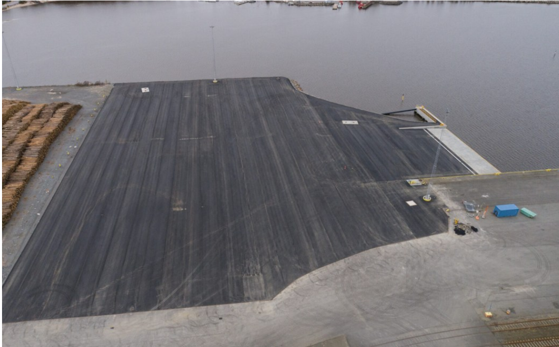
Kuva 2. RoRo-ramppi ja takakenttä, (Port of Pori, 2025)
