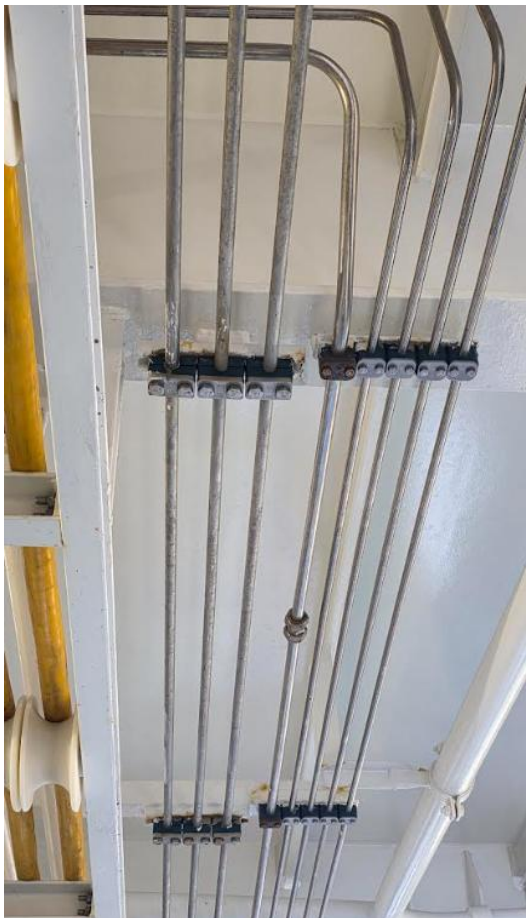
Kuva 5. Kuvassa paineilmaputket on kannakoitu jäykisteisiin eli laivan teräsrakenteisiin.
