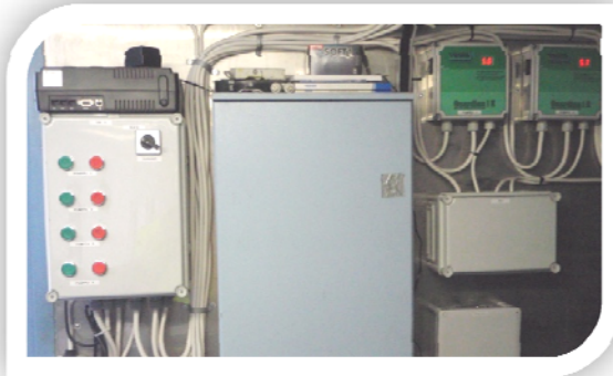
Säänkestäviin kontteihin voi asentaa myös laitteistoja ohjaavaa automatiikkaa
