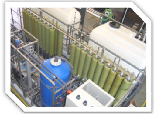
Suotoveden käsittelyjärjestelmä toiminnassa
