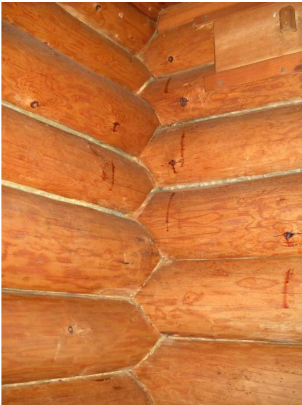
Kuva 40. Hevosnokan saunan sisänurkka. Seinillä joitain pihkavalumia. Aivan kuvan oikeassa ylälaudassa on näkyvissä puinen tuuletusluukku.
