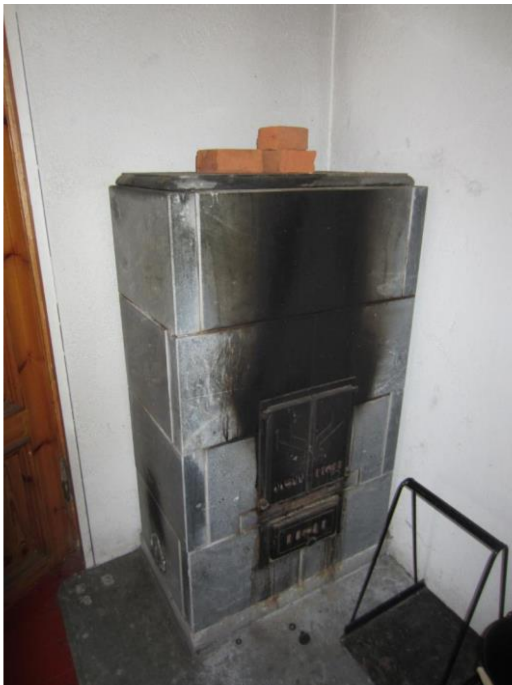
Kuva 92. Toivolahden päärakennuksen vuolukivestä tehdyt takat ovat nokeentuneita. Tuhkaluukun alapuolella on valumajälkiä.
