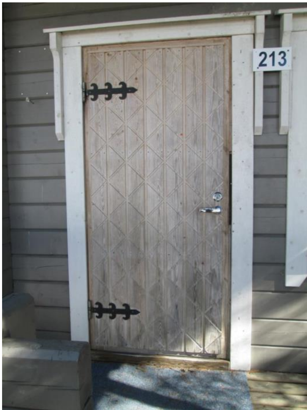
Kuva 22. Ulpukan mökin puinen ulko-ovi. Ovi on tummunut alaosasta.
