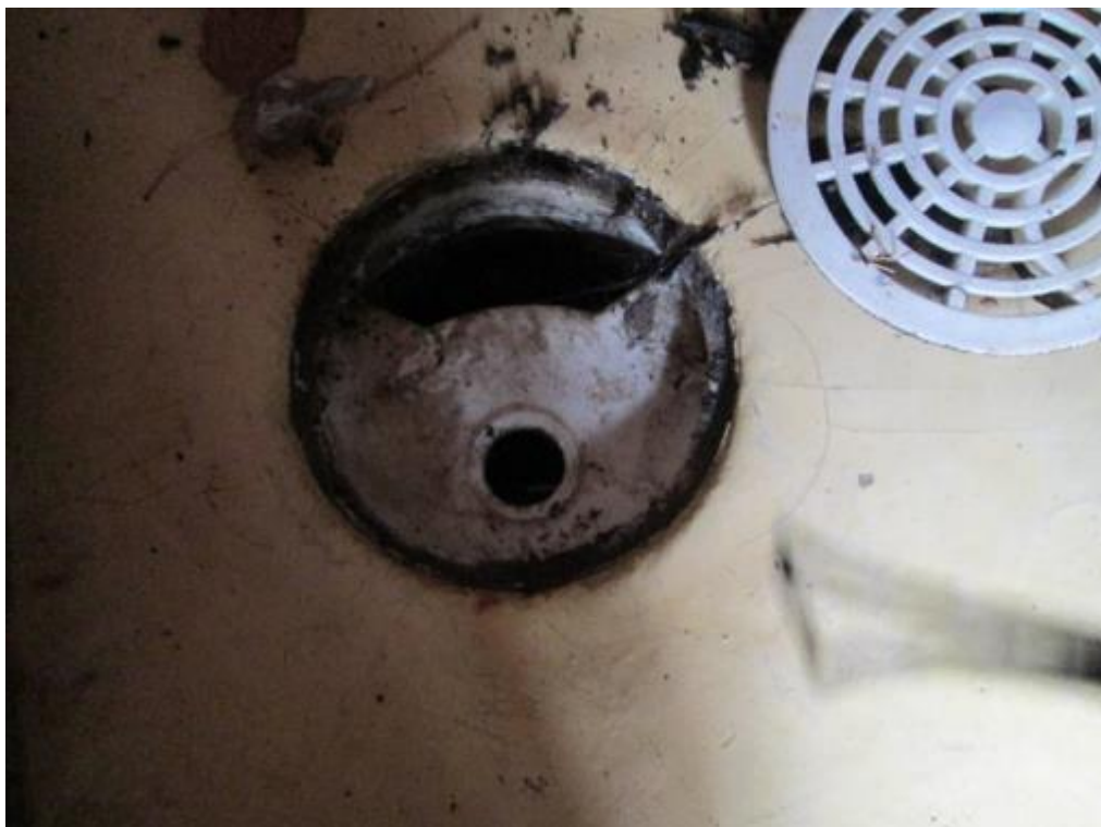
Kuva 63. Koskelan mökin saunan lattiakaivo on likainen.
