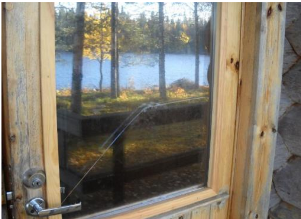
Kuva 34. Hevosnokan saunarakennuksen ulko-oven lasi on halki. Ikkunalistat ovat uuden näköiset.
