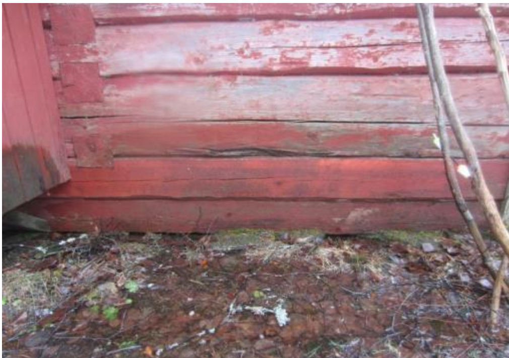
Kuva 77. Toivolahden päärakennus on perustettu kivien päälle. Kivet ovat vihertyneitä. Perustusten läheisyydessä on koivunlehtiä, havunneulasia ja oksia.
