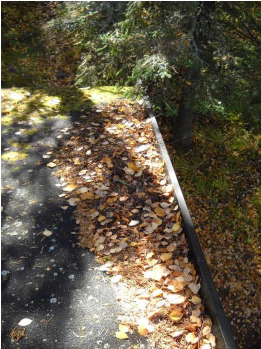
Kuva 11. Ulpukan perhemökin päälle on pudonnut läheisistä puista runsaasti koi- vunlehtiä, havunneulasia ja oksia. Räystäällä on runsasta sammalkasvustoa.
