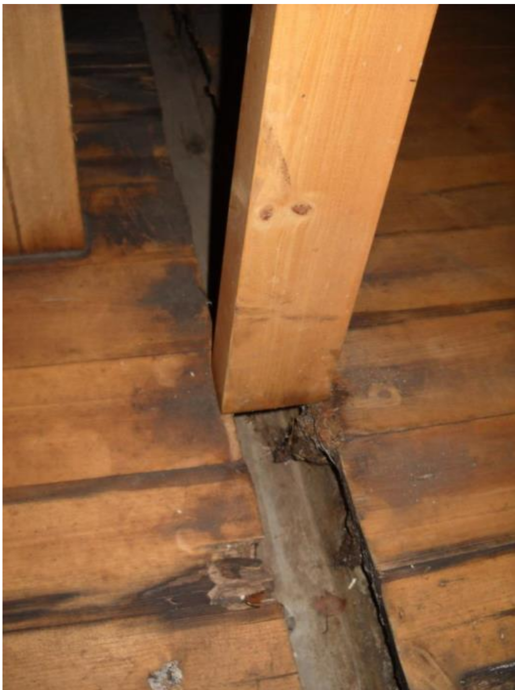
Kuva 39. Hevosnokan saunan vedenjohdatuskuilu on likainen. Joistain laudoista on lohkeillut palasia. Laudoitus on paikoin likaista ja kulunutta.
