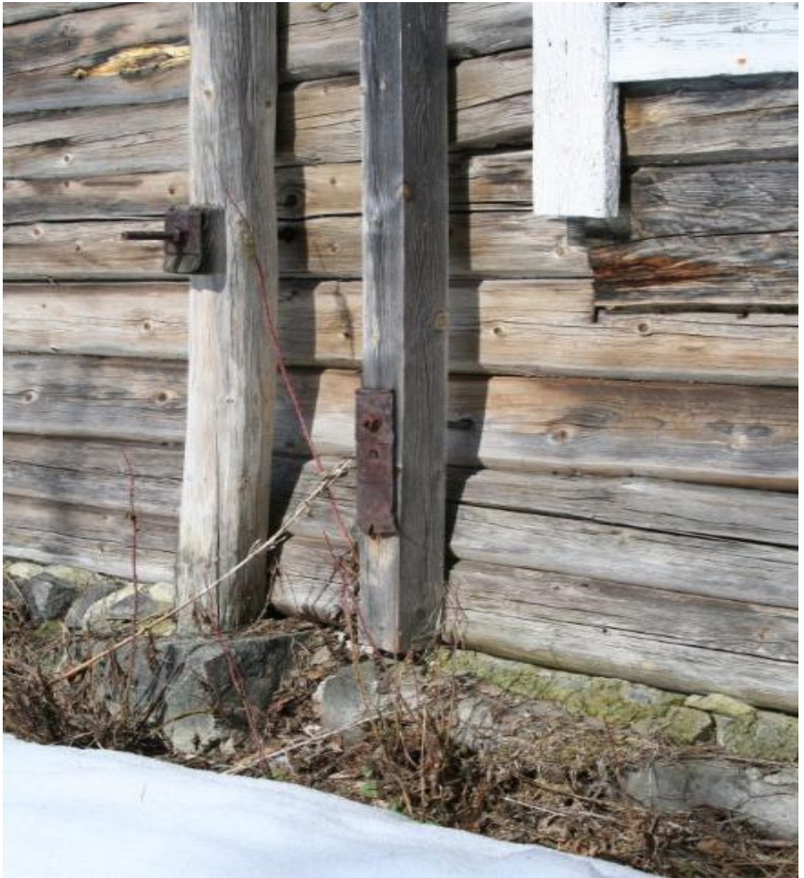
Kuva 6. Följareilla tuettua vanhaa hirsiseinää. [14.]
