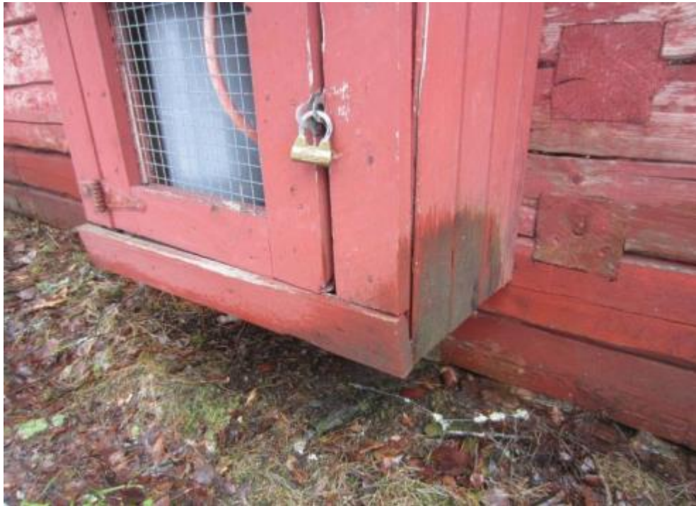
Kuva 85. Toivolahden päärakennuksen kaasukopin alin vaakalauta on irronnut toisesta päästä. Maalipinnat ovat kuluneet ja alin osa on kostunut.
