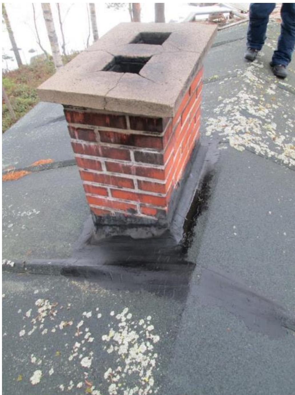
Kuva 61. Koskelan mökin muurattu savupiippu. Tiilet ovat tummuneet yläosasta. Piipun yläjuuresta puuttuu kaato.
