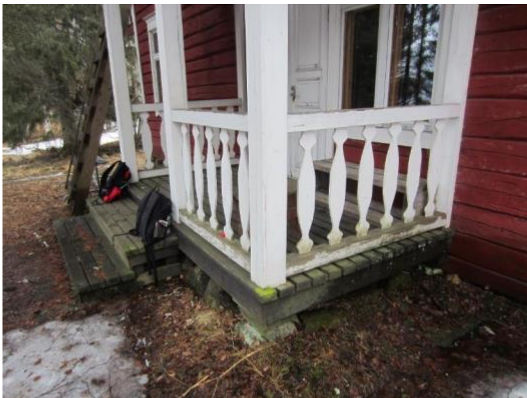
Kuva 75. Toivolahden päärakennuksen pääsisäänkäynti. Kuisti on perustettu kivien päälle.
