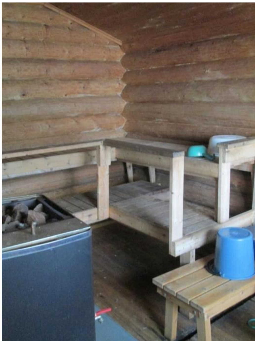
Kuva 41. Hevosnokan saunan puurunkoiset lauteet ja penkki.
