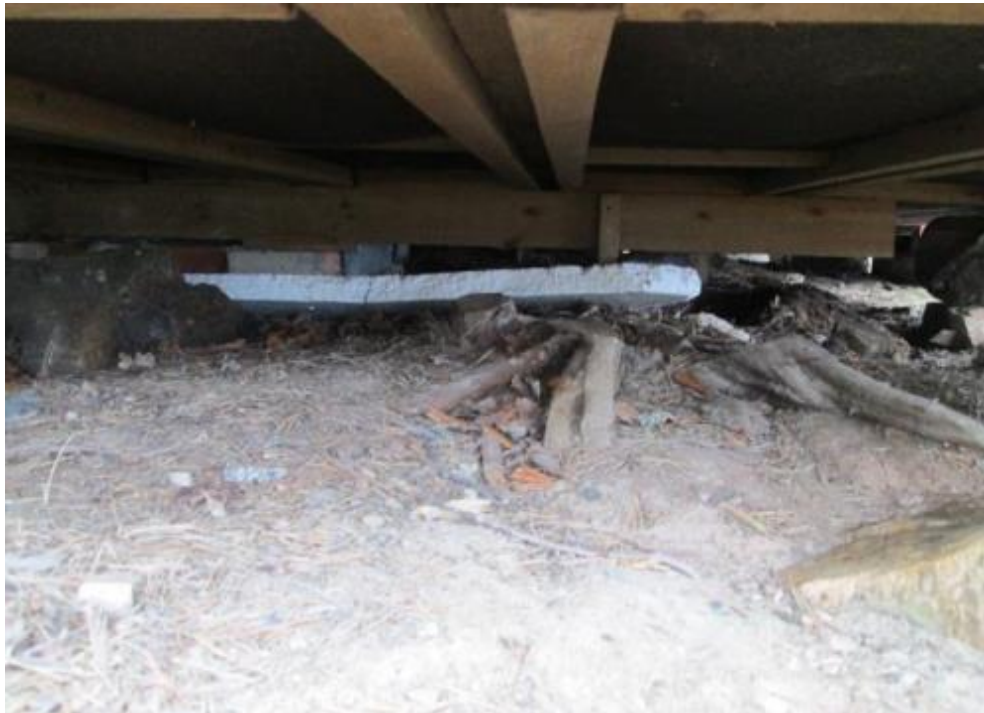
Kuva 54. Koskelan mökin ryömintätila. Kuvassa takavasemmalla näkyy vähän pii-pun alimpia rakenteita. Ryömintätilaan on jätetty puiden kantoja ja kiviä. Maan-pinta on epätasainen.
