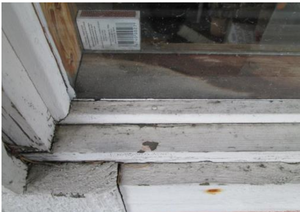
Kuva 57. Koskelan mökin etupuolen ikkunan maalipinnat ovat kuluneet. Ikkunarakenteet ovat likaiset. Ikkunan karmeissa on havaittavissa selvää kosteuden aiheuttamaa värjäytymistä.
