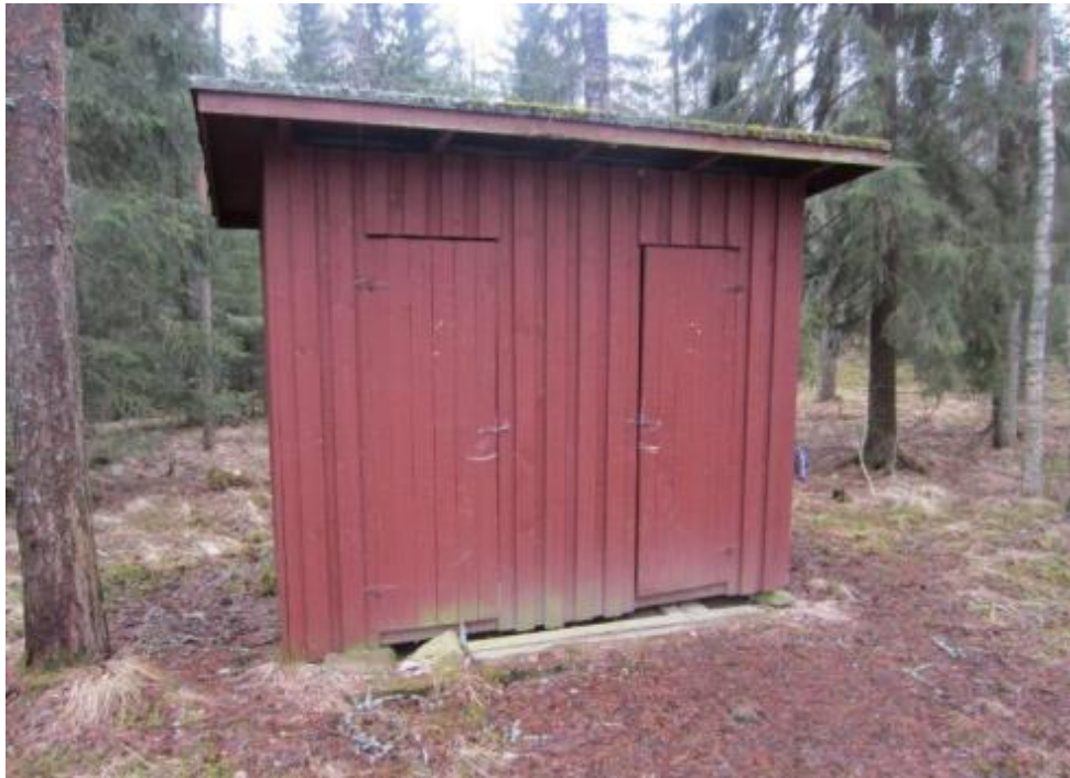
Kuva 71. Toivolahden päärakennuksen takamaastossa sijaitseva ulkokäymälä. Käymälä on perustettu kivien päälle. Käymälän seinien alaosat ovat vihertyneitä. Katto on sammaloitunut.
