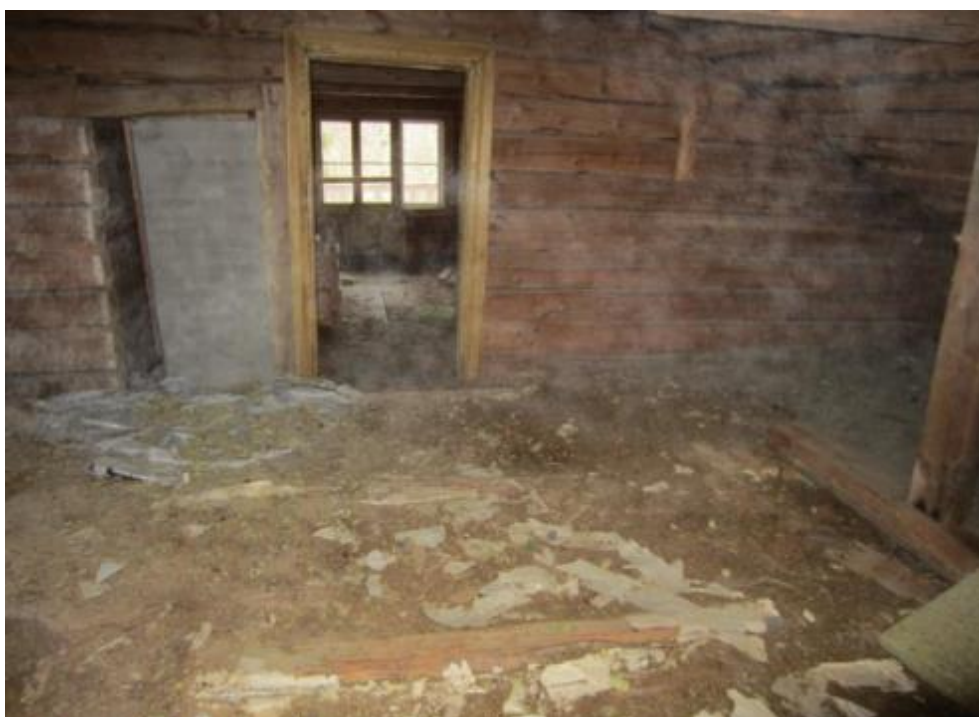
Kuva 81. Toivolahden päärakennuksen ullakkotilaan on lisätty eristeitä jälkeensä. Kulkusillat ovat puutteelliset.
