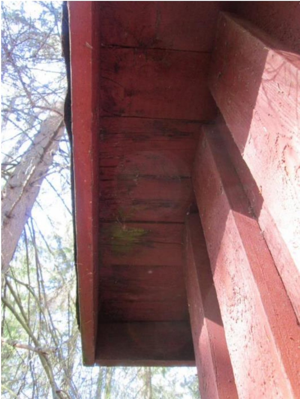
Kuva 14. Ulkokäymälän päädyn aluslaudoitus on vaurioitunut.
