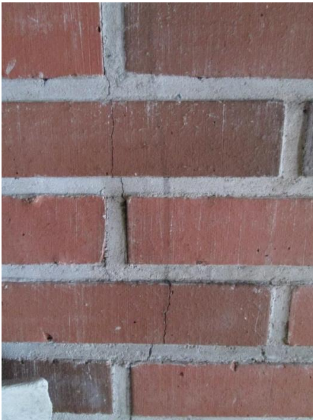
Kuva 66. Koskelan mökin tuvassa kaminan takana piipun muurauksessa on havaittavissa joitain hiushalkeamia.
