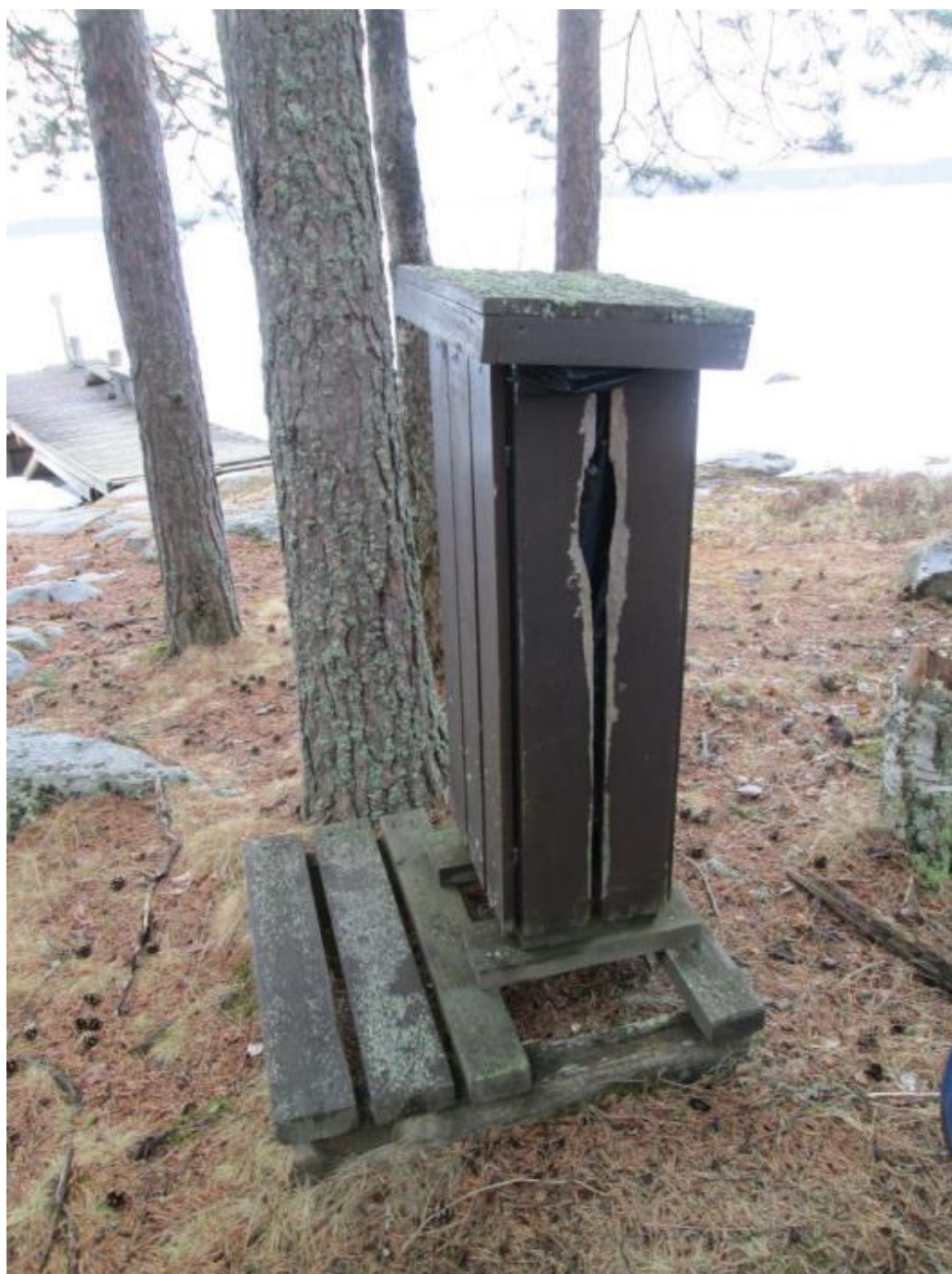
Kuva 47. Koskelan mökin puinen roska-astia. Roska-astian sivuille vaurioituneisiin kohtiin on lisätty rimat kesällä 2014. Kattolaudat ovat sammaloituneet.
