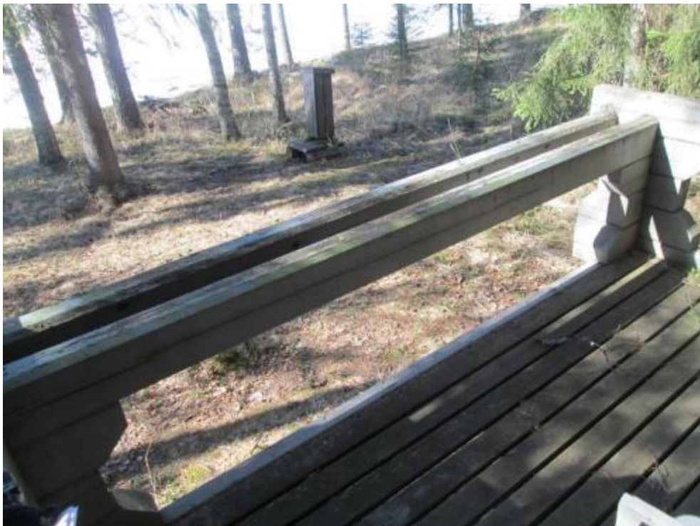
Kuva 18. Ulpukan mökin kaidehirret ovat kuluneet. Terassilla on puiden oksia.
