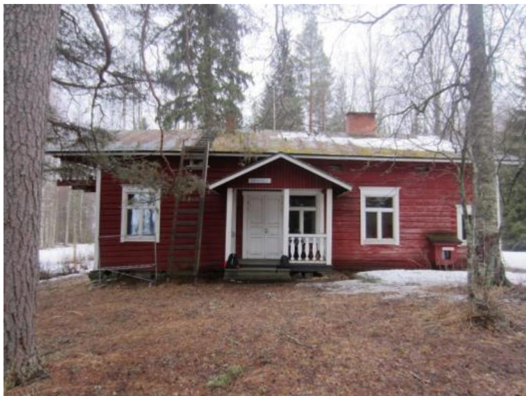
Kuva 69. Toivolahden päärakennus. Pihapiirissä on isoja puita. Kuvan etualalla on nähtävissä runsaasti oksia, havunneulasia ja koivunlehtiä.
