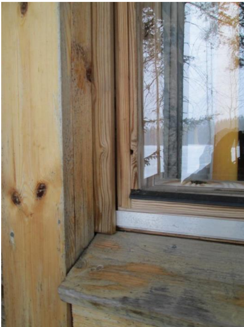
Kuva 33. Hevosnokan etuosan ikkunan pieli. Ulkopuolen ikkunarakenteissa ei ole ollenkaan pellityksiä. Ikkunalaudan pinta on kulunut.
