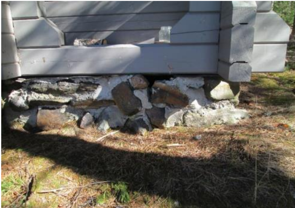
Kuva 19. Ulpukan mökin perustukset on rakennettu ulkoseinien kohdalla luonnonkivien ja laastin sekoituksena.
