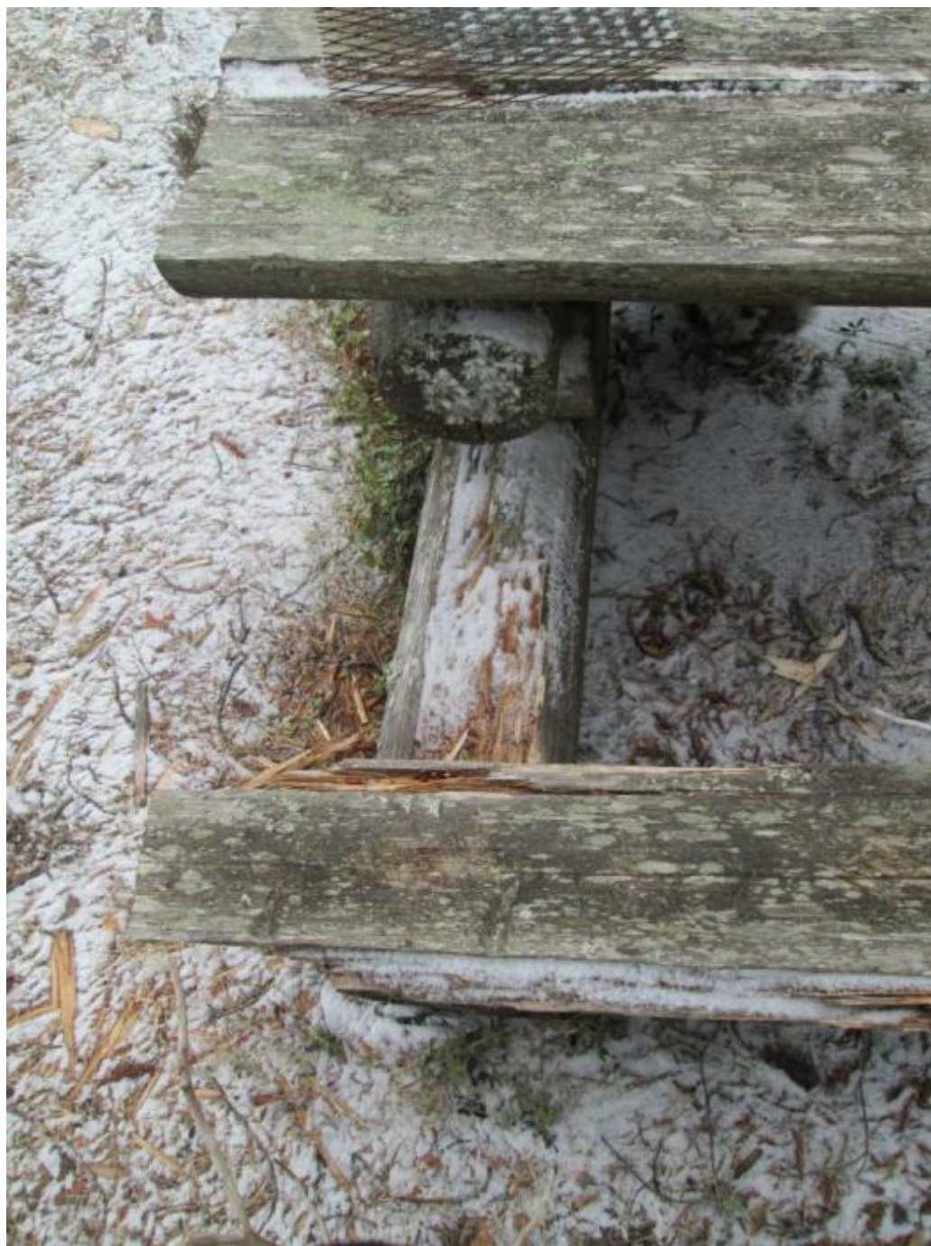
Kuva 26. Hevosnokaan pihapiirissä sijaitseva hirsistä tehty pöytäkalusto. Istuinpuut ovat pahoin vaurioituneita.
