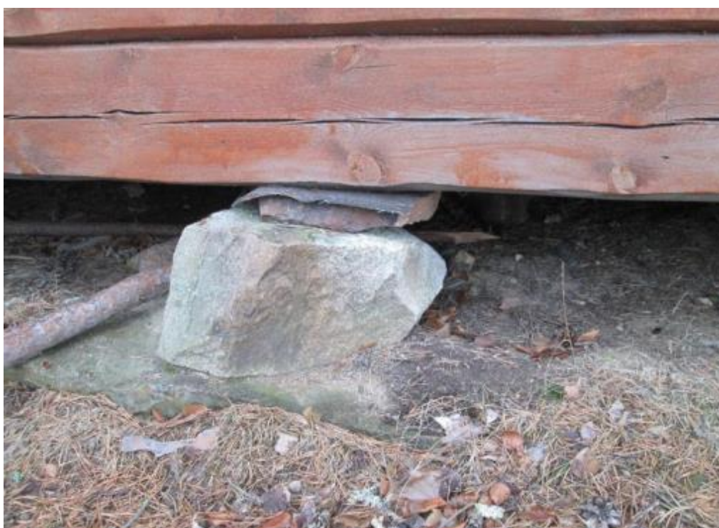
Kuva 53. Koskelan mökki on perustettu luonnonkivien päälle. Kapillaarikatkoina toimivat huopapalaset.
