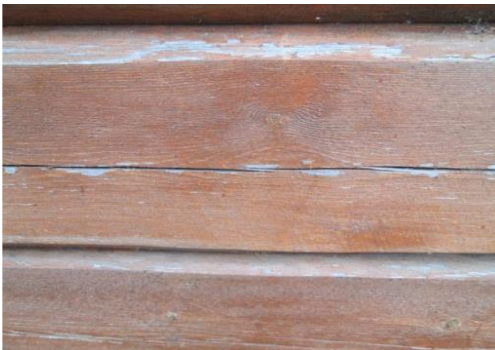
Kuva 56. Koskelan mökin ulkoseinäpinnoista on lohkeillut maalia ja seinien väri on haalistunut.
