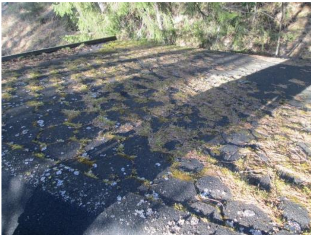
Kuva 23. Ulpukan mökin vesikatto. Katolle on kerääntynyt paljon havunneulasia. Sammalkasvusto on runsasta.
