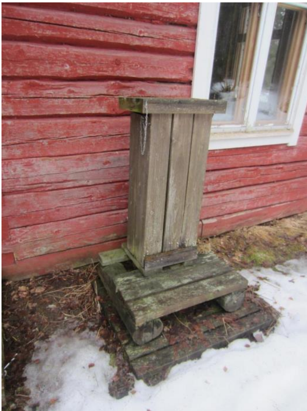
Kuva 70. Toivolahden päärakennuksen keittiön sisäänkäynnin lähetyvillä oleva roska-astia. Alimmat puut ovat värjäytyneitä ja niiden päälle on kertynyt koivunlehtiä. Pystylautojen maalipinta on kulunut.
