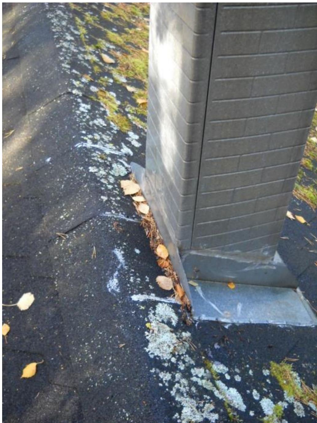
Kuva 24. Ulpukan mökin hormista puuttuu yläpuolen kaato. Roskat ja vesi kerääntyvät piipun yläjuureen.
