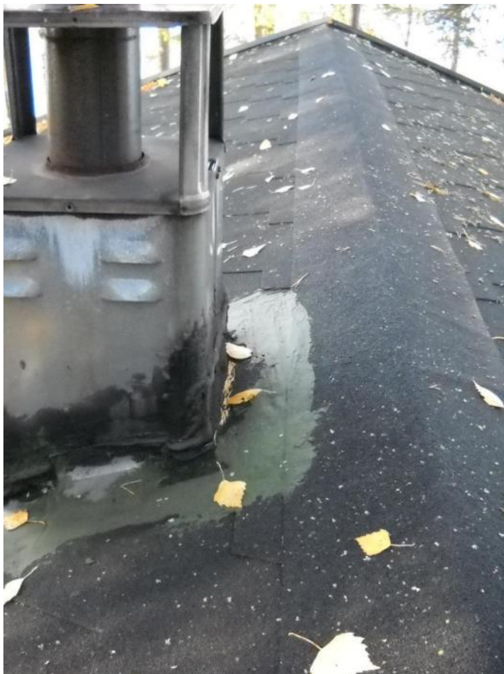
Kuva 37. Läpivientien yläjuurista puuttuvat kallistukset, jolloin vesi ja roskat kertyvät piipun juureen.
