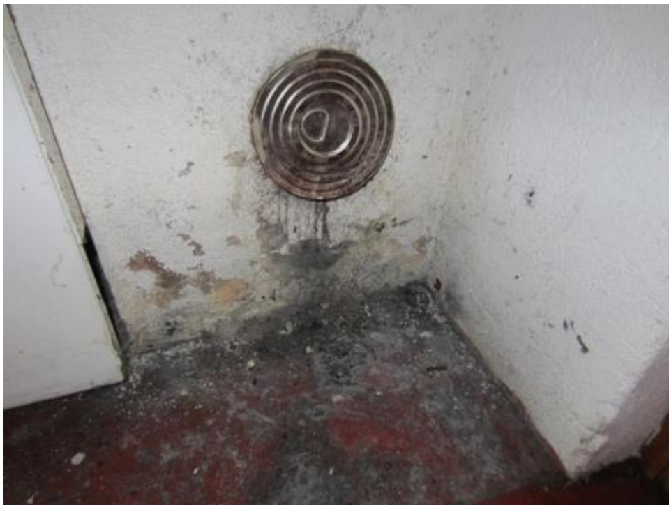
Kuva 90. Toivolahden päärakennuksen hormin tuhkaluukusta on valunut nokea ja tuhkaa lattialle.
