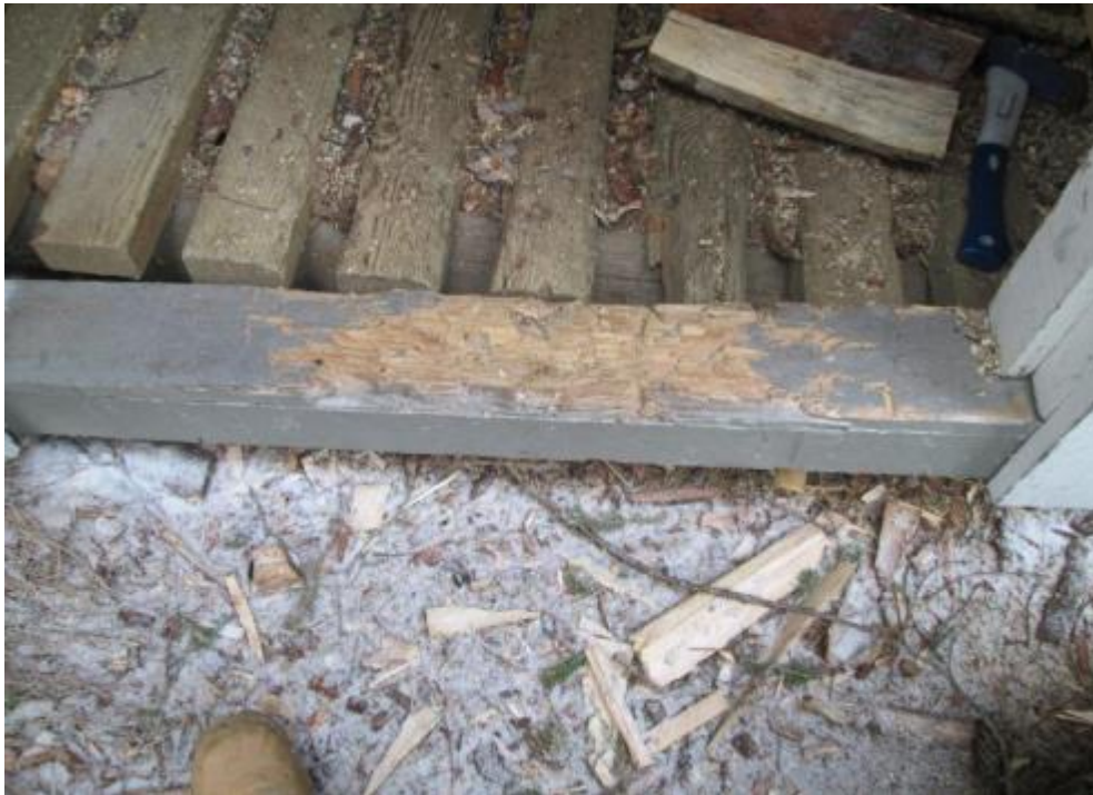
Kuva 29. Hevosnokan saunan polttopuuvaraston kynnyks on pahoin vaurioitunut. Kynnyksen päällä on todennäköisesti pilkottu polttopuita.
