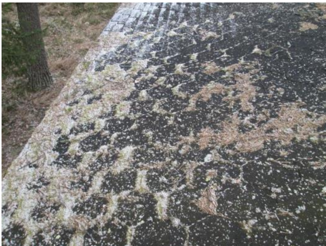
Kuva 36. Hevosnokan saunan huopakatteen päällä on runsaasti havunneulasia. Myös sammalkasvustoa esiintyy.
