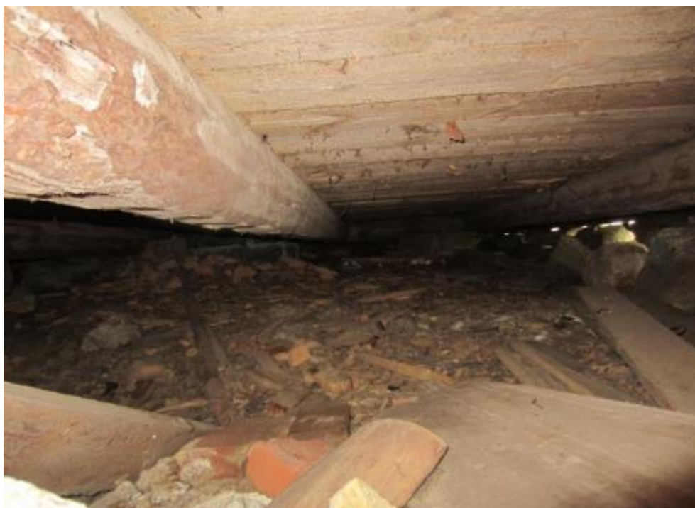
Kuva 79. Toivolahden päärakennuksen alapohjassa on rakennusjätettä, ylimääräisiä kiviä ja puunpalasia.
