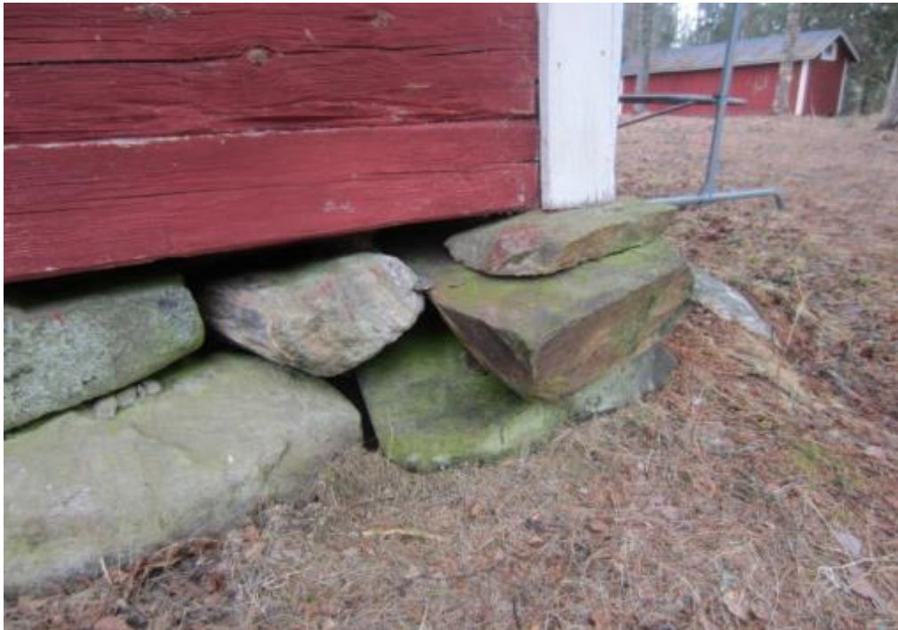
Kuva 77. Toivolahden päärakennus on perustettu kivien päälle. Kivet ovat vihertyneitä. Perustusten läheisyydessä on koivunlehtiä, havunneulasia ja oksia.
