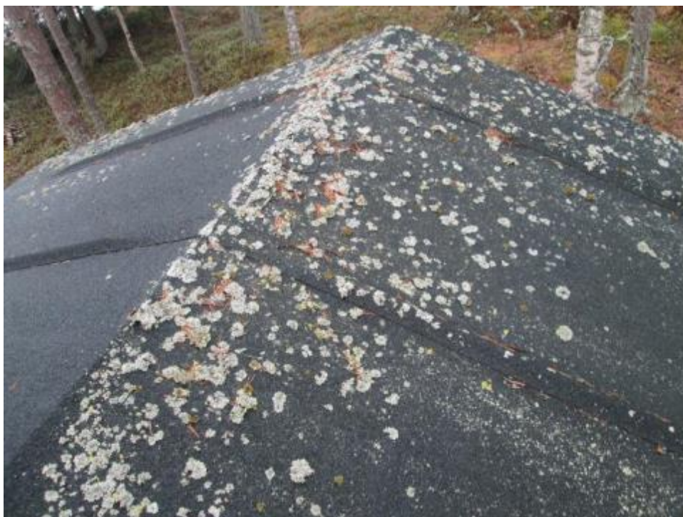
Kuva 60. Koskelan mökin huopakatteen päällä on sammalkasvustoa. Katolle on kertynyt myös havunneulasia.
