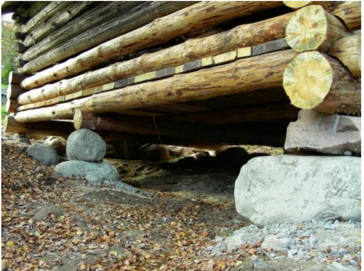
Kuva 5. Ladosta on kunnostettu alapohja- ja perustusrakenteet sekä vaihdettu alimpia hirsiiä. Perustuksien korjaamiseen on käytetty paljon luonnonkiviä. [11.]
