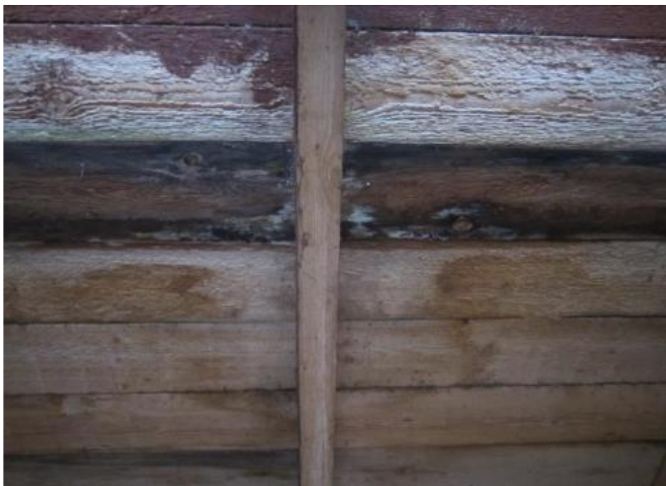
Kuva 72. Toivolahden ulkokäymälän aluslaudoitus on vaurioitunut todennäköisesti kattovuotojen seurauksena.
