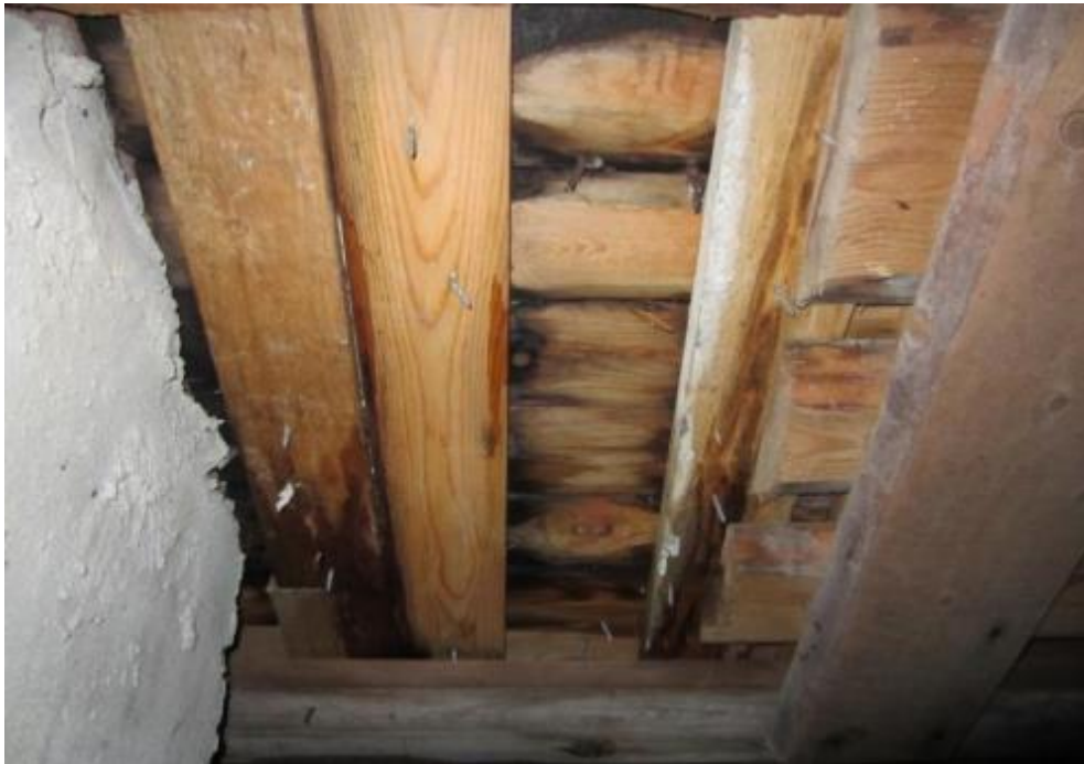
Kuva 87. Toivolahden päärakennuksen toisen piipun viereistä kattorakenteiden laudoitusta. Laudoitus on tummunutta johtuen todennäköisesti vesikatteen ja piipun läpivientien kehnosta kunnosta.
