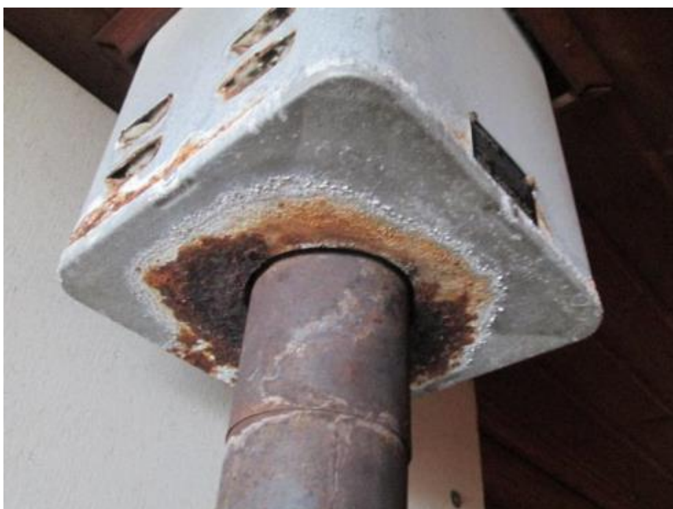
Kuva 42. Hevosnokan saunarakennuksen tuvan takka. Takan pinta on pahoin ruostunut.
