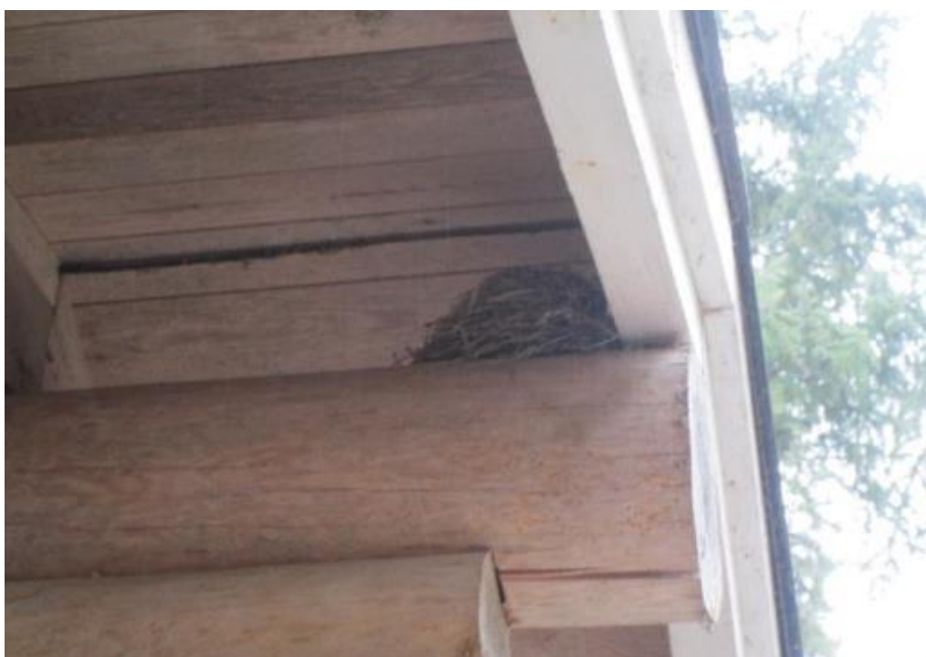
Kuva 35. Hevosnokan saunan takaosan räystäs. Lintu on rakentanut pesänsä ylimmän hirren päälle.
