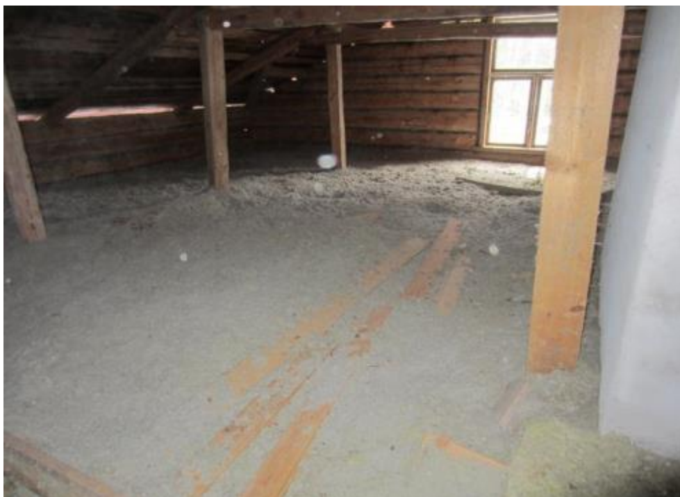
Kuva 81. Toivolahden päärakennuksen ullakkotilaan on lisätty eristeitä jälkeensä. Kulkusillat ovat puutteelliset.
