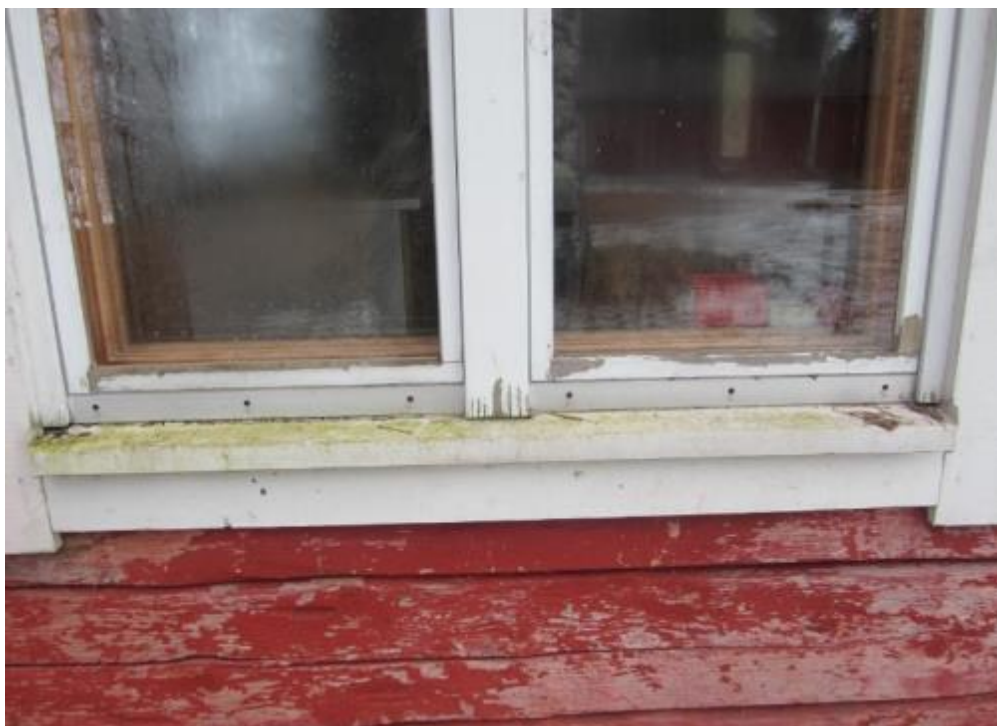
Kuva 83. Toivolahden päärakennuksen ulkoseinien maalipinnat ovat paikoin kuluneet. Joidenkin hirsien välissä on isoja rakoja.
