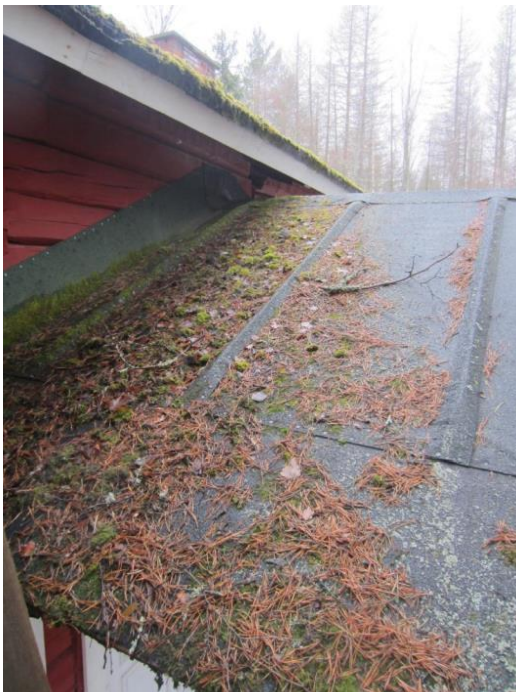
Kuva 76. Toivolahden päärakennuksen kuistin katteen päällä on runsas sammal- kasvusto. Sammaleeseen on tarttunut oksia ja havunneulasia.
