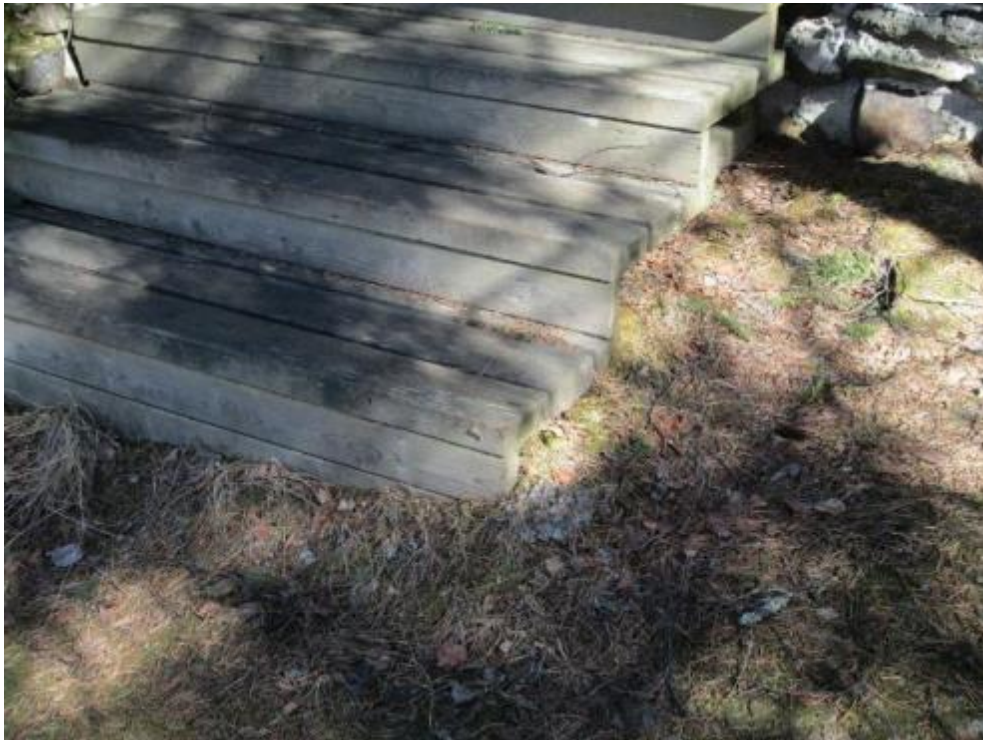
Kuva 17. Ulpukan mökin portaat ovat osittain maan sisässä ja roskien peitossa. Porrasaskelmat ovat kuluneet.
