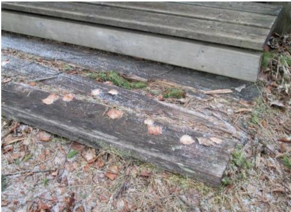
Kuva 29. Hevosnokan saunan polttopuuvaraston kynnyks on pahoin vaurioitunut. Kynnyksen päällä on todennäköisesti pilkottu polttopuita.
