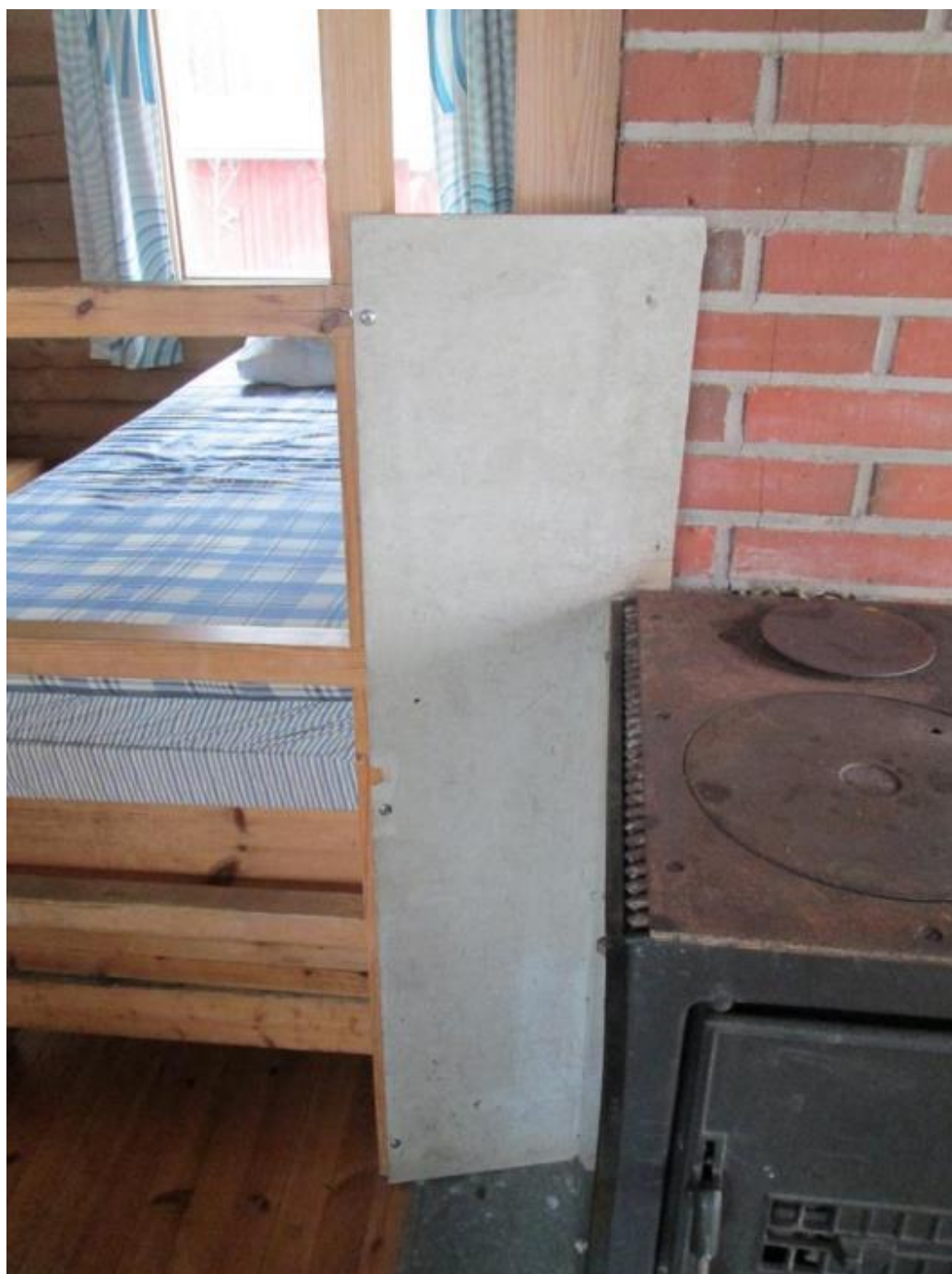
Kuva 65. Koskelan mökin tuvassa sänkyjen suojaksi on asennettu palonsuojalevy.
