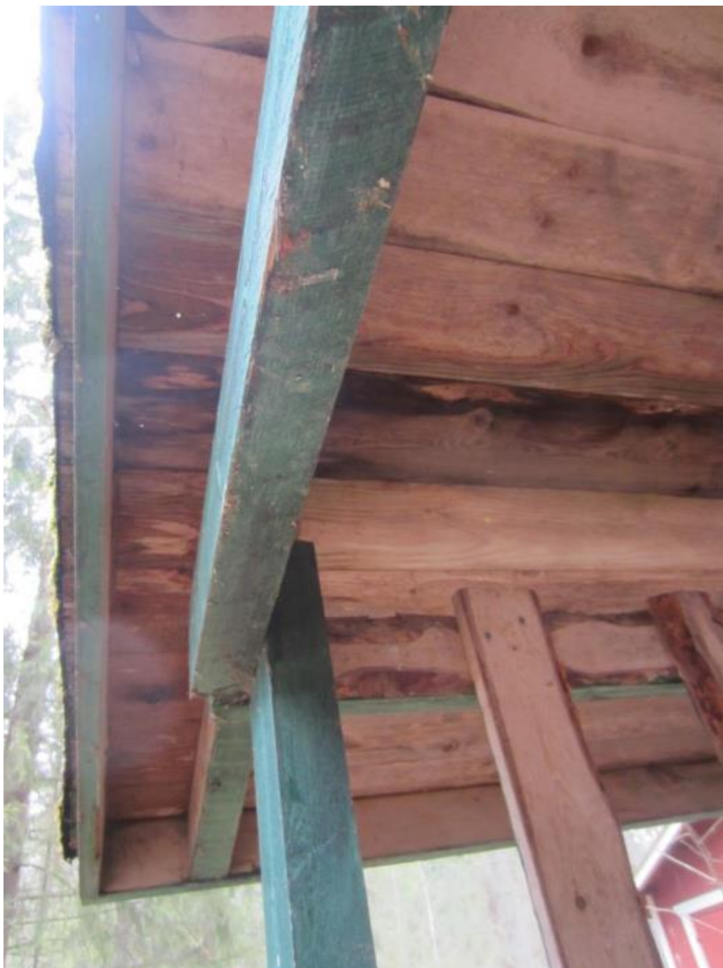
Kuva 74. Toivolahden alueen vihreäksi maalatun polttopuukatoksen aluslaudoituksessa on tummuneita kohtia.
