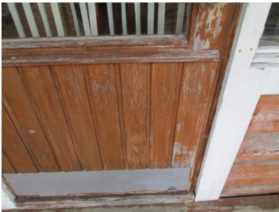
Kuva 58. Koskelan mökin tuvan ulko-ovi. Puuosien maalipinnat ovat huonossa kunnossa.
