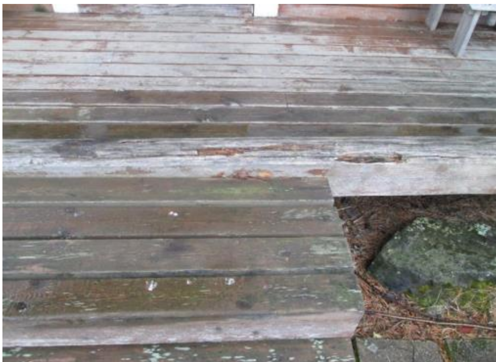
Kuva 52. Koskelan mökin terassia kannattava hirsi on vaurioitunut keskiosasta. Terassilaudoituksen maalipinta on erittäin kulunut.
