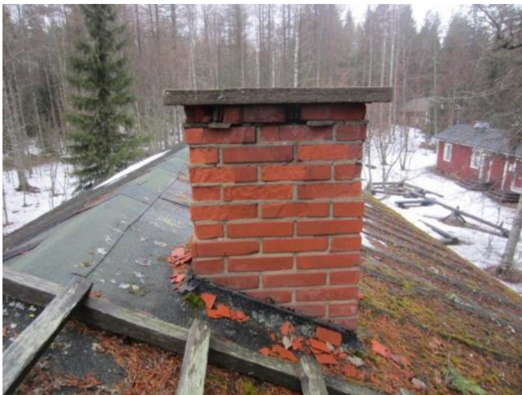
Kuva 93. Toivolahden päärakennuksen savupiiput ovat vaurioituneita yläosista. Tiilenpalasia on pudonnut katolle. Piipun päässä ei ole piipunhattua, jolloin sadetta pääsee satamaan suoraan savuhormiin.
