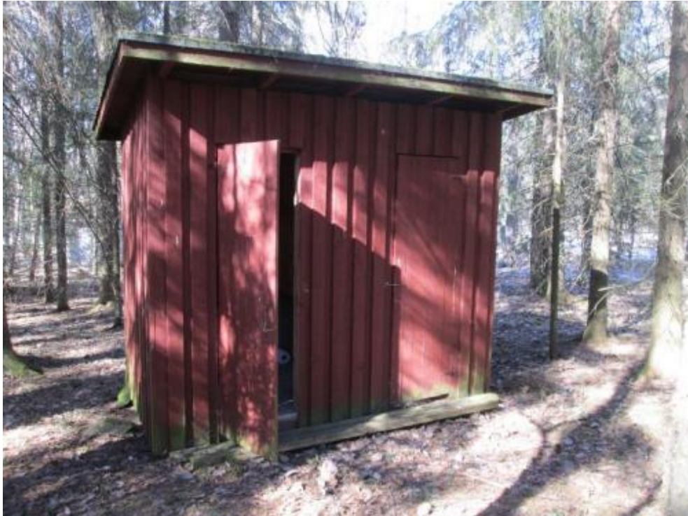
Kuva 15. Ulpukan mökin lähellä metsikössä oleva ulkokäymälä. Käymälän seinien alaosat ovat vihertyneet ja katto on sammaloitunut.
