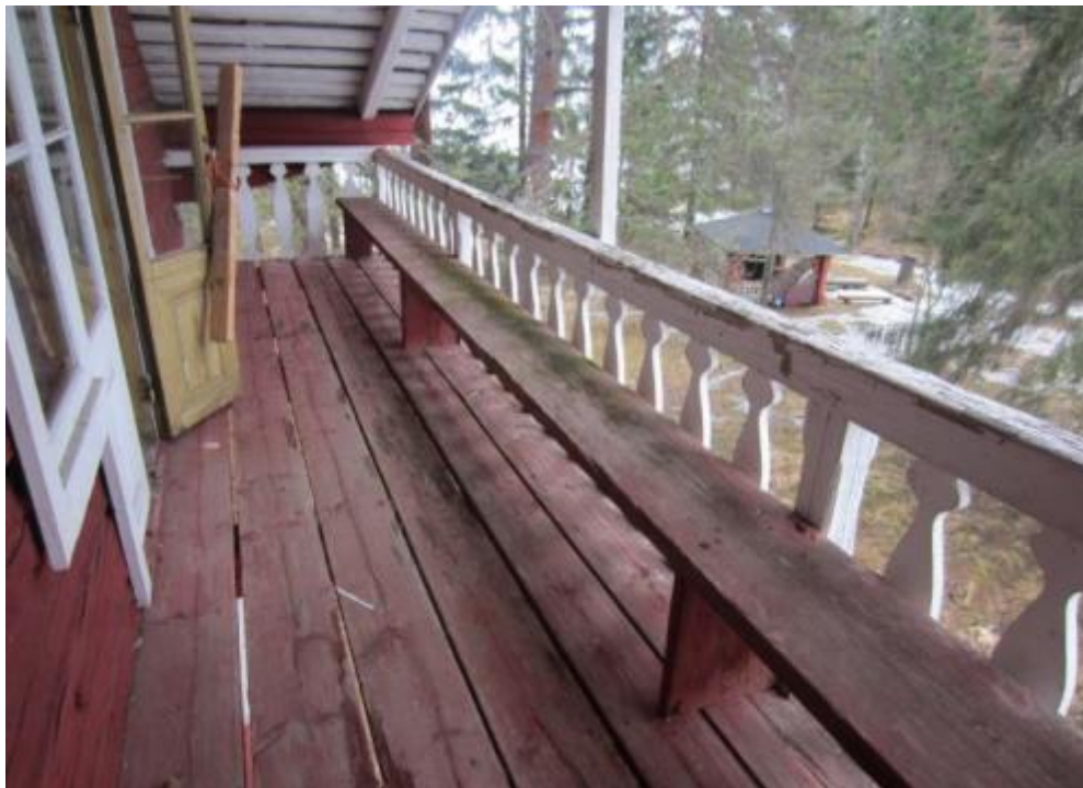
Kuva 86. Toivolahden päärakennuksen puurakenteinen parveke. Kaidehirren, lattiaankkujen ja istuinpuiden maalipinnat ovat kuluneet.
