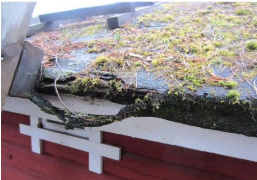
Kuva 88. Toivolahden päärakennuksen räystäiden huopataitokset ovat osittain erittäin kehnossa kunnossa. Jo kuvasta on nähtävissä lahonnutta laudoitusta. Kate ylempänä on erittäin roskainen.
