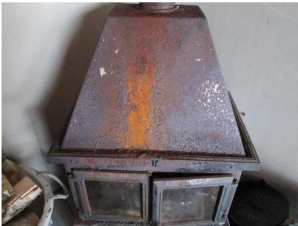
Kuva 42. Hevosnokan saunarakennuksen tuvan takka. Takan pinta on pahoin ruostunut.
