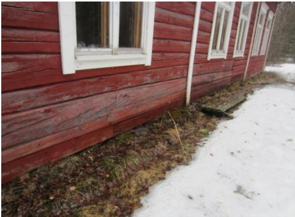
Kuva 68. Toivolahden päärakennuksen takaseinustan maanpintojen kallistukset ovat puutteelliset. Katolta pudonnut vesi on ajan saatossa kuluttanut maanpintaan selvän uran. Seinustalle on lisäksi jätetty puinen ritilä, josta osa putoavasta vedestä kimpoaa seinälle.
