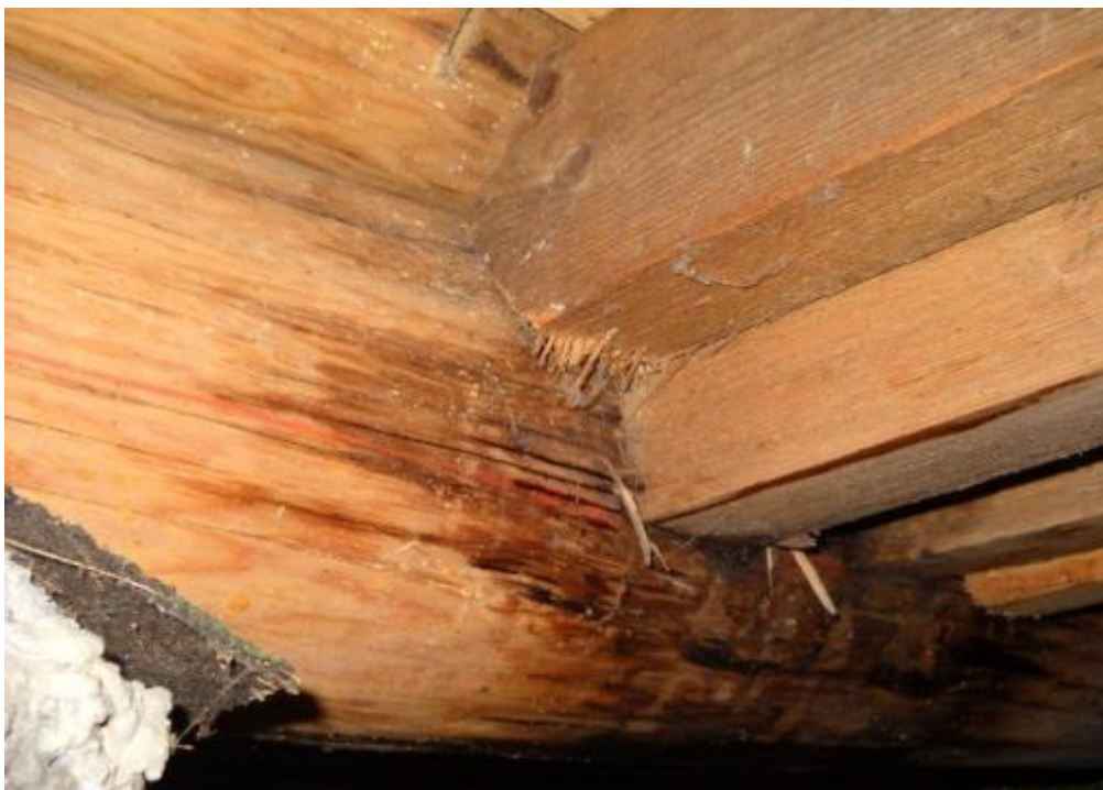
Kuva 32. Hevosnoka saunan alapohja. Kantavien hirsien ja saunan lattiarakenteen liitoksessa on kosteusvaurio.
