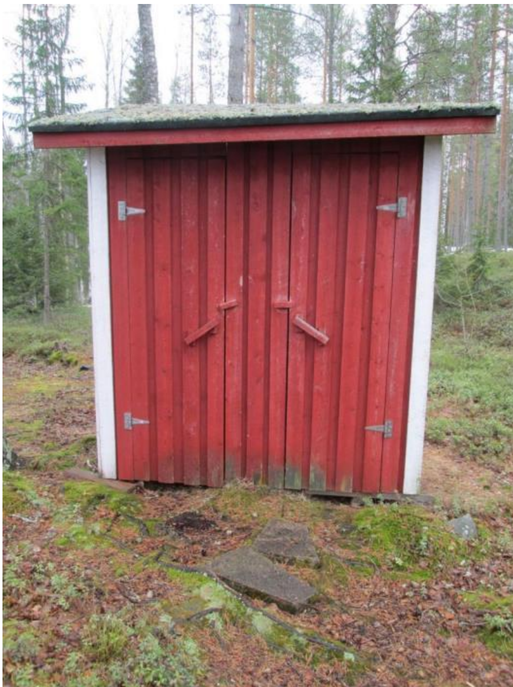
Kuva 46. Koskelan mökin ulkokäymälä. Seinien alaosat ovat hyvin lähellä maanpintaa. Katolla on runsas sammalkasvusto. Katto on vino. Etuosalla laudoituksen alaosassa on väärytymistä ja kosteutta.
