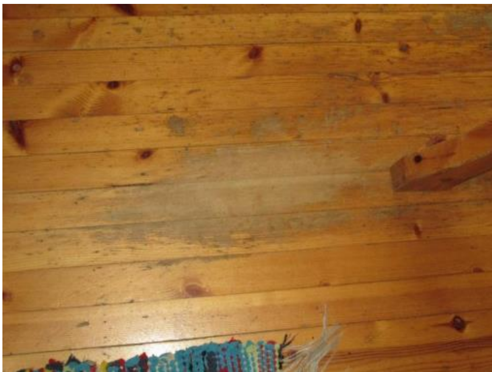
Kuva 62. Koskelan mökin tuvan lattia on kulunut pöydän ja kaminan lähistöltä.
