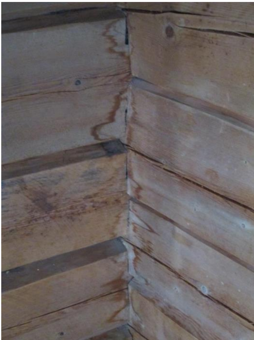
Kuva 64. Koskelan tuvan sisänurkissa on havaittavissa värjäytymistä, joka johtuu todennäköisesti kosteudesta.
