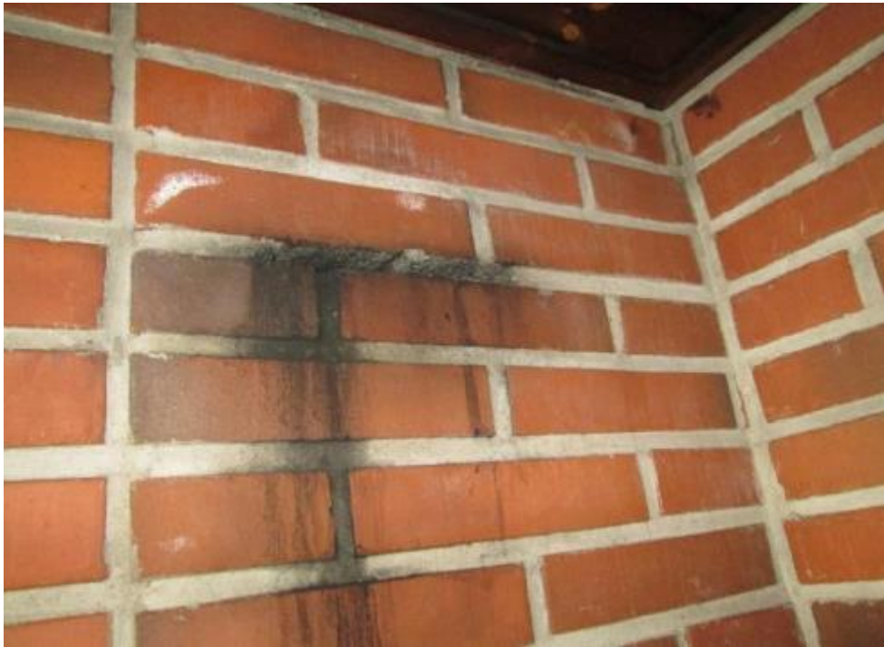
Kuva 67. Koskelan saunasta puuttuu hormipelti. Noki on valunut seinälle.
