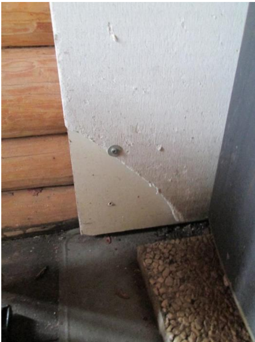
Kuva 38. Hevosnokan saunan kiukaan takana olevasta palonsuojalevystä on lohjennut palanen.
