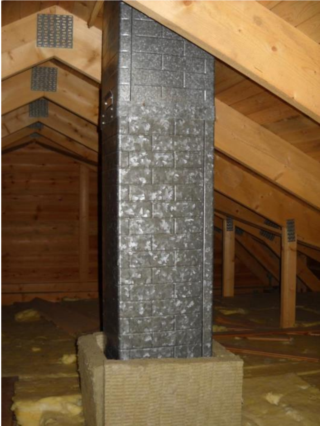
Kuva 21. Ulpukan mökin hormia ei ole eristetty vesikattorakenteisiin asti. Villojen päällä on laudan- ja villojen palasia.
