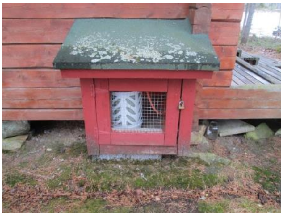
Kuva 59. Koskelan mökin kaasupullokaappi. Huopakatteen päällä on sammalkasvustoa. Alimmaisten puiden maalipinta on kulunut.
