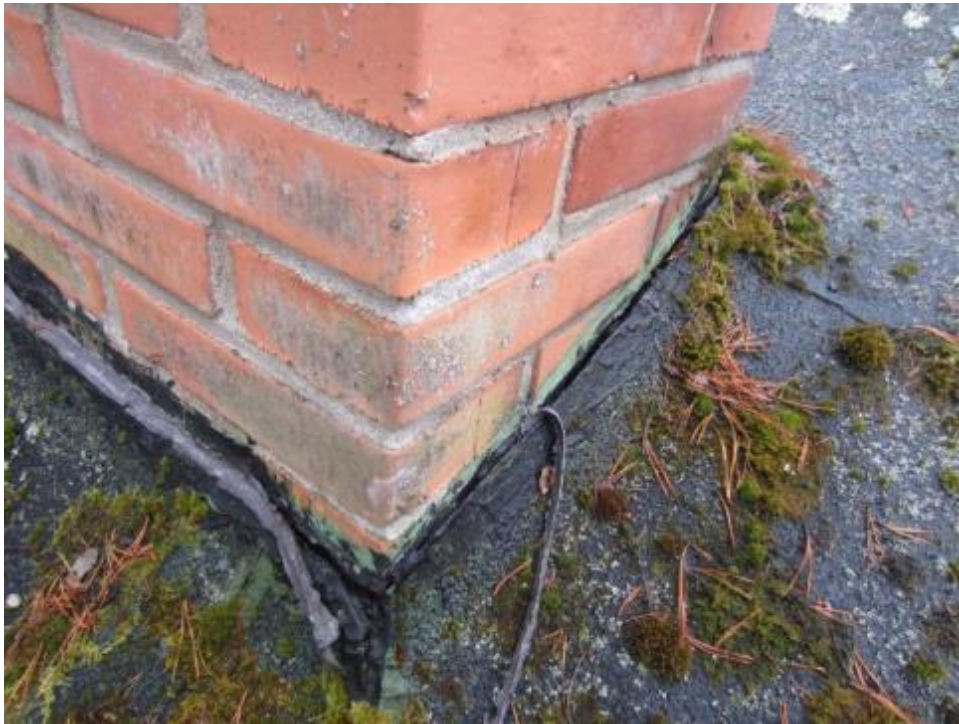
Kuva 89. Toivolahden päärakennuksen piippujen läpivientien tiivistykset ovat erittäin kehnoissa kunnossa ja osittain irronneet. Katteen päällä on runsas sammalkasvusto.
