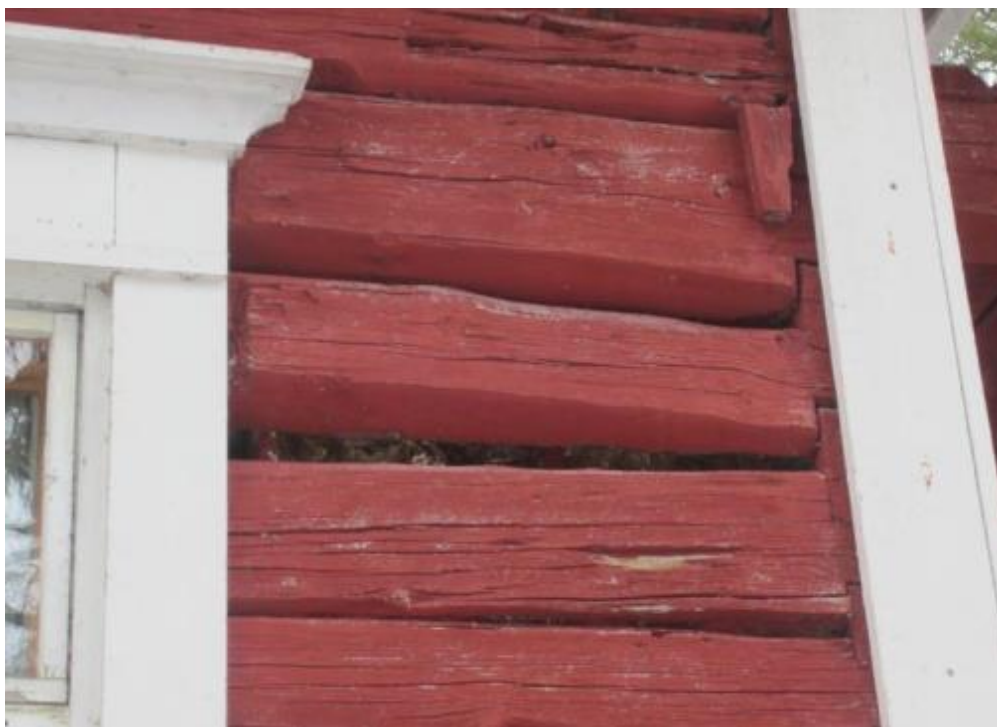
Kuva 83. Toivolahden päärakennuksen ulkoseinien maalipinnat ovat paikoin kuluneet. Joidenkin hirsien välissä on isoja rakoja.
