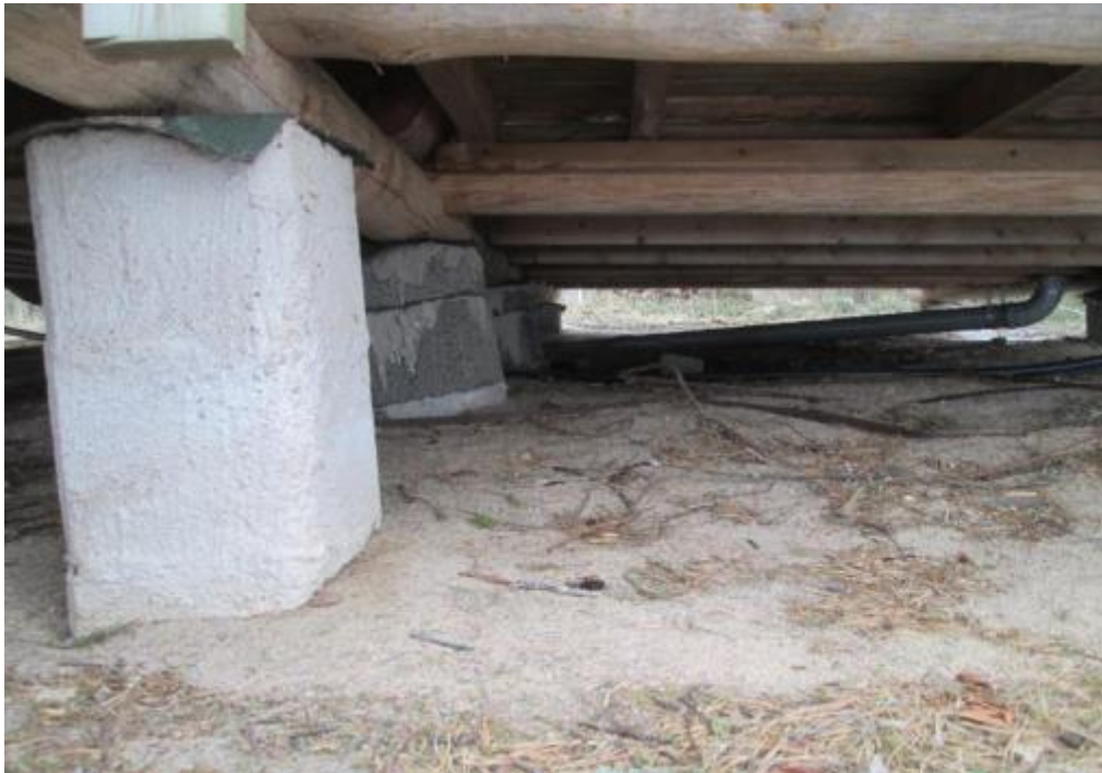
Kuva 31. Hevosnoka saunarakennuksen alapohja kuvattuna keskeltä rakennusta. Taaempana kuvassa näkyvät pilariharkot ovat vinossa. Alapohjassa on lisäksi puuroskaa.
