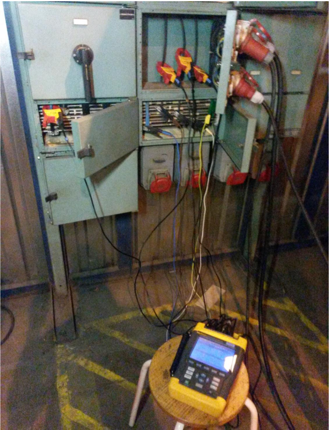
Kuva 18. Fluke -energia-analysoija kytkettynä 63 A:n keskukseen mittausta varten.
