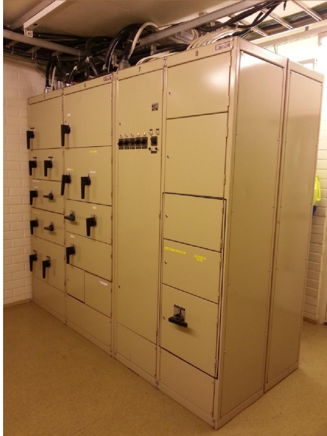
Kuva 7. Ilmalan sähkötalon kennomallinen pääkeskus.
