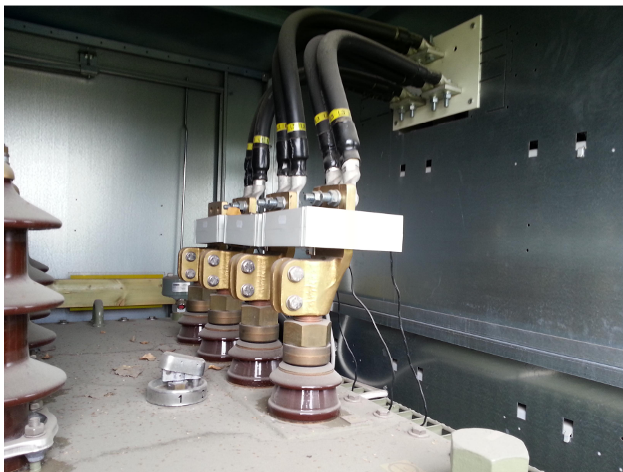
Kuva 3, Mittamuuntajat 20/0,4 kV muuntajan toisiopuolella
