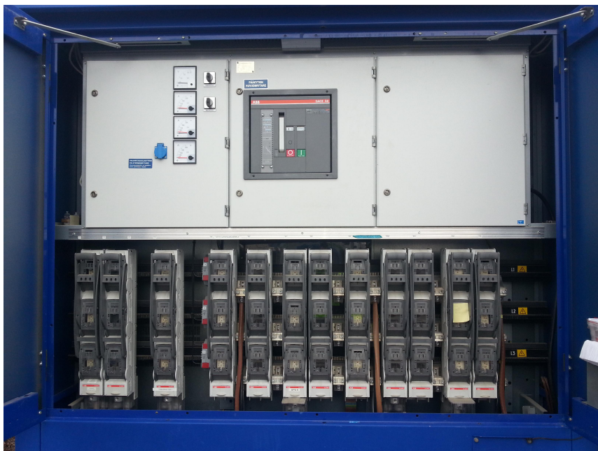
Kuva 8. Erään Ilmalan puistomuuntamomallisen muuntamon pienjännitepuolen pääkeskus
