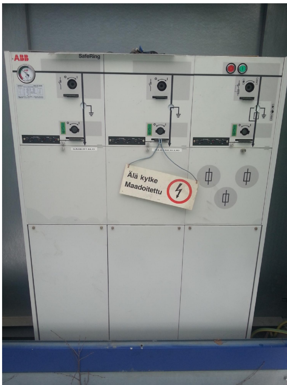
Kuva 5. Kaasueristeinen kojeisto. Erään Ilimalan verkon puistomuuntamon kennosto.
