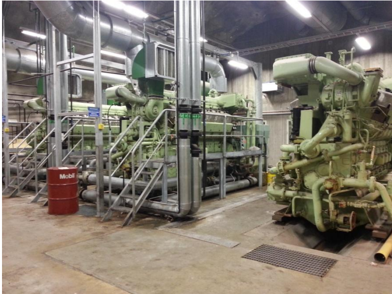
Kuva 1. Haarakallion kolme 2 400 kVA -dieselgeneraattoria.
