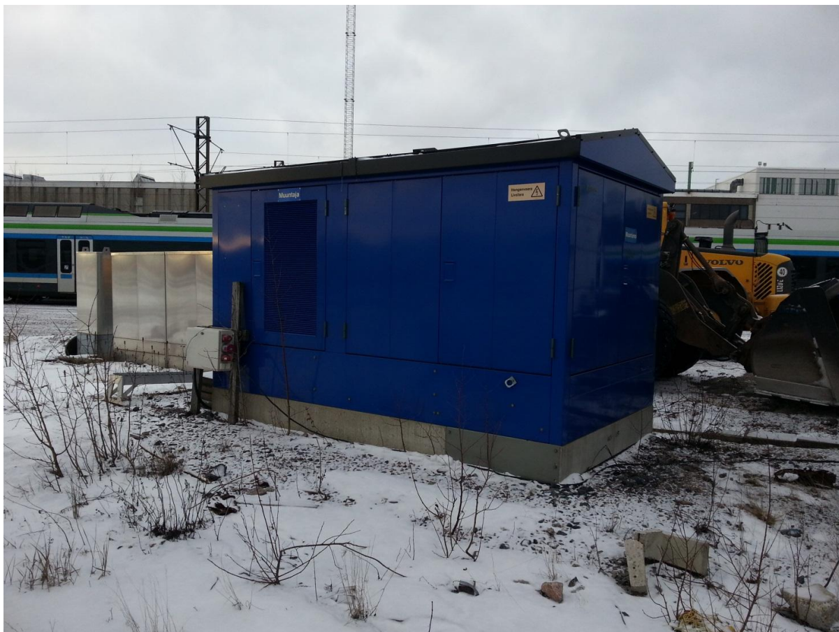
Kuva 10. Eräs Ilmalan verkon puistomuuntamomallisista muuntamoista.
