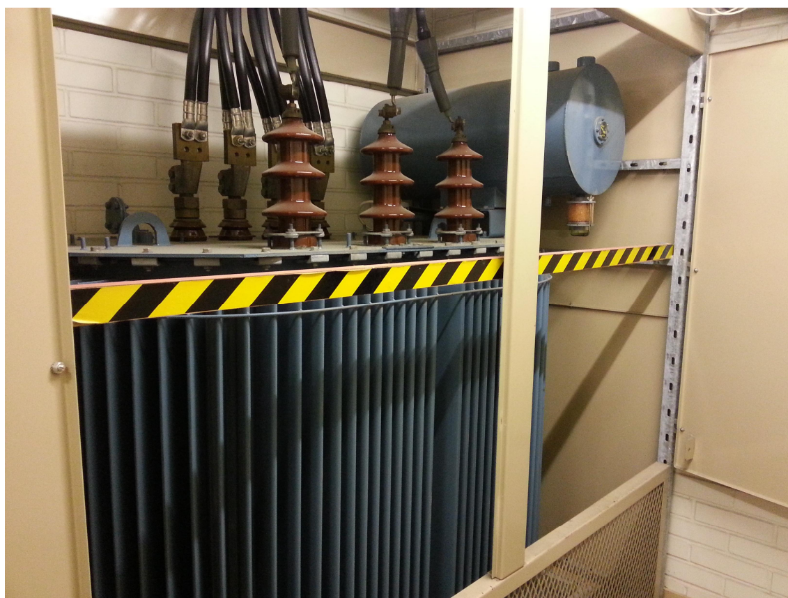
Kuva 2. Erään sisämuuntamon 20/0,4 kV 800 kVA muuntaja
