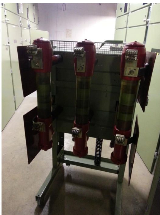
Kuva 6, Käytöstä poistunut vähäöljykatkaisija Haarakalliossa
