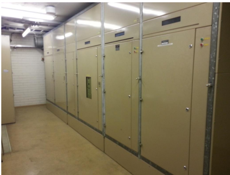
Kuva 4, Koteloitu kojeisto. Erään Ilmalan verkon rakennuksen sisällä sijaitsevan muuntamon kenno.
