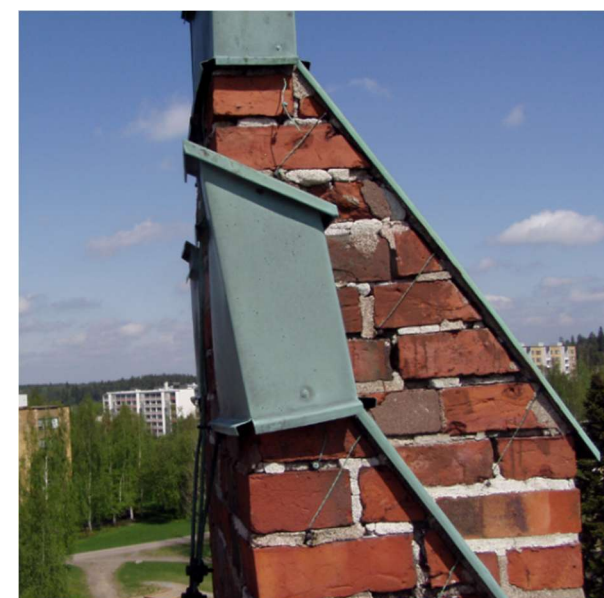
Kuva 61 (vas. ylä). Kellotornin huipun tiilien pakkasrapautuma. Kuva 62 (vas. ala). Kellotornin sisärappauksen vauriot. Kuva 63 (oik. ylä). Kellotornin eteläjulkisivun tiilien pakkasrapautuman havaintoja. Kuva 64 (oik. ala). Koristemuurausten vaurioita. (Maja & Koskinen 2005)
