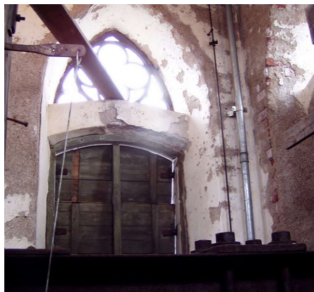
Kuva 61 (vas. ylä). Kellotornin huipun tiilien pakkasrapautuma. Kuva 62 (vas. ala). Kellotornin sisärappauksen vauriot. Kuva 63 (oik. ylä). Kellotornin eteläjulkisivun tiilien pakkasrapautuman havaintoja. Kuva 64 (oik. ala). Koristemuurausten vaurioita. (Maja & Koskinen 2005)
