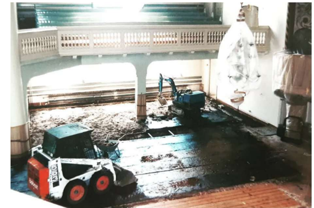
Kuva 57. Kirkkosali peruskorjauksen aikana (Forssan seurakunta n.d.).
