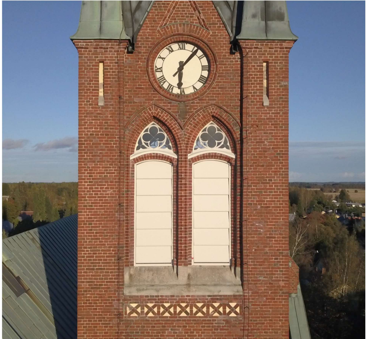
Kuva 73. Kellotorniin vuonna 2021 asennetut alumiiniset soittoluukut.
