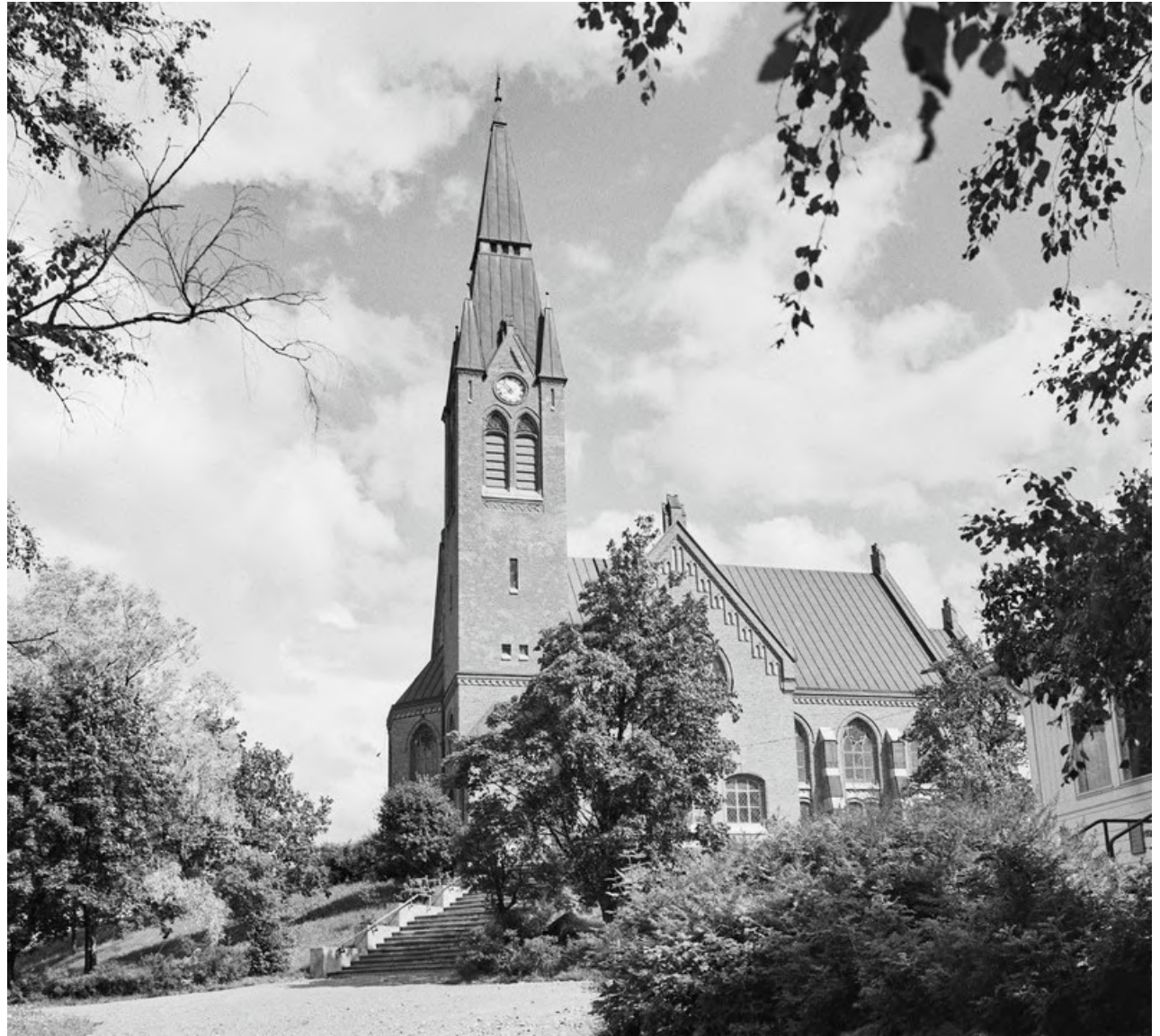
Kuva 32. Forssan kirkko 1950-luvun julkisivukorjauksen sekä kellotaulujen ja kuparikaton lisäämisen jälkeen (Pekka Lyytinen 1960–1969).
