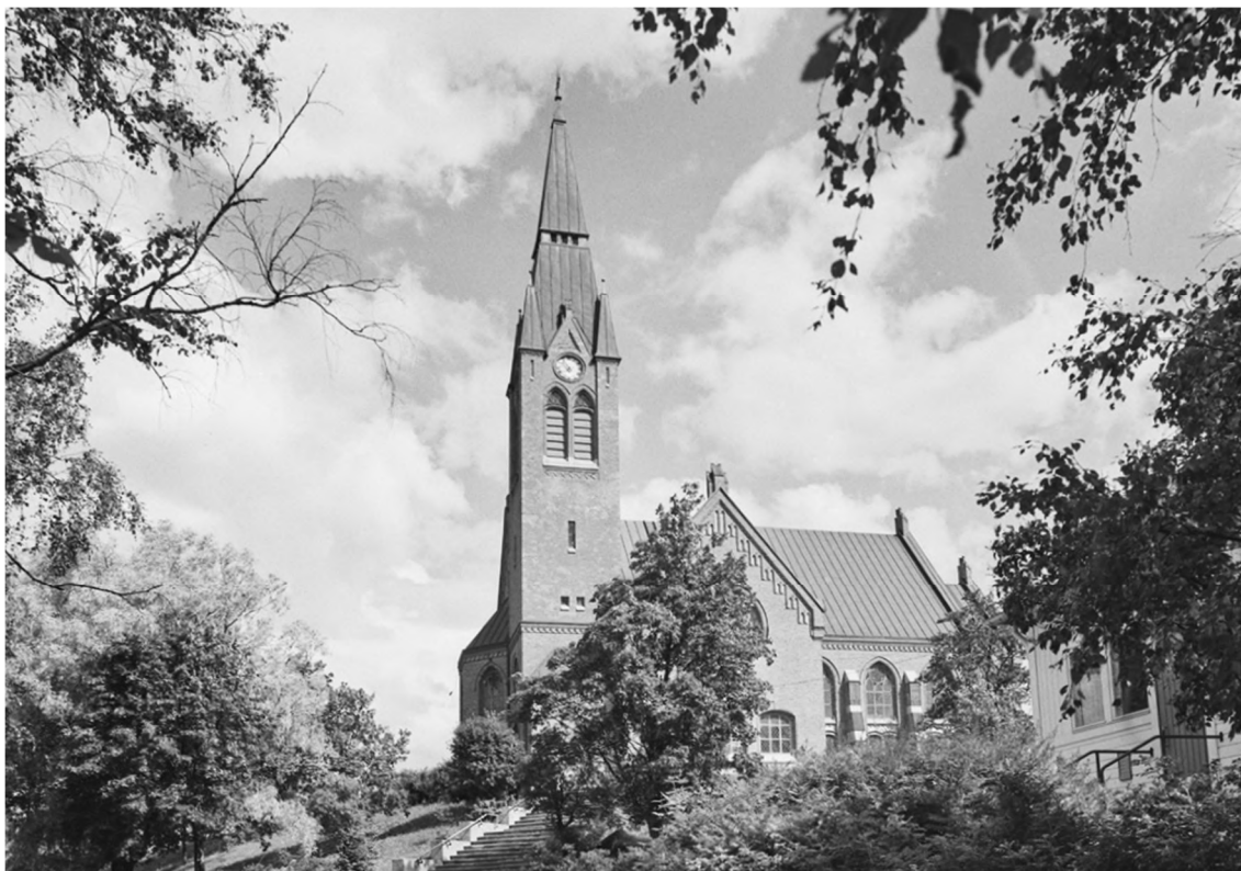
KUVA 59. Forssan kirkko 1950-luvun julkisivukorjauksen sekä kellotaulujen ja kuparikaton lisäämisen jälkeen (Kuva: Pekka Lyytinen 1960–1969).
