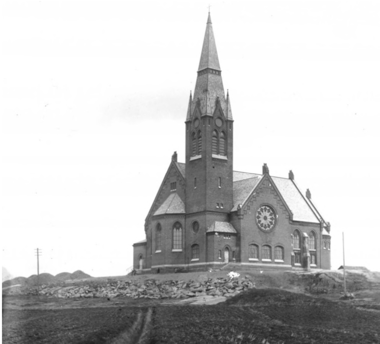
Kuva 27. Pihatyöt olivat vielä kesken kirkon vihkimisjuhlan aikana vuonna 1918 (Valokuvaamo Hellas 1920).
