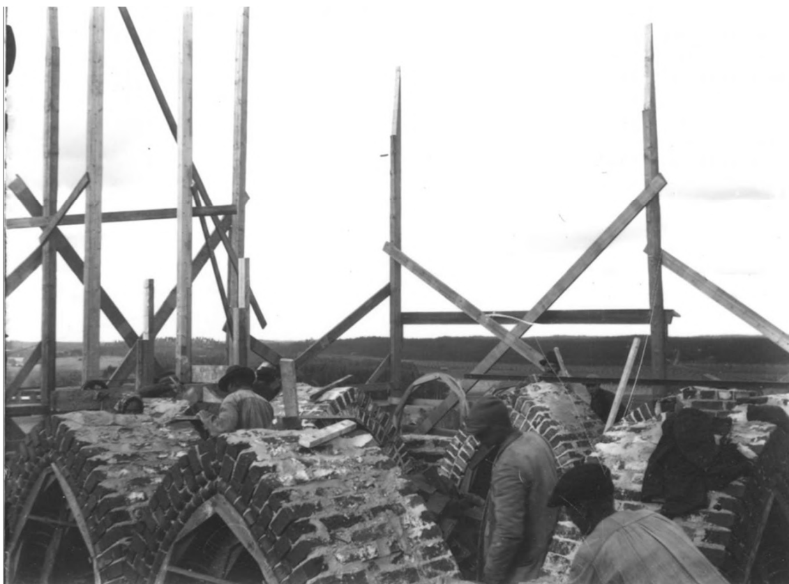
KUVA 49. Kirkon kellotornin soittoluukkujen muuraustyöt vuosina 1916–1917 (Kuva: Esko Aaltonen n.d.).
