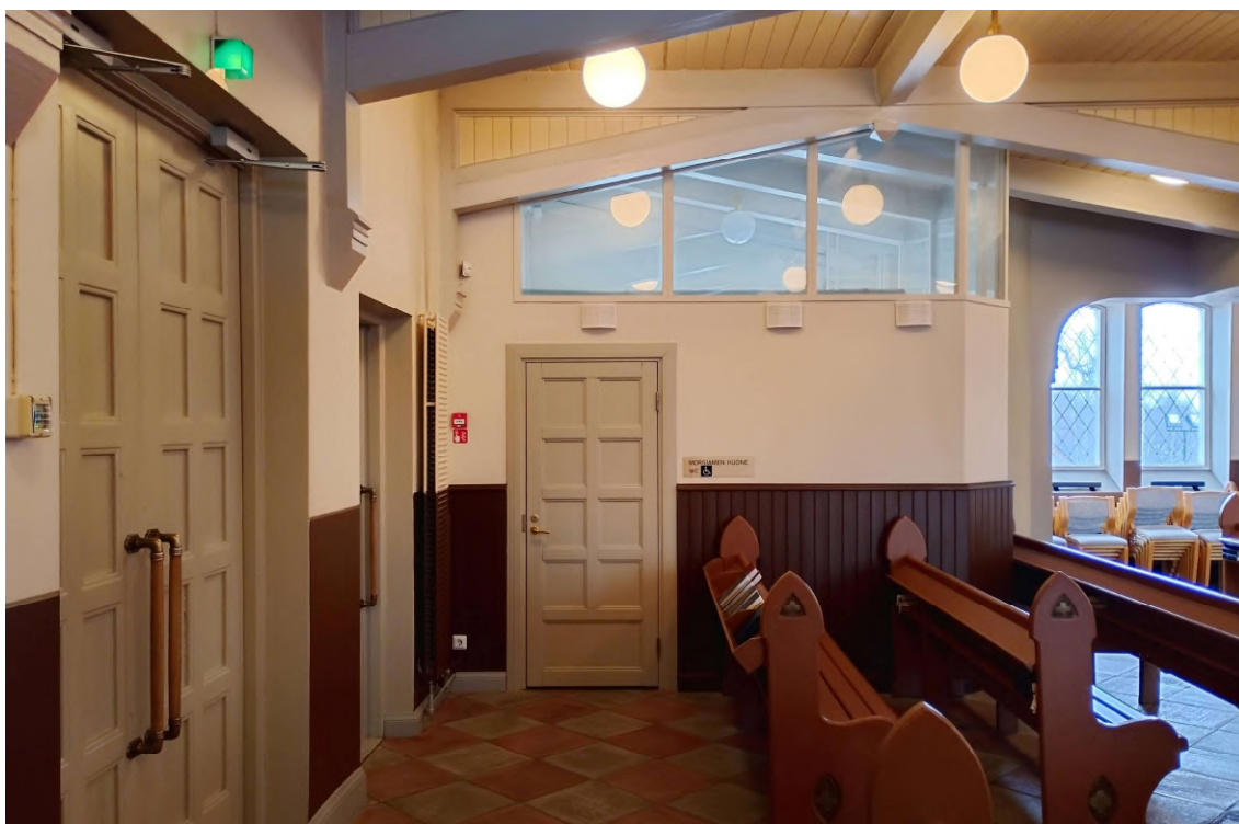
KUVA 85. Peruskorjauksessa kirkkosaliin lisätty aputila, jossa sijaitsevat WC ja morsiushuone (Kuva: Joonas Saarela 2025).
