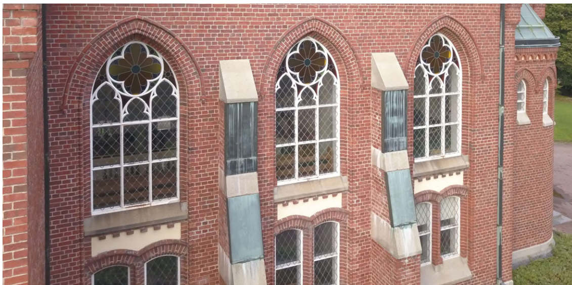
KUVA 42. Kirkon ulkonevat tukipilarit sekä koristeelliset ruusu- ja suippokaari-ikkunat ovat uusgoottilaisen tyylin piirteitä (Kuva: Joonas Saarela 2025).
