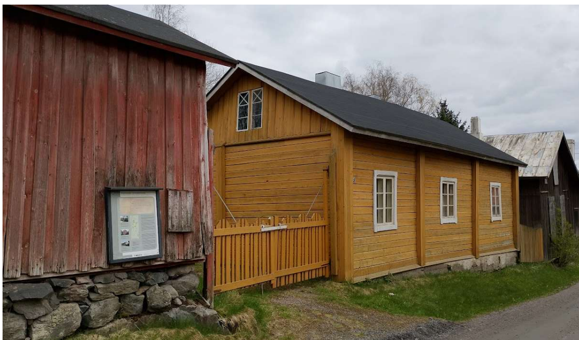
KUVA 32. Kalliomäen II-linjalla sijaitseva museokortteli perustettiin vuonna 1973 (Kuva: Joonas Saarela 2025).
