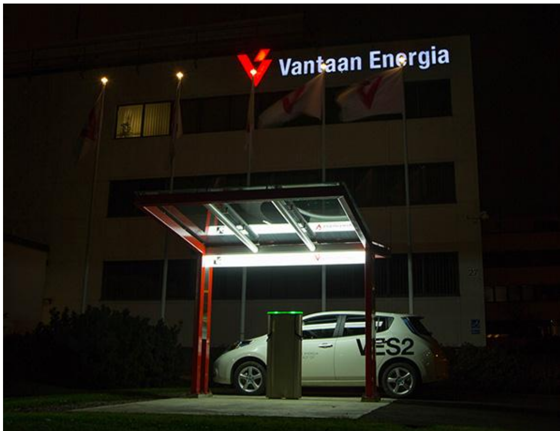
Kuva 2. Sähköautojen latauspiste VE:n toimitalon edessä [4].
