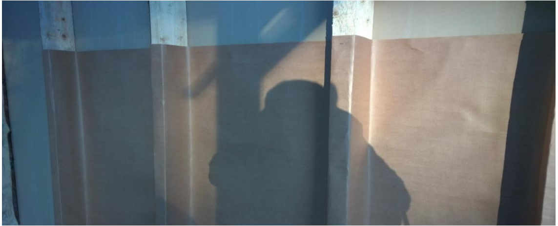
Kuva 7.1. Ilmansulkupaperi on asennettuna Gyproc-levyn ulkopintaan.
