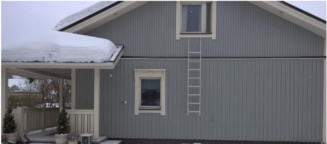
Kuva 7.3. Kuvassa pohjoisen puoleinen päätyseinä.
