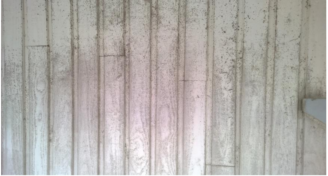
Kuva 1. Mikrobikasvustoa ulkoverhouksessa.
