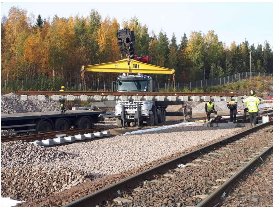
Kuva 1. Rataelementin asennus. (1)
