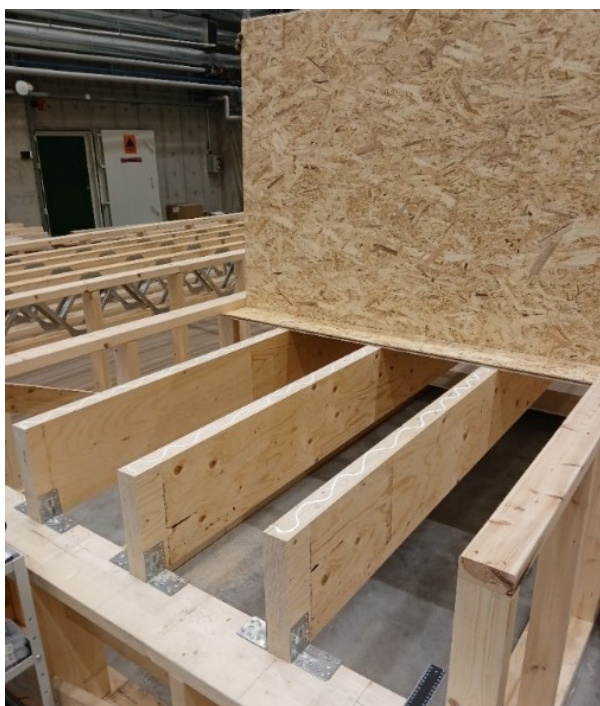
Kuva 38. Levytyksen huolellinen kiinnittäminen liimalla (kuva: Niko Kinnunen 2025)
