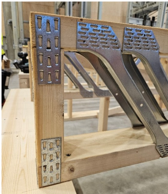
Kuva 20. Easi-joist®-palkin kiinnitys alapaarteesta vinoruuviliitoksella
