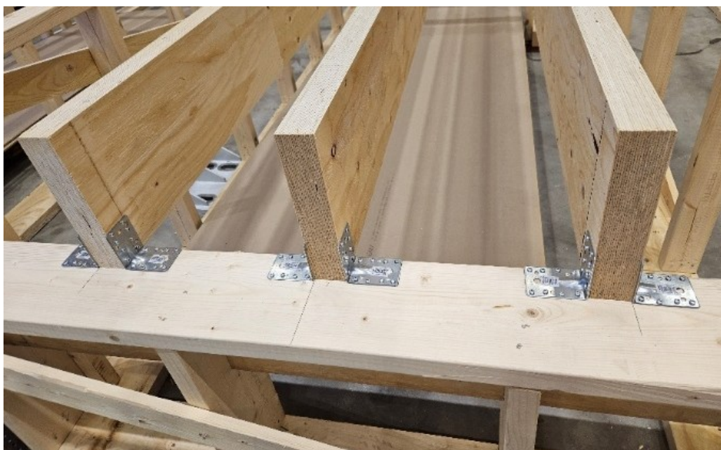
Kuva 16. LVL 48 P -palkit asennettuna
