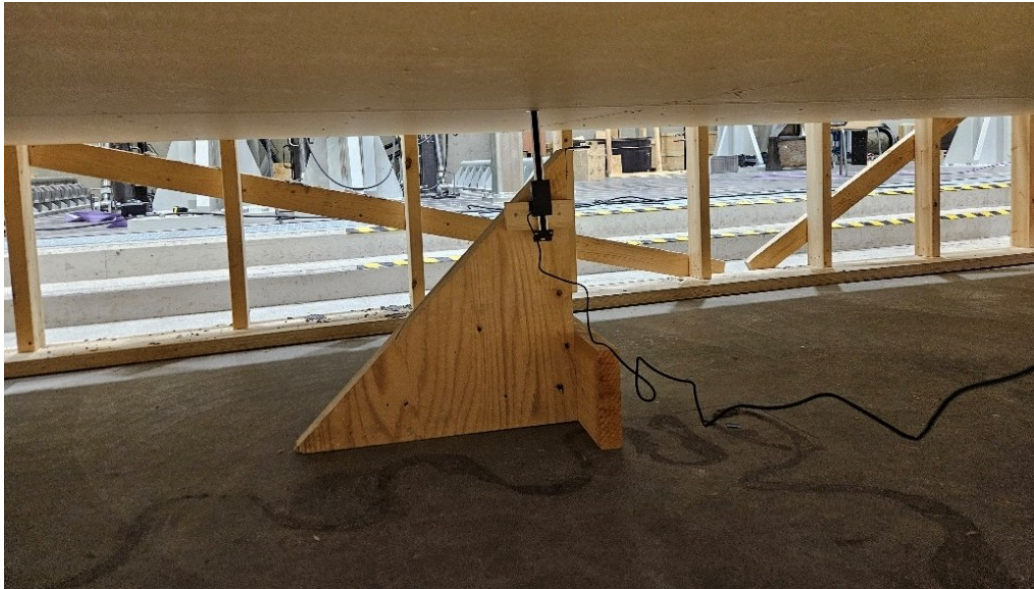
Kuva 36. Betonivalun kuivumisen aikainen taipuman mittaaminen
