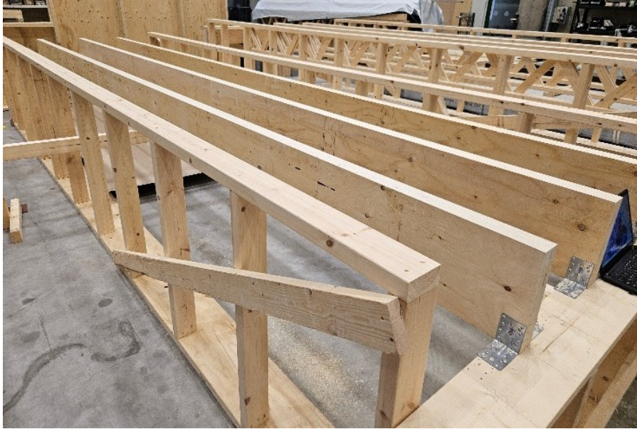
Kuva 4. Hankkeen välipohjaratkaisussa LVL-palkin jännevälän pituus on 6 m
