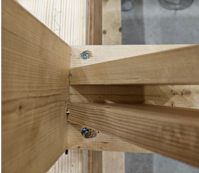
Kuva 10. TK-palkin kiinnitys alapaarteesta
