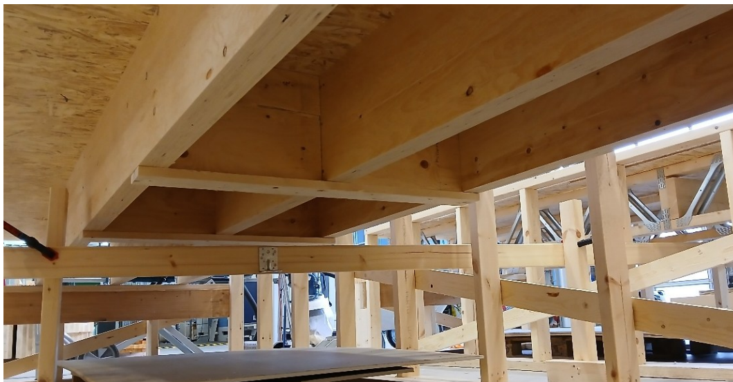
Kuva 15. Kaksi poikittaisjäykistettä pitkien palkkien välissä (kuva: Niko Kinnunen 2025)
