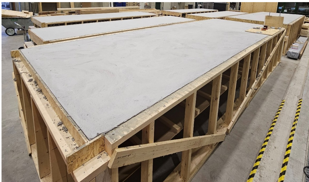
Kuva 23. Päällimmäinen kerros välipohjissa on betonia
