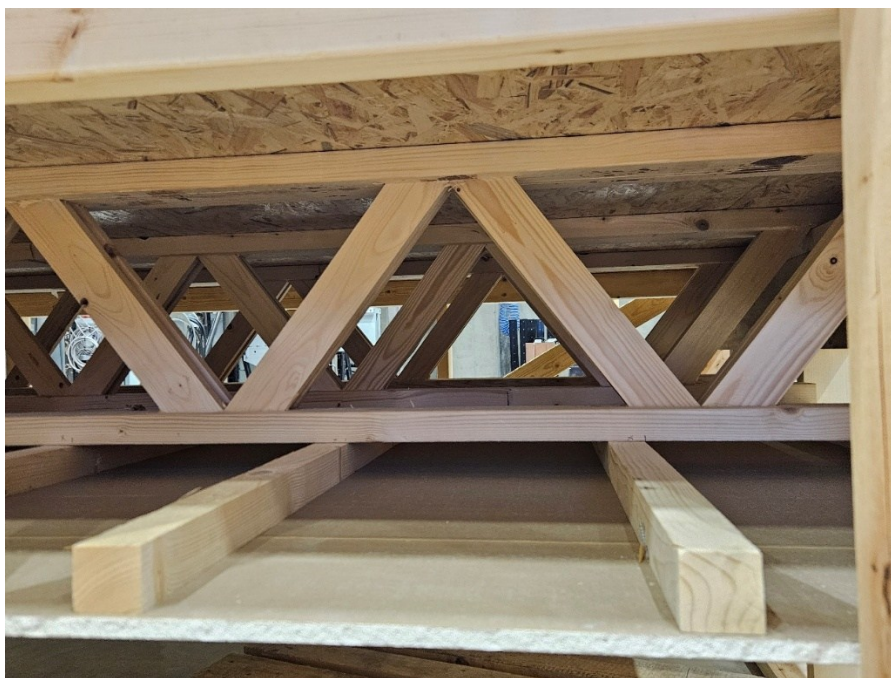
Kuva 12. TK-välipohjan rakenteita
