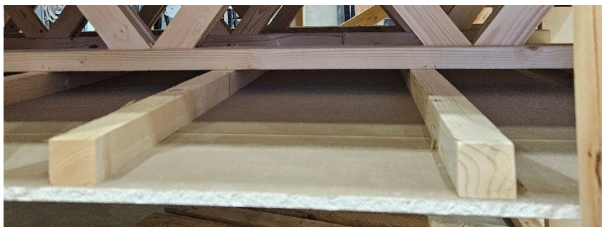
Kuva 24. Välipohjan alin kerros on kipsilevyä
