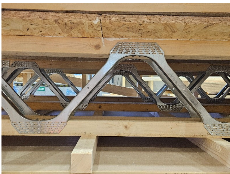
Kuva 21. Easi-joist®-välipohjan materiaaleja ja rakenteita
