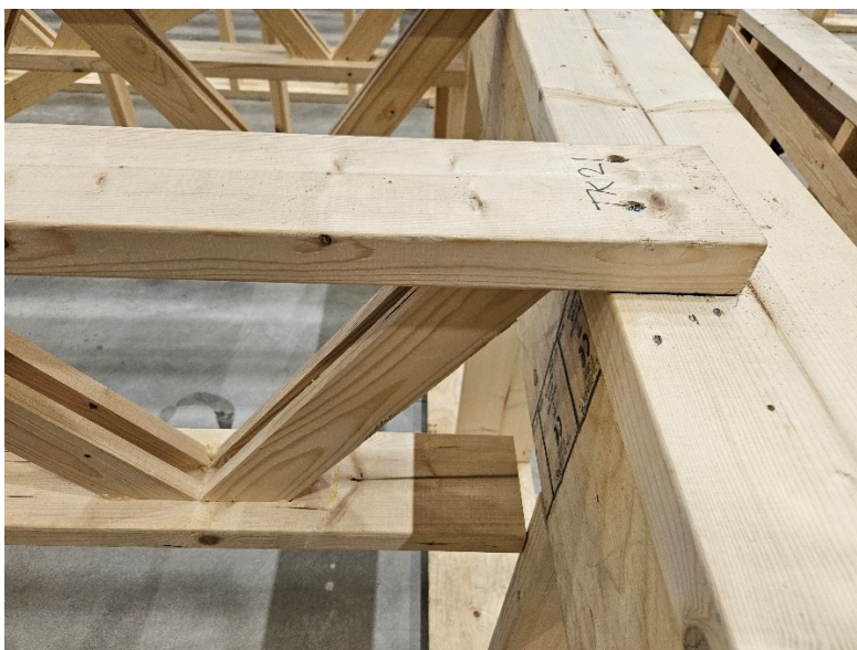
Kuva 9. TK-palkin kiinnitys yläpaarteesta
