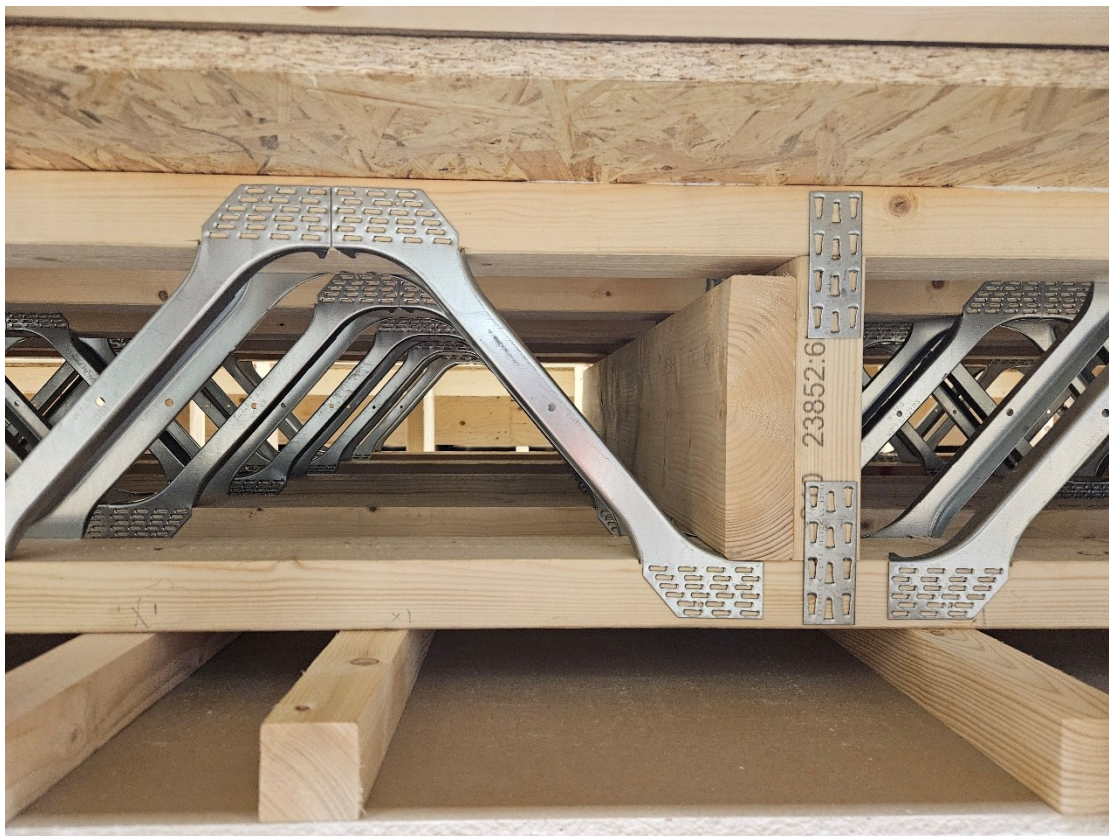
Kuva 3. Välipohjan rakennetta ja jäykistystä
