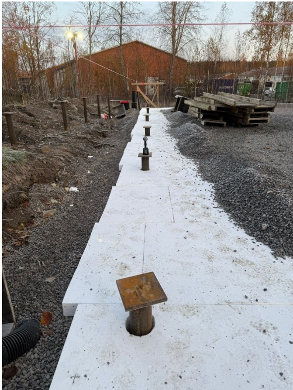
Kuva 6 Esimerkkikohde asennetut teräspaalut (Laurinolli, 2025)
