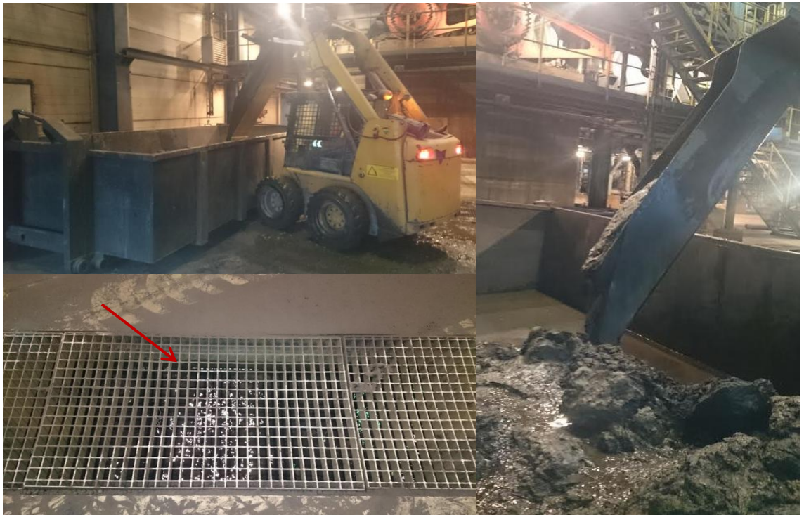
Kuva 13. Bobcat tyhjentämässä kanaalia lietteestä.
