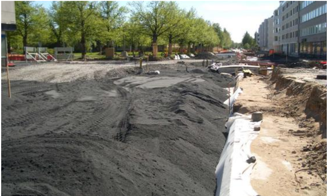
Kuva 3. OKTO-eristeen käyttö kadun rakentamisessa. (Motiva 2015a.)
