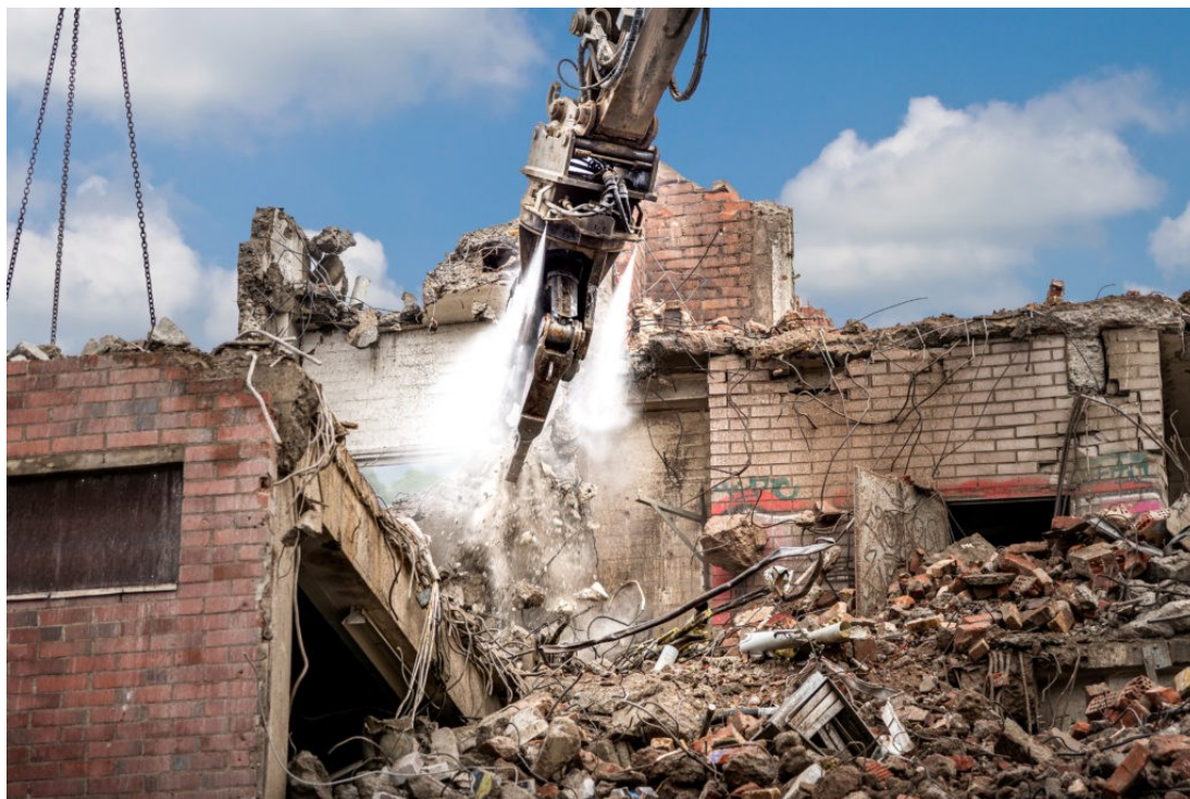
Kuva 4. Dynaset HPW-DUST laitteisto käytössä purkutöissä, Dynaset
