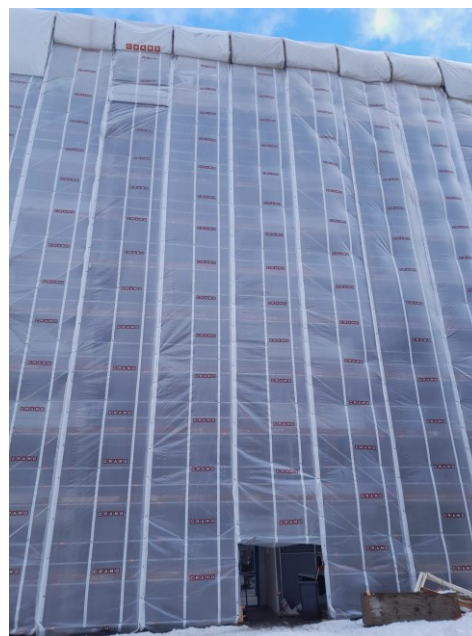
Kuva 20. Kerrostalon saneeraustyömaa sääsuojassa (Juho 2025)
