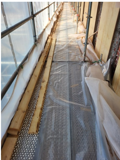
Kuva 17. Julkisivuteline osastoitu muovilla (Juho 2025)
