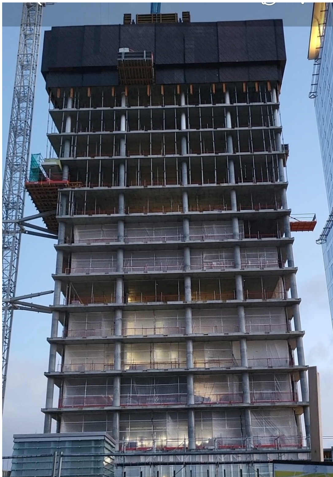
Kuva 5. Tornitalon kerroksia suojattu muovilla ennen julkisivun asennusta (Juho 2023)
