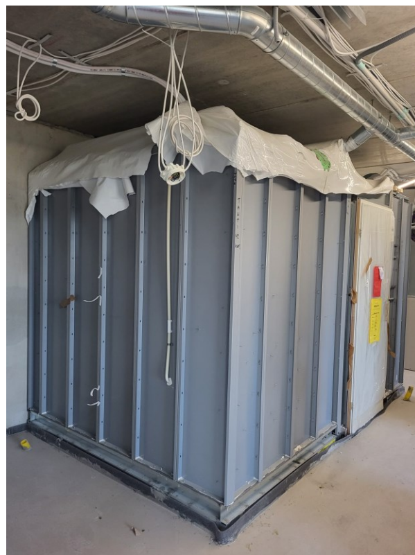
Kuva 13. Paikalleen nostettu kylpyhuone-elementti sinetöitynä (Juho 2025)
