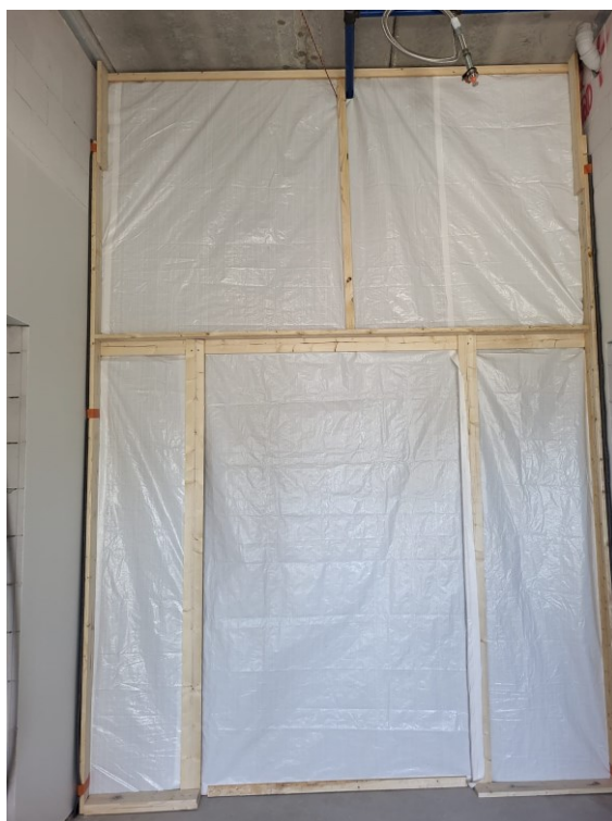
Kuva 15. Muovista ja puurimasta tehty osastoiva väliseinä ja oviaukko (Juho 2025)
