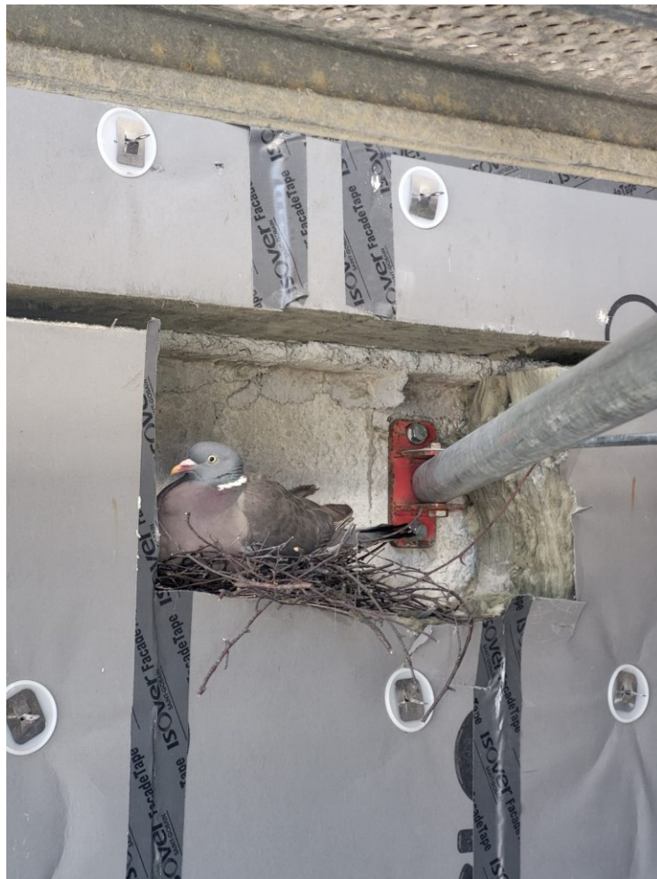
Kuva 21. Ankkurointi rakennuksen runkoon (Juho 2025)
