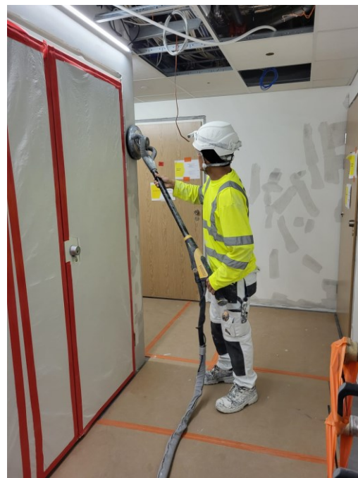
Kuva 6. Tasoitteen hiomista kohdepostolla varustetulla hiomakoneella (Juho 2023)
