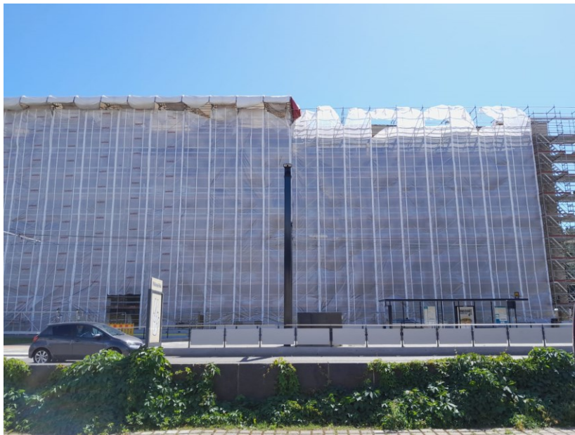
Kuva 19. Kerrostalon uudisrakennustyömaalla sääsuoja eri työvaiheissa (Juho 2025)
