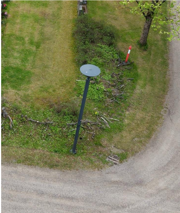
Kuva 19. Istutusalueella oleva valaisinpylväs (Katri Vähämäki, 2025).
