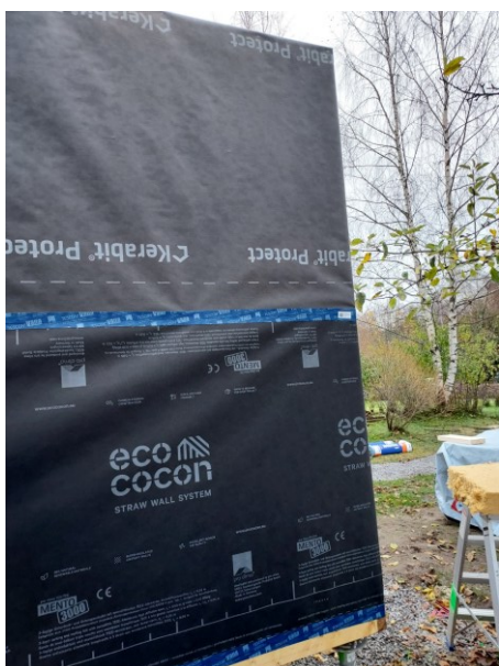
Figur 12. Diffusionsöppet membran med tejpade skarvar. (Rönblad, 2025).
