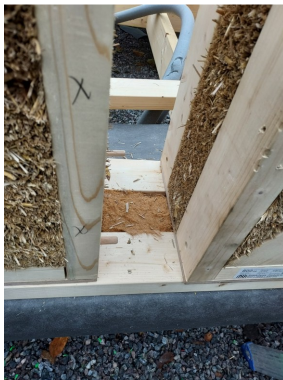
Figur 9. Bottenplattan för elementen. (Rönblad, 2025). Figur 10. Inslagna trätappar som styr elementet till rätt plats. (Rönblad, 2025).
