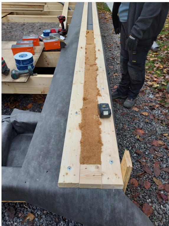
Figur 9. Bottenplattan för elementen. (Rönblad, 2025). Figur 10. Inslagna trätappar som styr elementet till rätt plats. (Rönblad, 2025).
