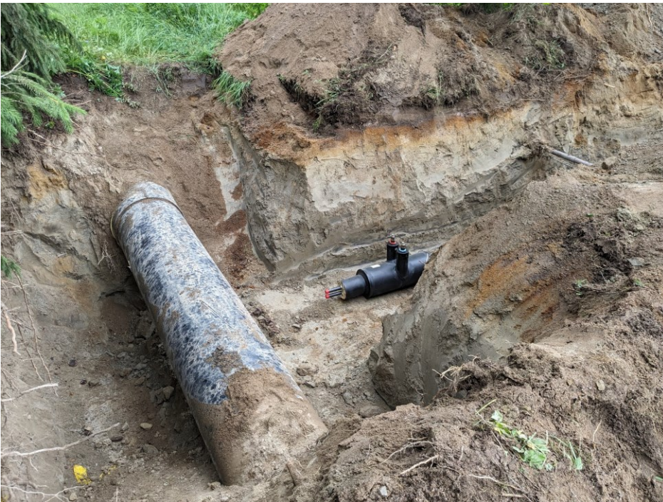
Kuvio 2. Talojohdon asennustyömaa (Roponen 2023)
