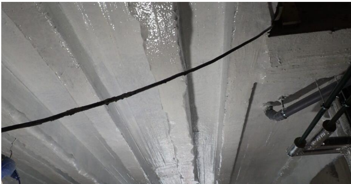
Kuva 10. TKR-järjestelmällä kapseloitua kattopintaa. (Kuva AFRY Finland Oy, Sami Niemi).
