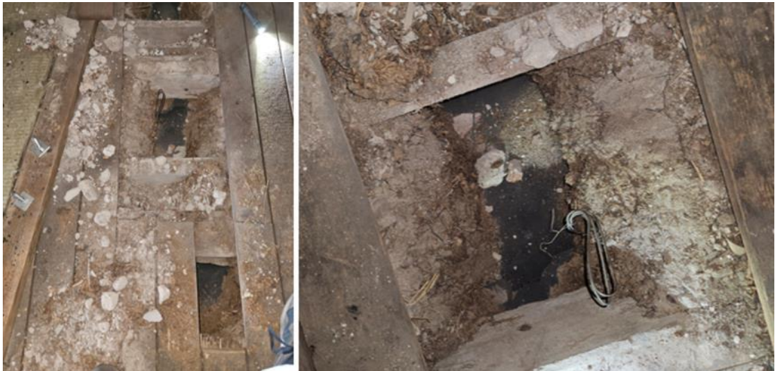
Kuva 17. Yläpohjan rakenneavauksia, tervapahvia on yläpohjatäytön alla (YP3).
