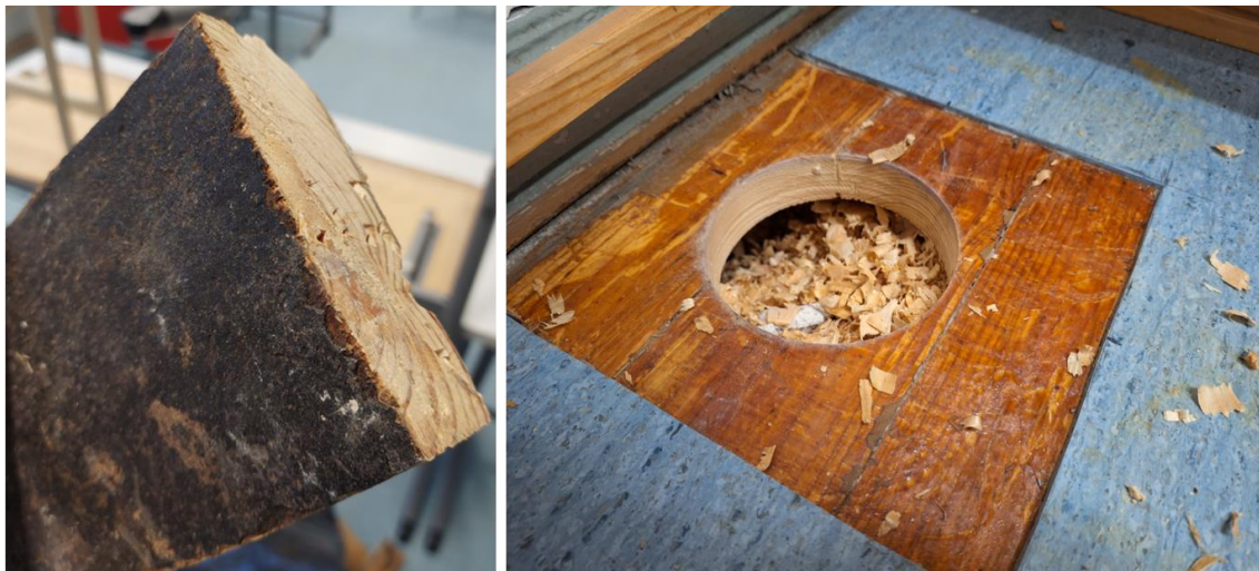
Kuva 3. Vasemmanpuoleisessa kuvassa on lattiaan ylösalaisin asennettuja, uusiokäytettyjä tervattuja lankkuja 1910-luvulla valmistuneessa hirsirakennuksessa. Oikeanpuoleisessa kuvassa on tervattuja lattialankkuja uudempien pintamateriaalien alla, 1930-luvulla valmistuneessa rakennuksessa. (Kuvat AFRY Finland Oy, Paula Wuokko).
