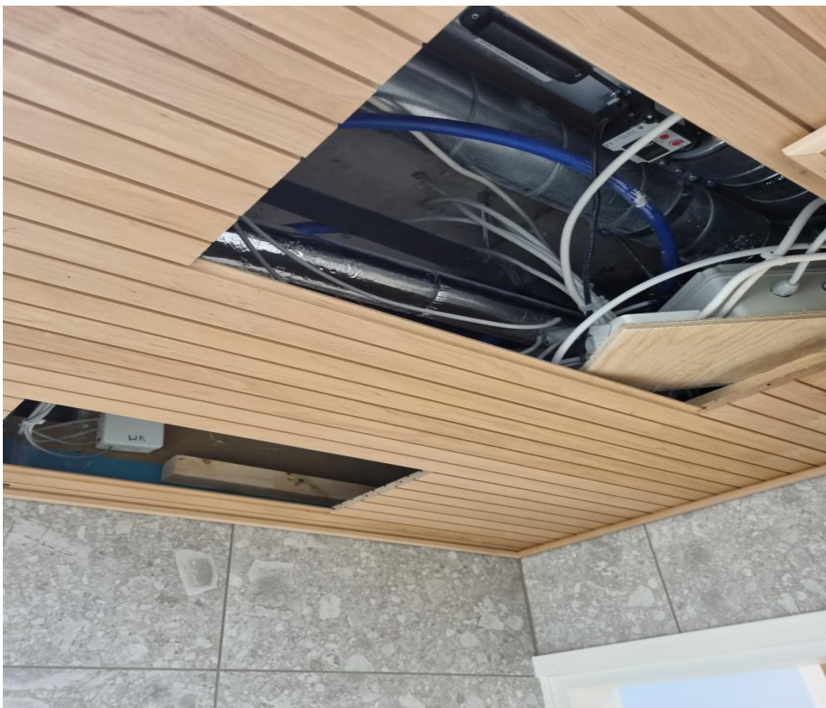
Kuva 5. Kylpyhuoneen alakaton tarkastusluukku
