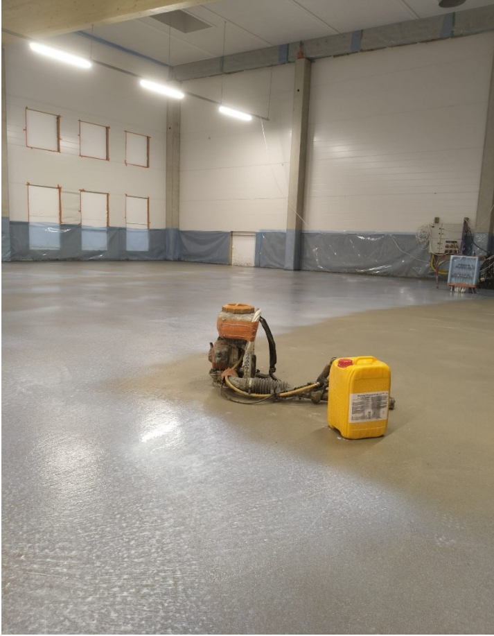
KUVA 3. Jälkihoito sumutettavalla jälkihoitoaineella.
