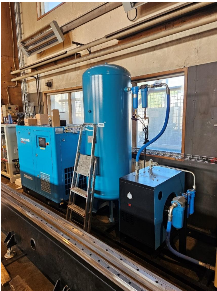
Kuva 7. DEHAHA DM30AAS -kompresori asennusvaiheessa (Honkala 2024)
