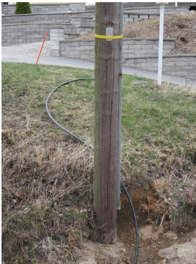
Figur 17 Stolpe med ett varningsband.
