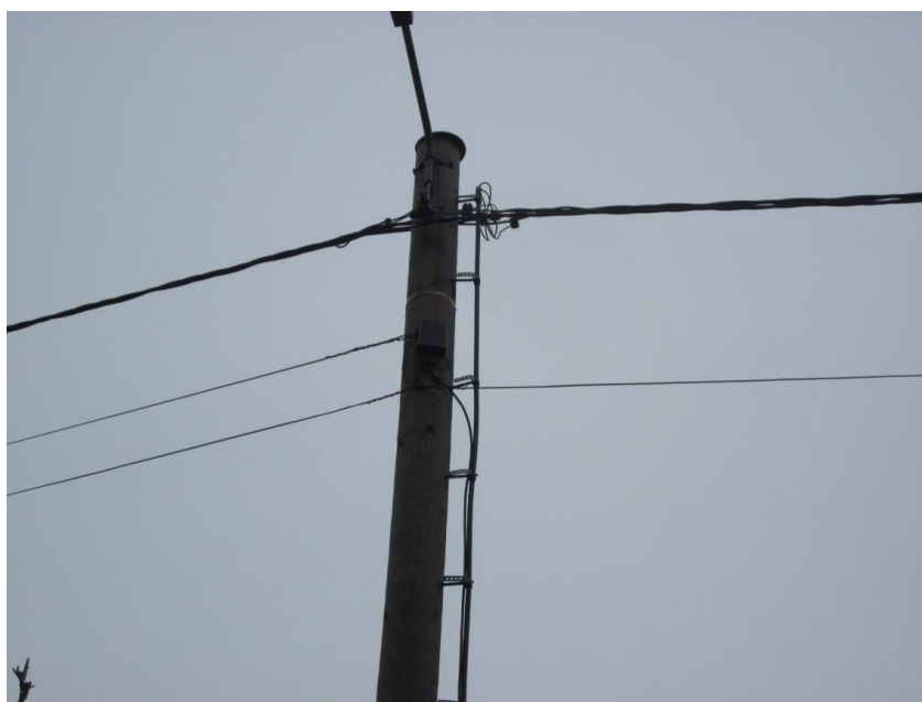
Figur 4 AMKA- kabel upphängd i stolpe.
