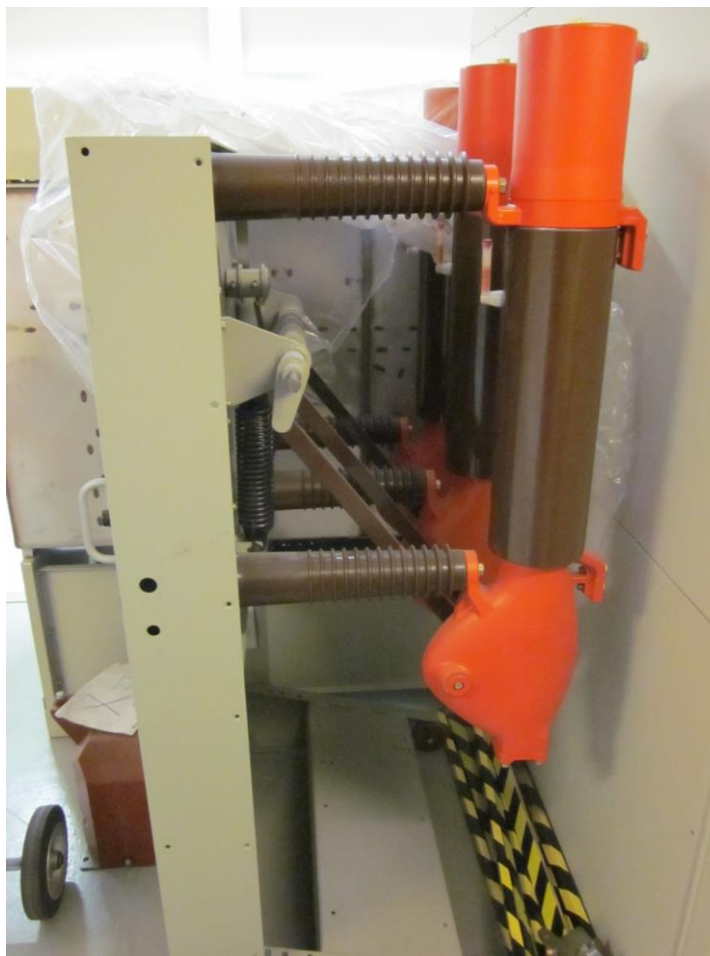
Figur 11 Oljeminimumbrytare för 30 kV ställverket i Björknäs
