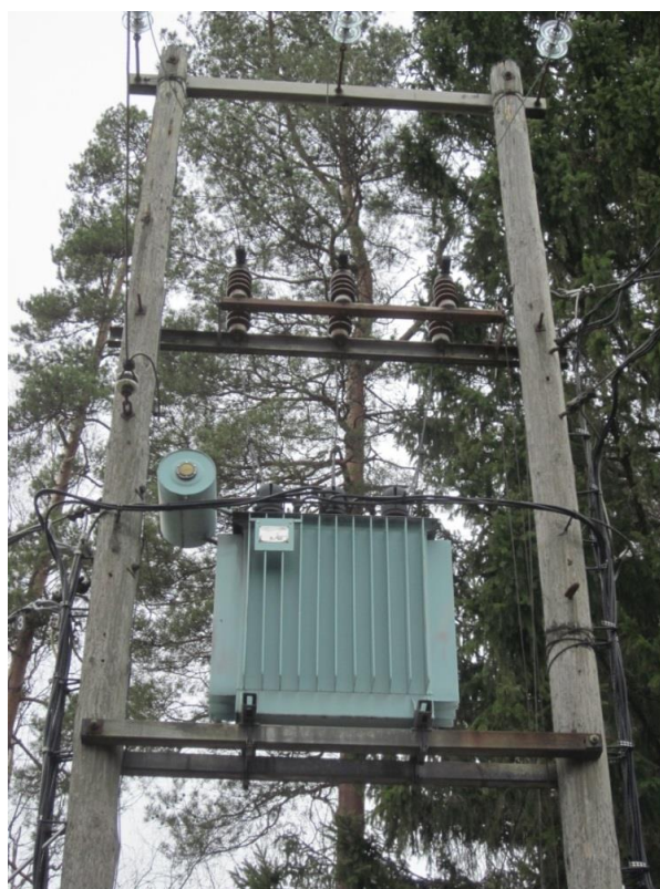
Figur 15 Stolptransformator med frånskiljare
