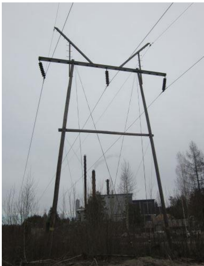
Figur 6 110 kV linje med åskledare.
