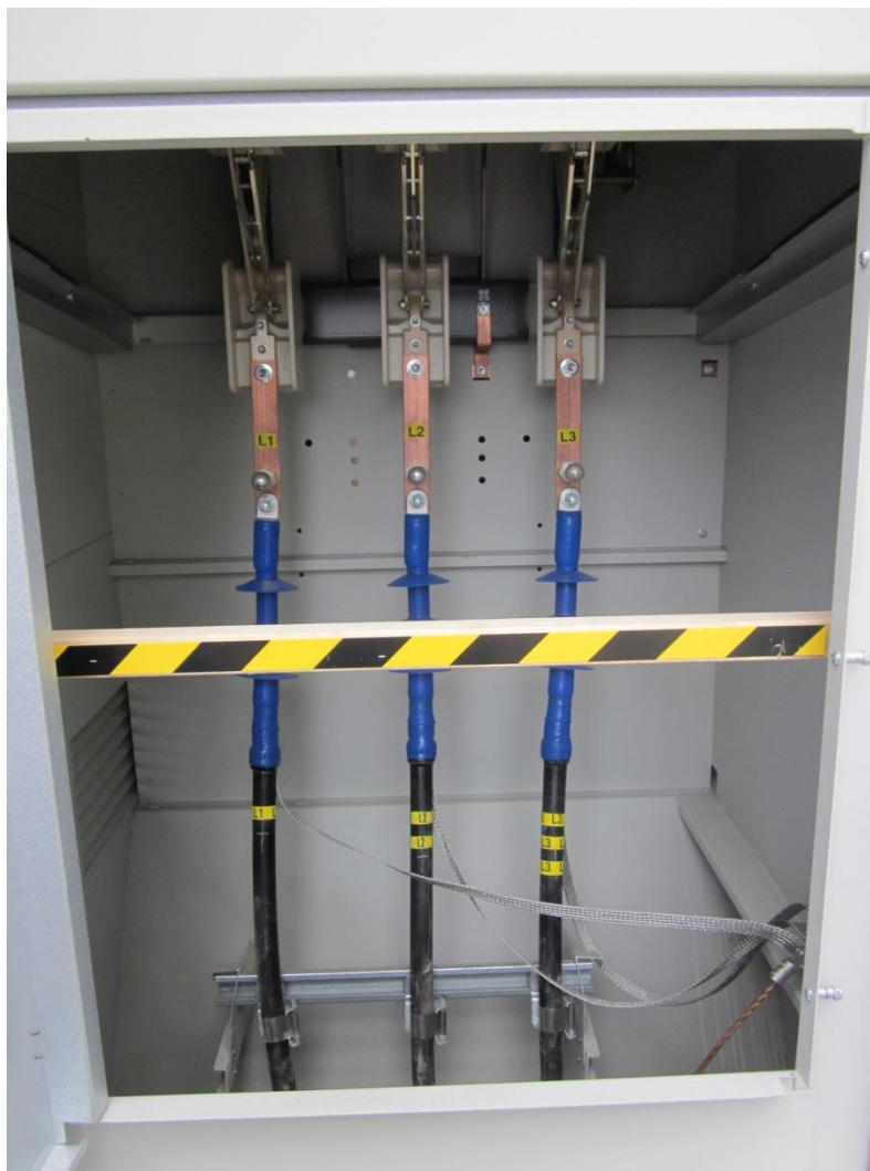
Figur 5 MSP- kabel och kabelskarvar.
