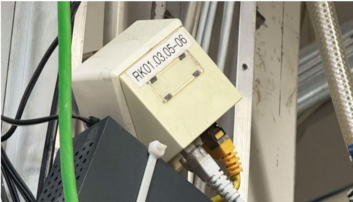
Kuva 3. RJ45-liitäntäpaneelin portin nimeäminen osana kaapeloinnin kartoitusta ja dokumentointia. Oma tuotanto.
