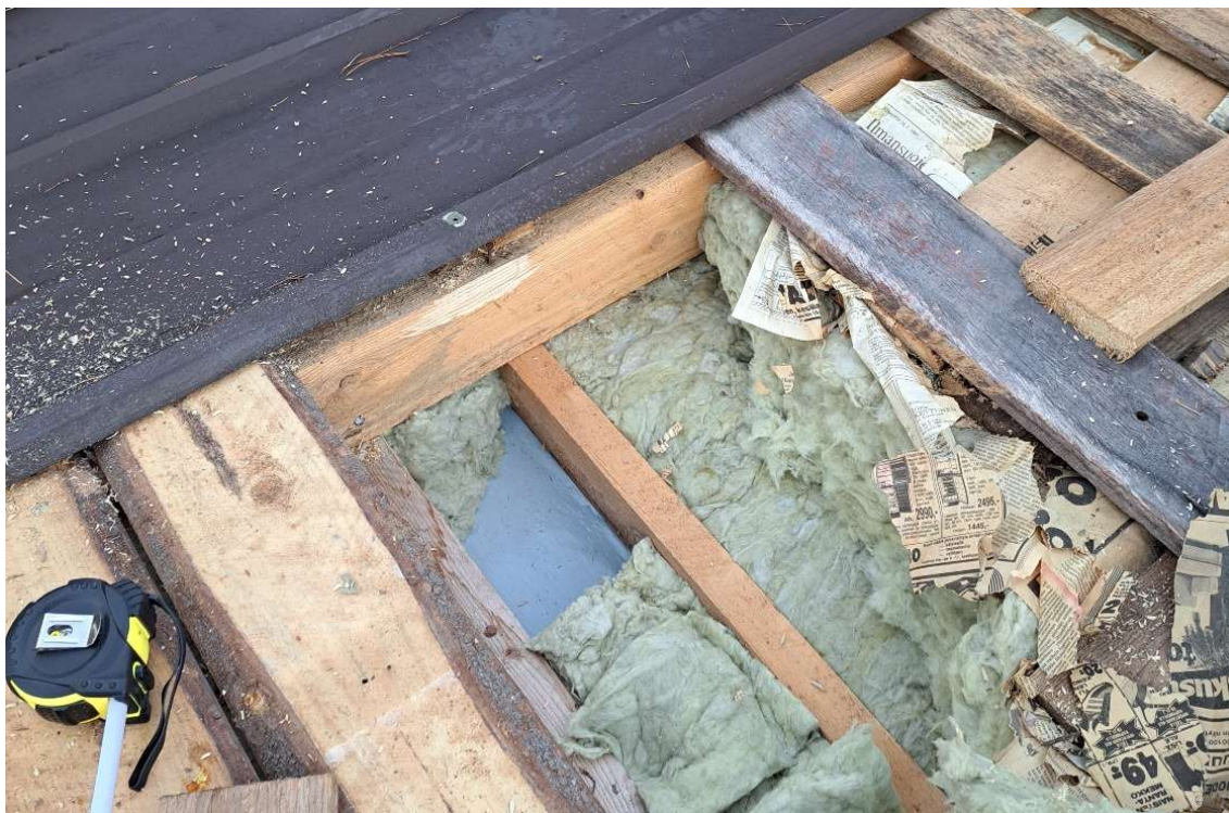
Kuva 3. Vanhan kattorakenteen avaus (PARTANEN 2025)
