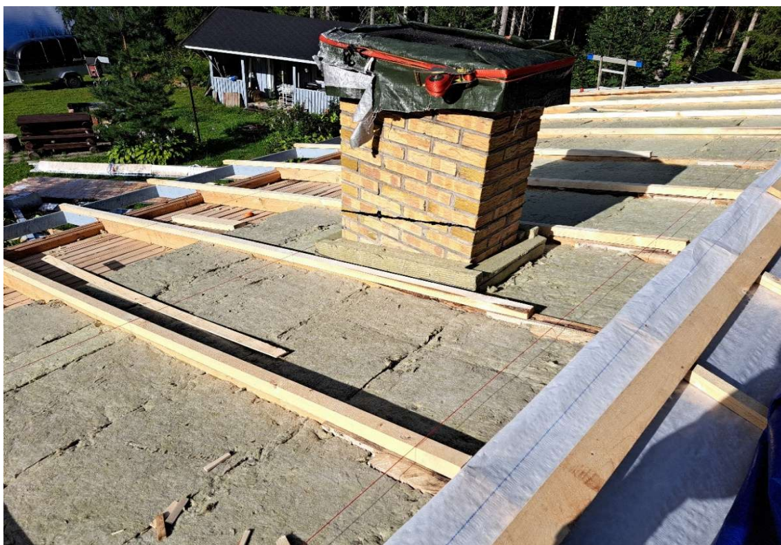
Kuva 9. Kivivilla asennettu SPU-levyn päälle (PARTANEN 2025)
