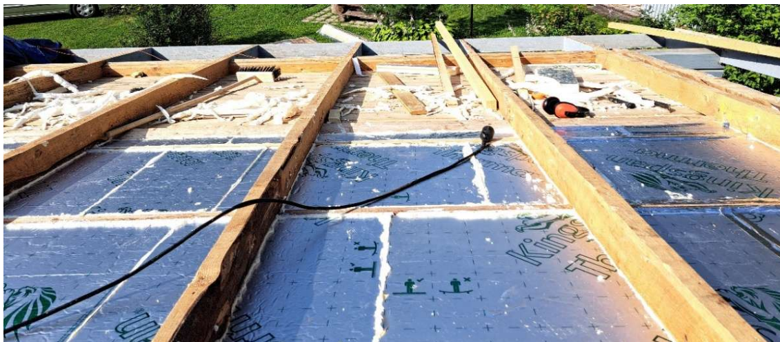
Kuva 8. SPU-levyn asennus (PARTANEN 2025)
