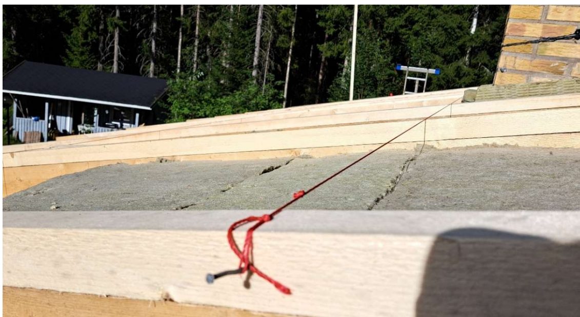
Kuva 7. Vesikaton alustan oikaisu (PARTANEN 2025)
