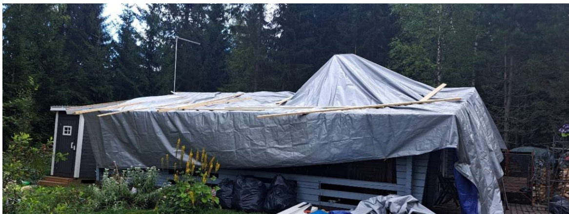
Kuva 12. Kattorakenteen suojaaminen mahdollista sadetta varten (PARTANEN 2025)
