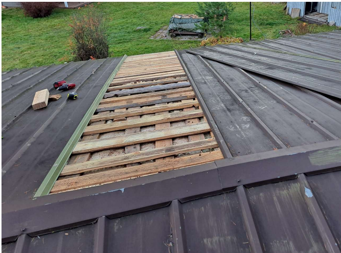
Kuva 2. Vanhan rakenteen tarkastus (PARTANEN 2025)
