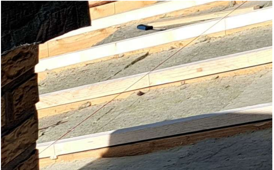
Kuva 15. Vesikaton oikaisu kiilaamalla (PARTANEN 2025)
