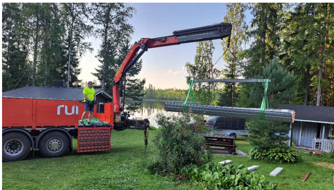
Kuva 5. Katemateriaalin toimitus työmaalle (PARTANEN 2025)
