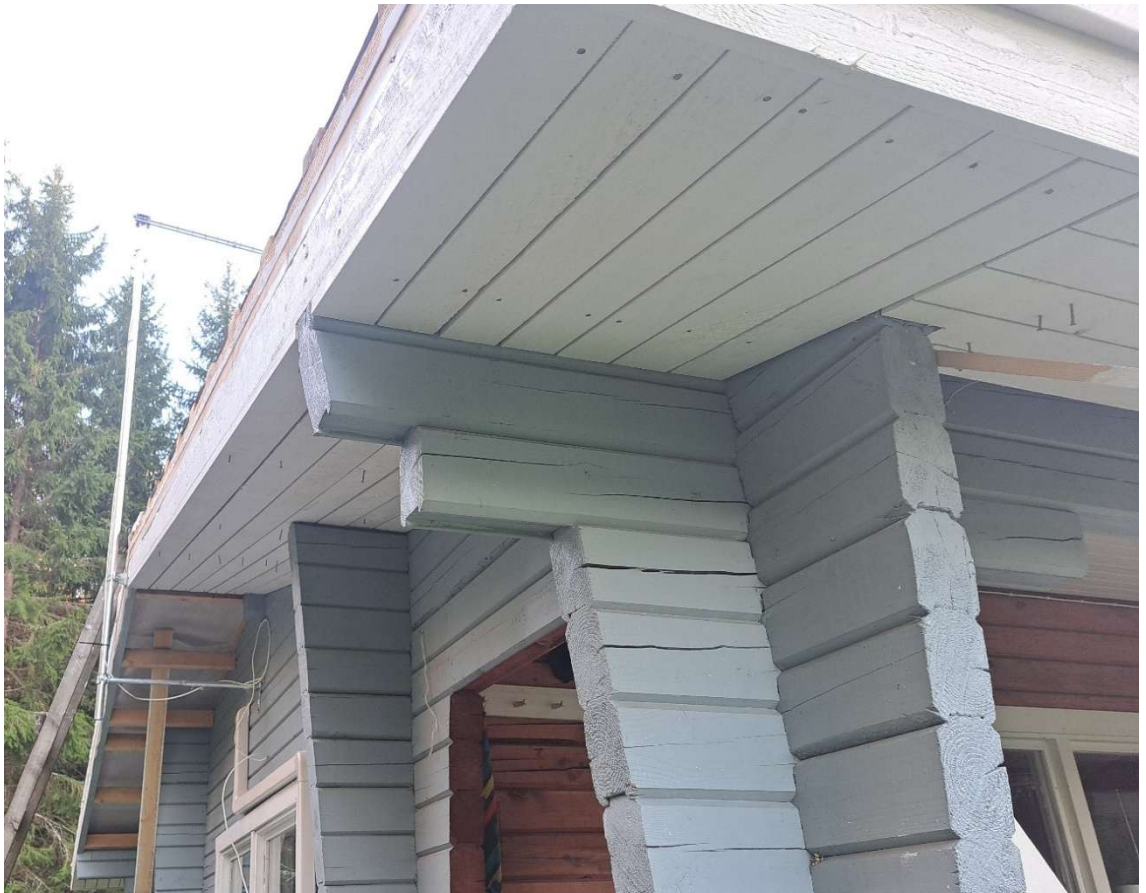
Kuva 14. Räystään aluslaudoitus (pieneläinsuoja) (PARTANEN 2025)
