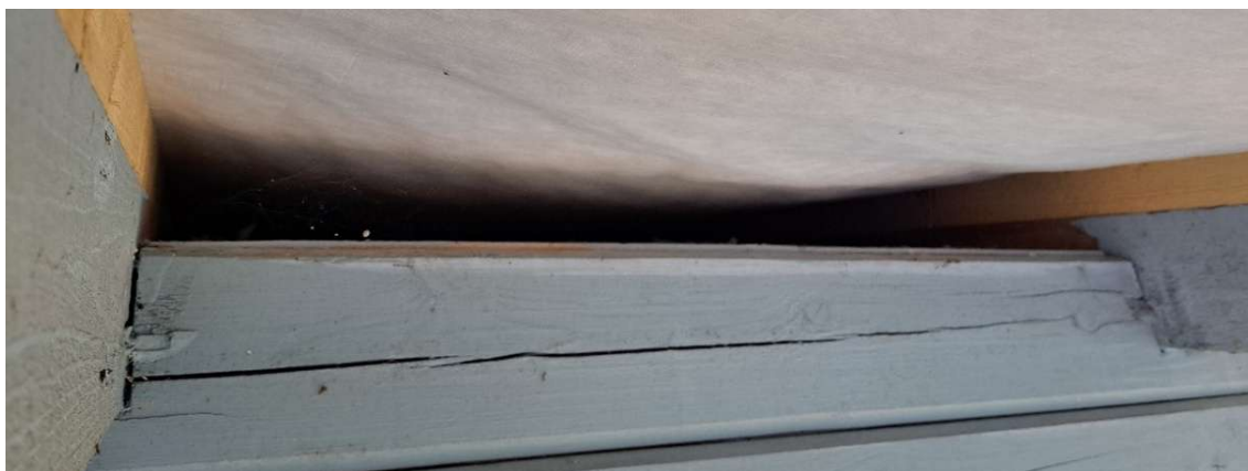
Kuva 10. Korjattu tuuletusväli (PARTANEN 2025)
