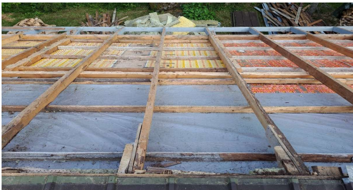
Kuva 6. Vanhat villat poistettu, mutta vanha höyrystulku vielä paikallaan (PARTANEN 2025)
