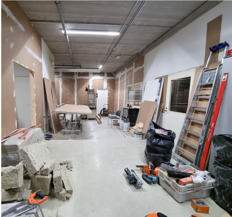
Kuva 9. Muovilaboratorion muutostyöt käynnissä.
