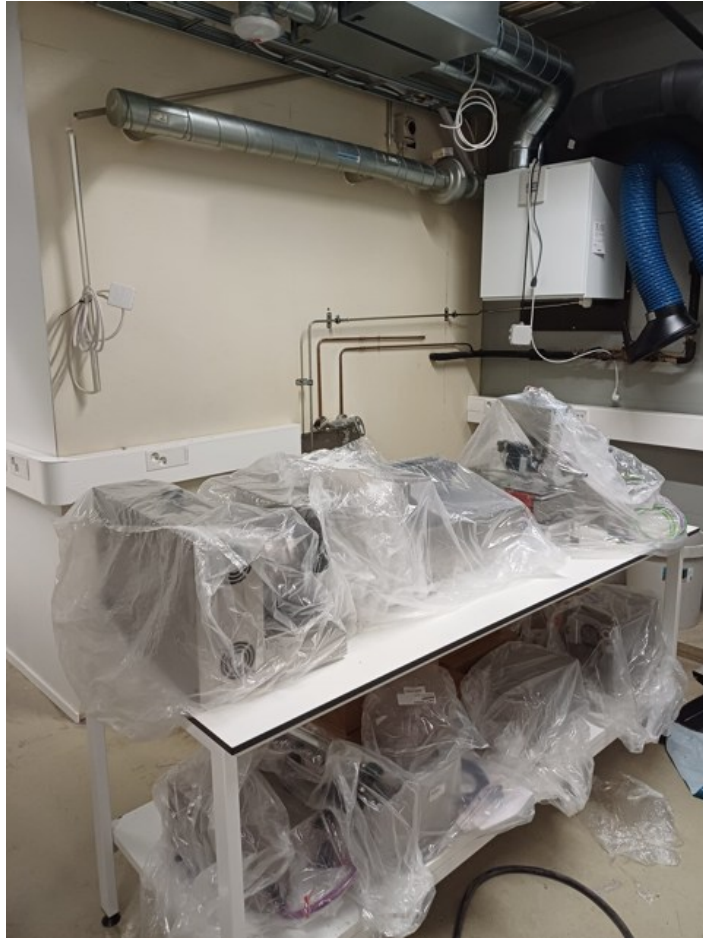
Kuva 12. Uuden laitteen saapuminen. Asennus kesken.
