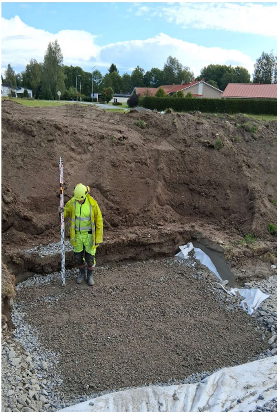
Bild 21. Visar att man utför noggrann kontrollmätning med laserinstrument på specifika områden.
