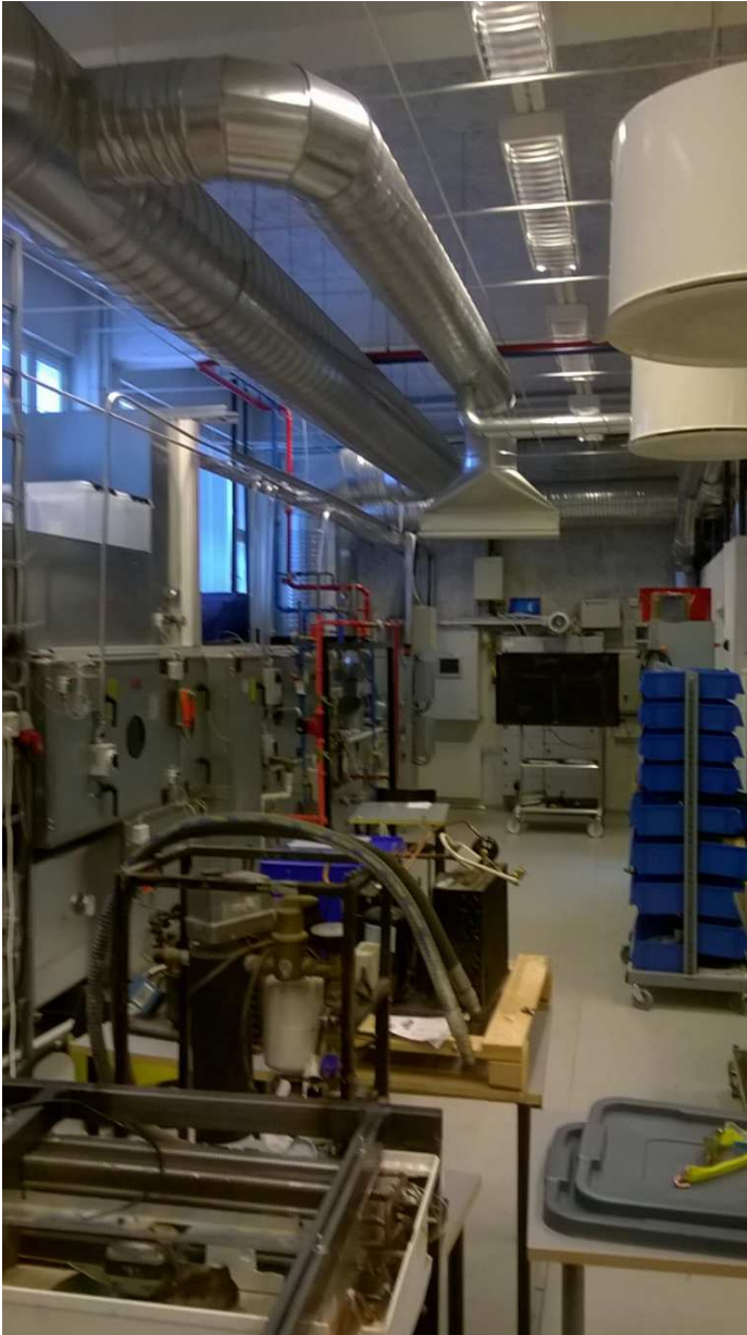
KUVA 2 Laboratorion ilmanvaihtokone
