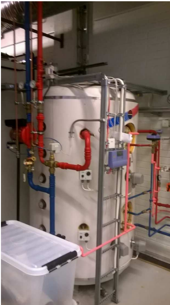
KUVA 6 LVI-laboratorion lämminvesivaraaja
