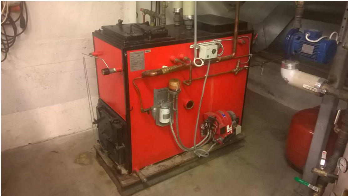
KUVA 11 Kiinteänpolttoaineen kattila
