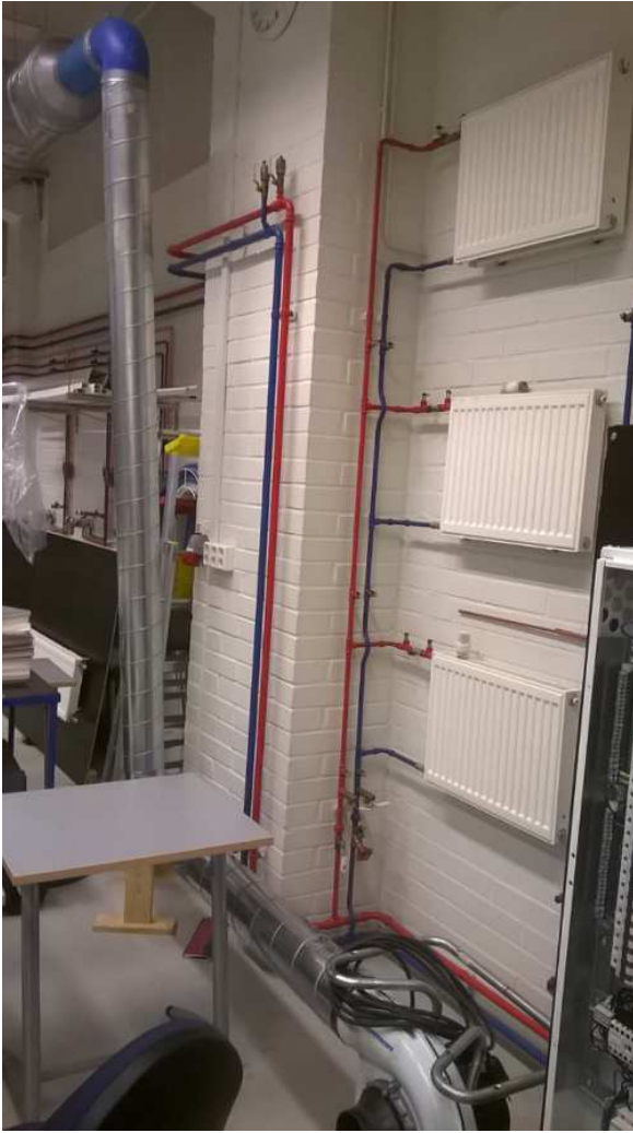
KUVA 3 Tiiviyskokeen koejärjestely
