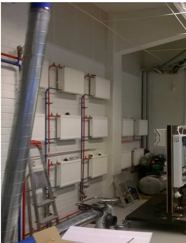
KUVA 8 Laboratorion lämmitysverkosto
