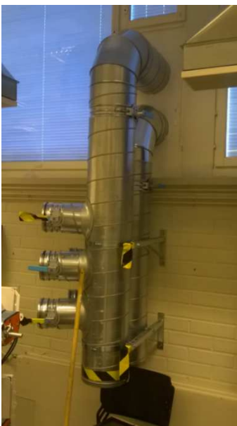
KUVA 5 Ilmanvaihtokanavayhteet
