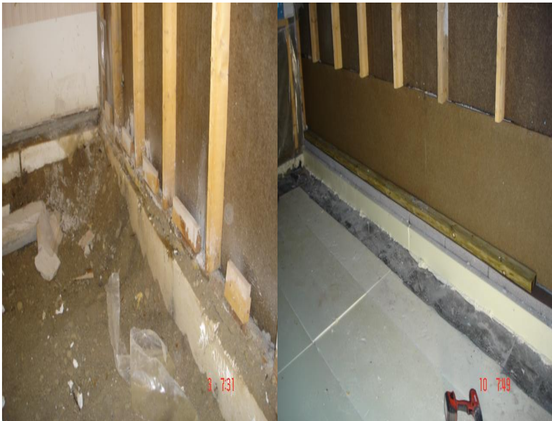
KUVA 11. Ulkoseinä rakennuksen lyhyemmällä sivulla, (Kuva: Ilpo Kataja 2013)
