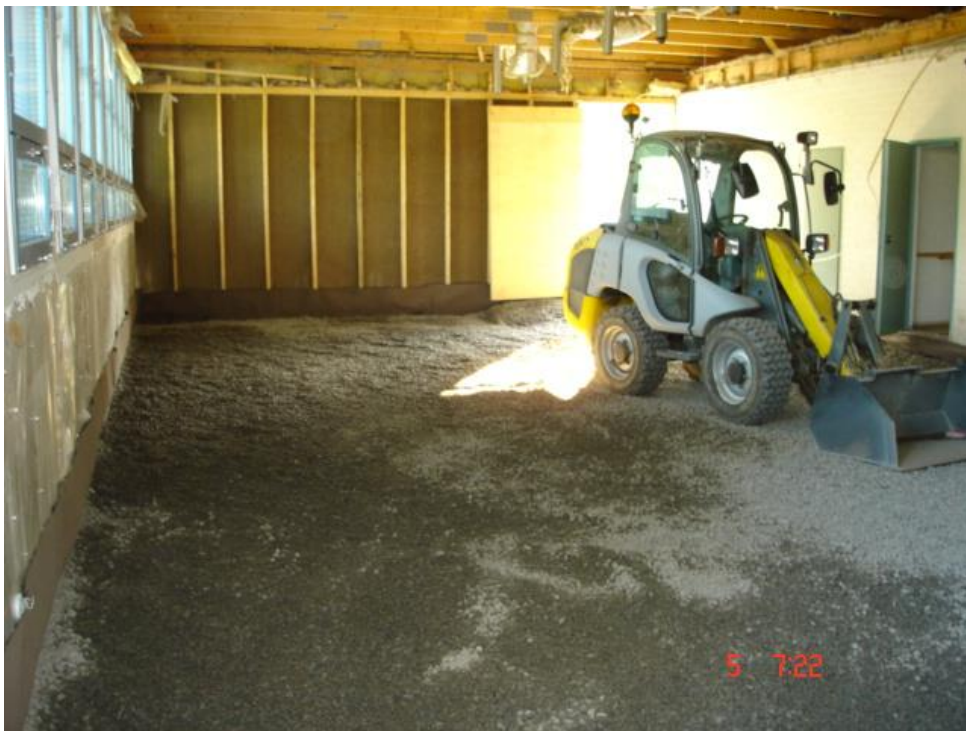
KUVA 5. Kapillaarikerros betonilaatan alle (Kuva: Ilpo Kataja 2013)
