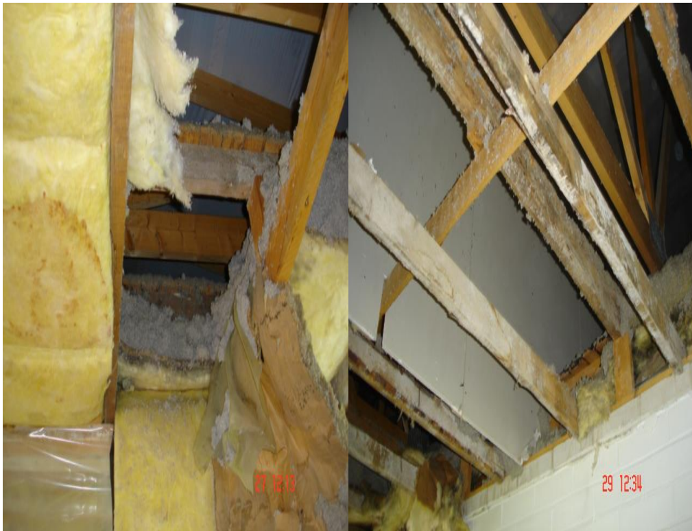
KUVA 7. Vanhoja yläpohjarakenteita (Kuva: Iipo Kataja 2013)
