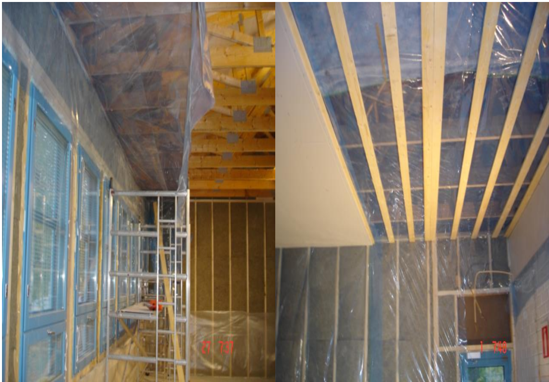
KUVA 8. Uusia yläpohjarakenteita (Kuva: Ipo Kataja 2013)
