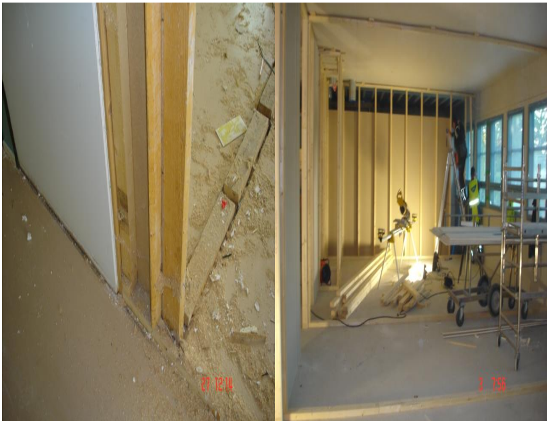
KUVA 10. Kevyet väliseinät, (Kuva: Ilpo Kataja 2013)
