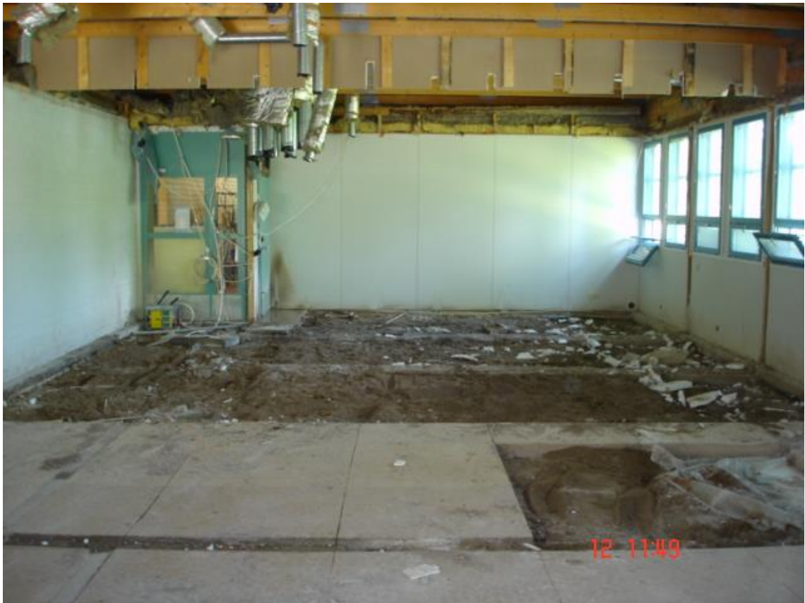
KUVA 4. Alapohjan purku (Kuva: Ilpo Kataja 2013)
