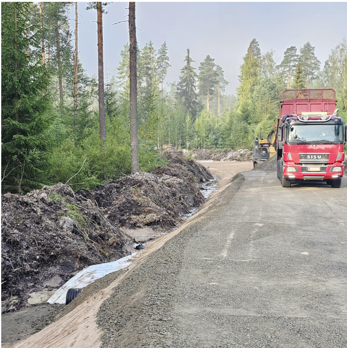
Kuva 9. Tien rakennekerrokset. Case työmaa, Y2.
