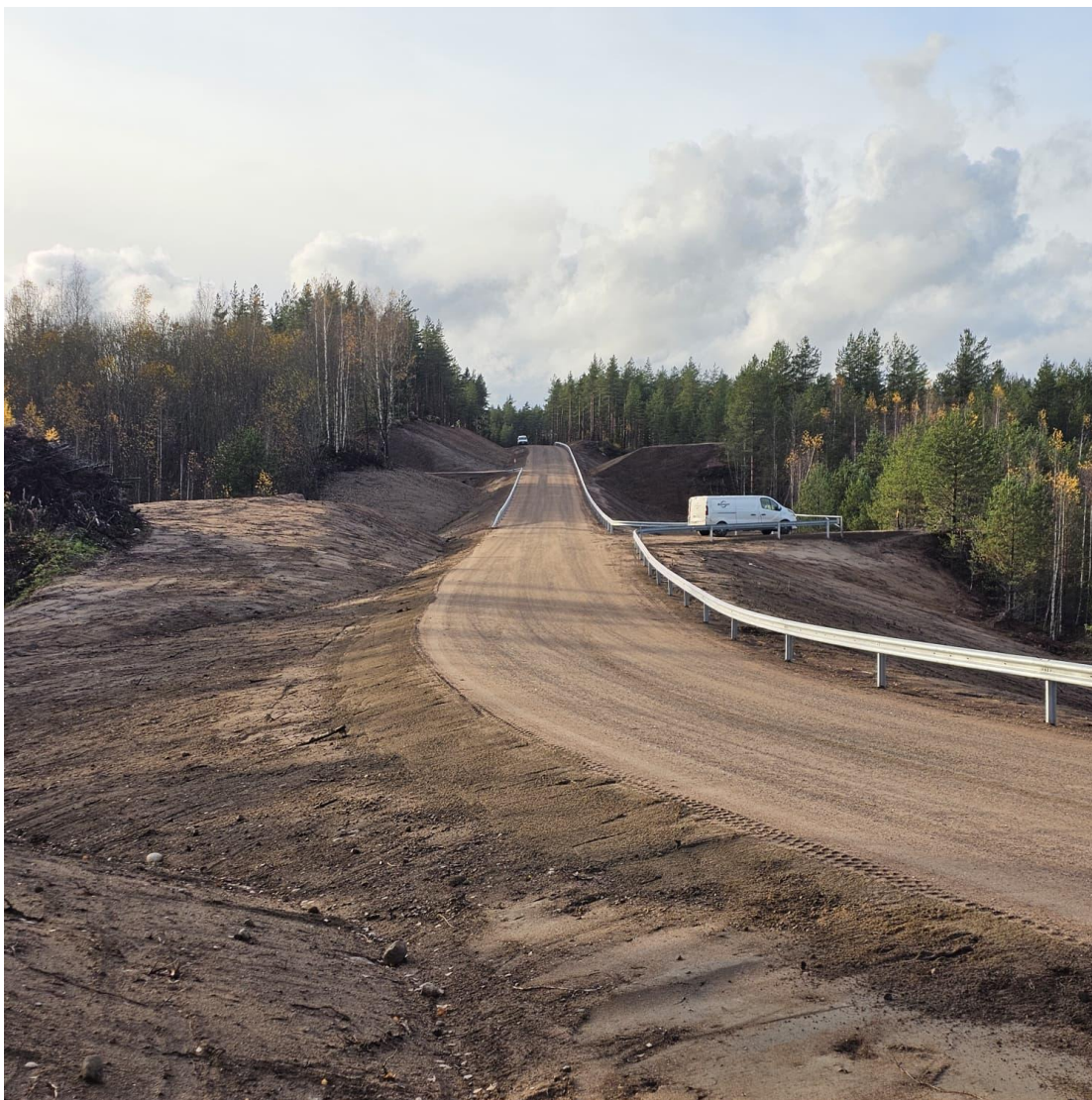
Kuva 6. Turvallisuusrakenne. Case työmaa – pengerkaide Y1.
