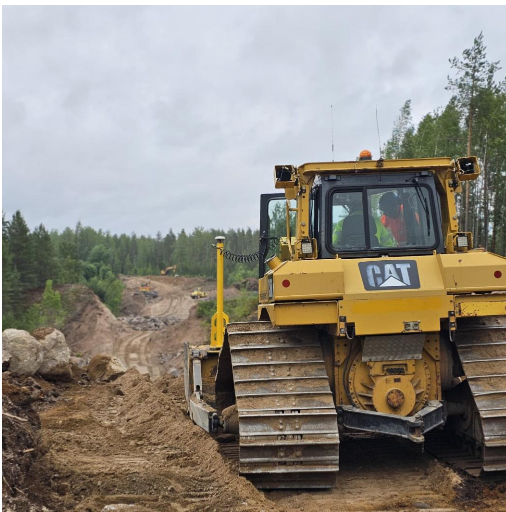
Kuva 7. Massojen siirtelyä pusku traktorilla. Case työmaa, Y1.
