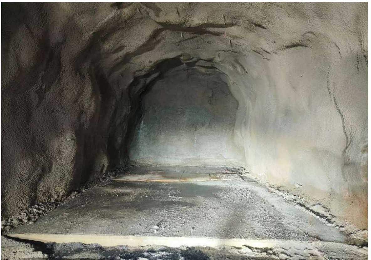
Kuvio 33. Muuntamolle louhittu perä, jossa lattiavalu
