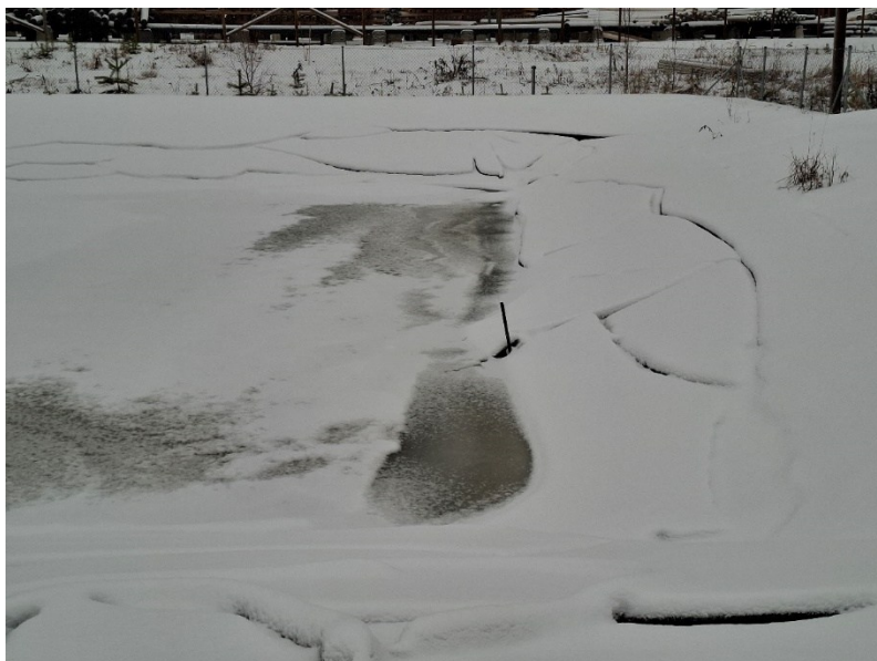
KUVA 6. Tasausaltaan purkuputki jään alla kepin kohdalla (Ruukonen 2025, CC BY-SA)
