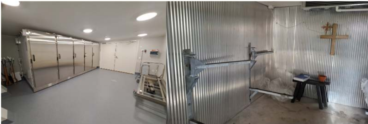
Kuva 3.11 Vainajakylmiöiden tiloja. Vasemmanpuoleisessa kuvassa kylmäkaapit, jossa vasen kaappi on pakastusta varten. Oikeanpuoleisessa kuvassa vanhanaikainen pakastehuone, jossa höyrystinpatteri on kylmiön katossa.
