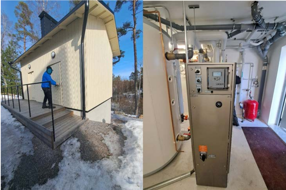
Kuva 3.17 v. 1799 valmistunut puukirkko, jossa kirkon pihamaalle on rakennettu osittain laskevan rinteiden taakse kirkon väritystä noudattava konehuone ilma-vesilämpöpumpujärjestelmän laitteistoille.
