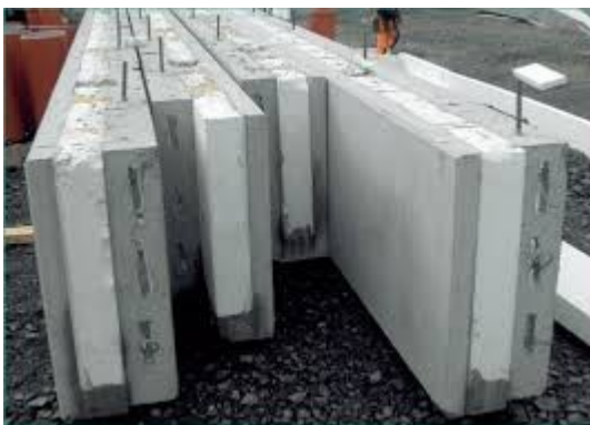
Kuvio 12. Sandwich-sokkelielementti (Betoniteollisuus ry 2022)
