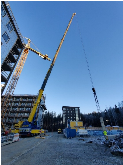
Kuvio 16. Havatorin Liebherr 230 tn -ajoneuvonosturi nostamassa pilarielementtiä (Havator Oy 2021)
