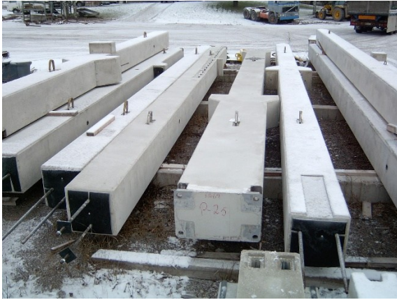
Kuvio 3. Pilareita työmaalla (Elementtisuunnittelu Oy 2023e)
