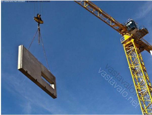
Kuvio 17. Torninosturi nostamassa seinäelementtiä (Vastavalo media 2011)
