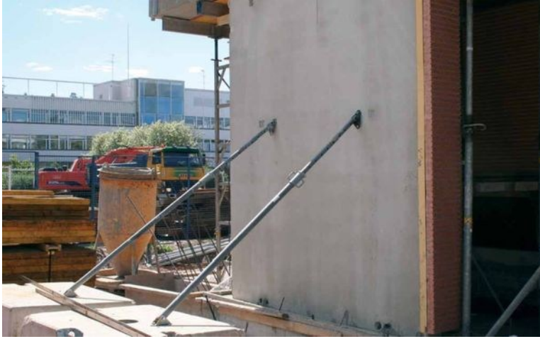
Kuvio 21. Seinäelementti tuettuna elementtituilla eli "tönäreillä" (Ramirent Oy 2026)
