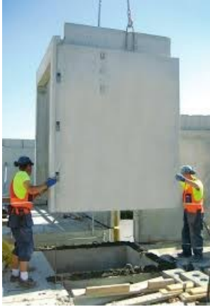
Kuvio 11. Hissikuiluelementin asennus (Parma Oy 2018)
