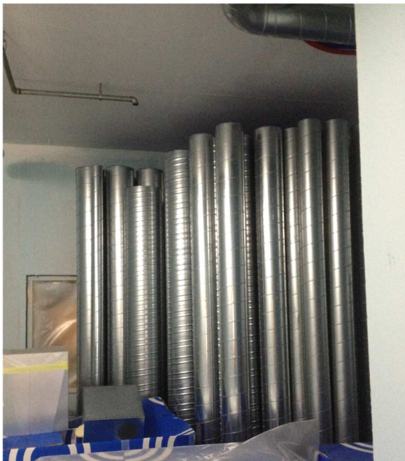
KUVA 5 Oikeaoppisesti varastoituja ilmanvaihtokanavia
