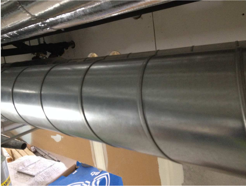
KUVA 9 Kattoon asennetun kanavan ulkopinnan puhtaus päältäpäin kuvattuna
