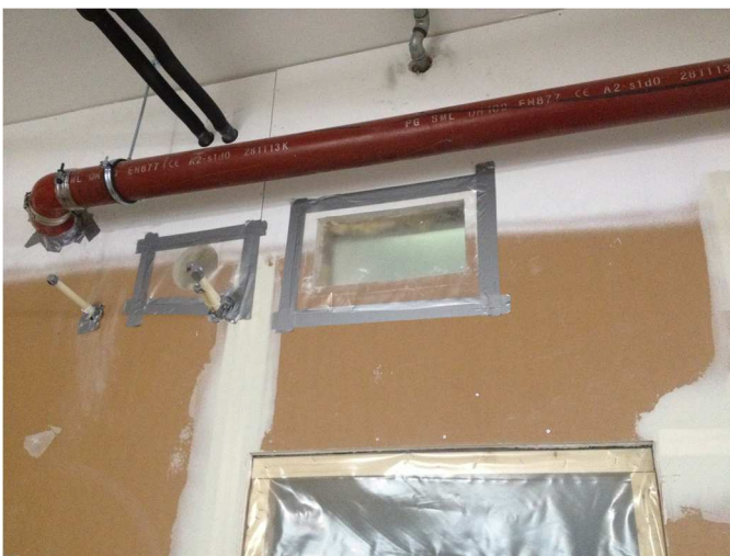
KUVA 7 Läpiviennit tiivistettynä
