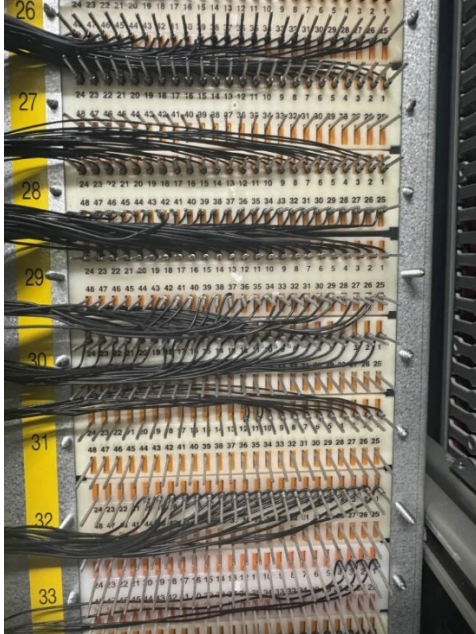
Kuva 10. XC-liittimien toinen puoli, kiertoliitintäpät ja räppäykset.
