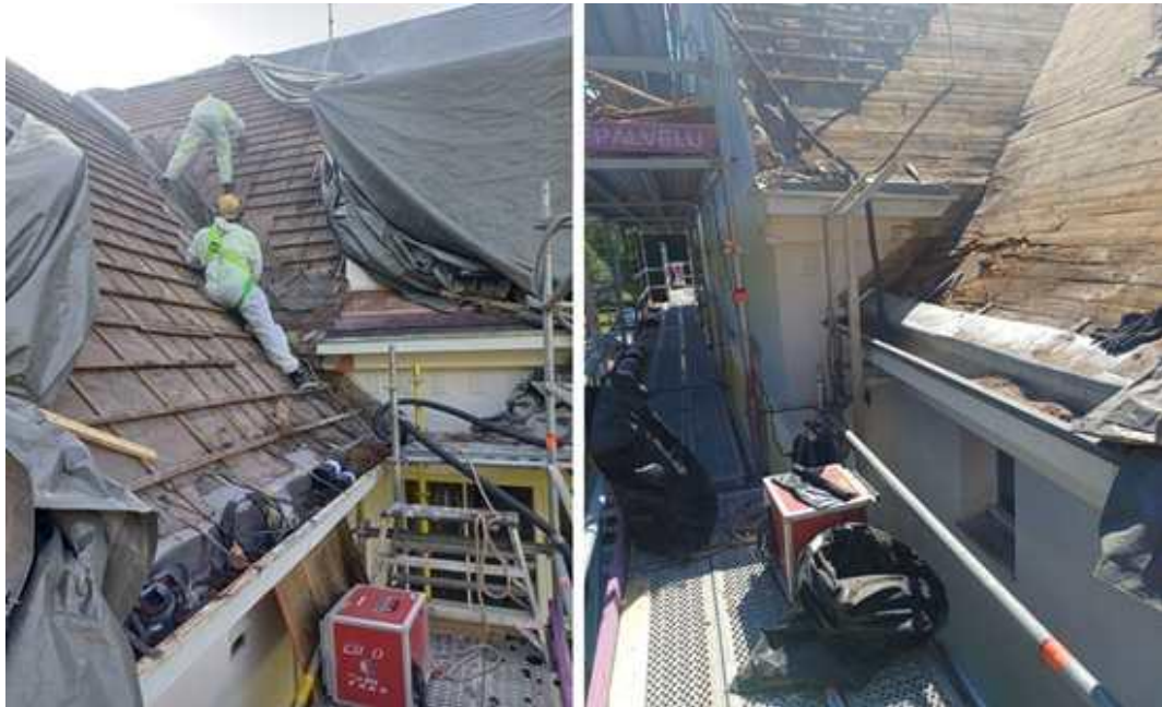
Kuva 12 Asbestipurkajat työssään ja valmis purkutyö.
