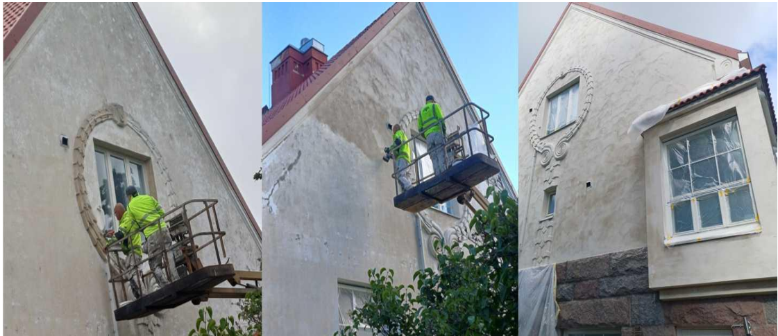
Kuva 20 Kalkkimaalaustyö käynnissä lounaisella julkisivulla.
