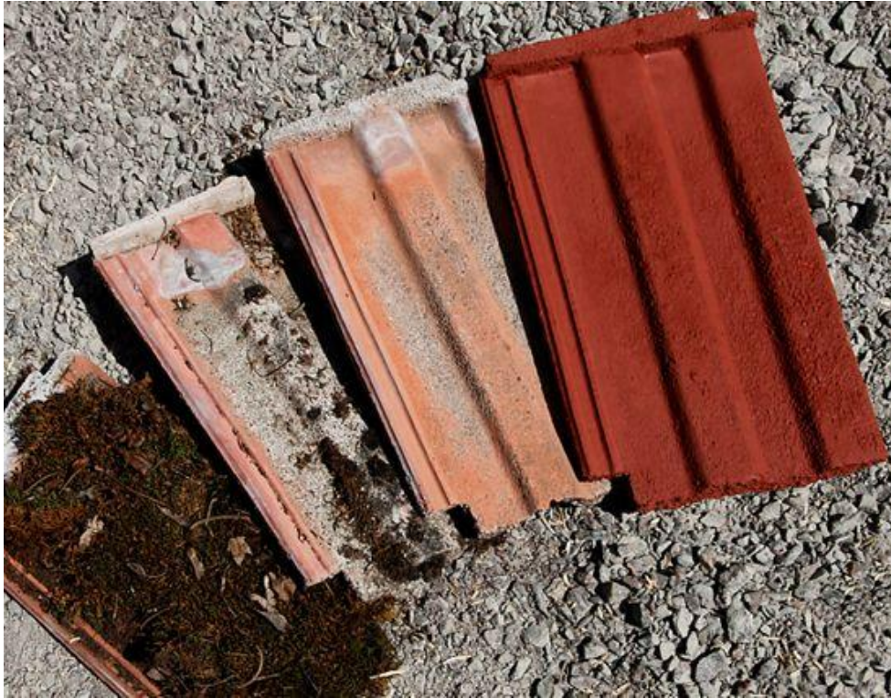
Kuva 24 Kattotiilien kunnostus Perinnemestarin tyyliin (Rinne, 2019).
