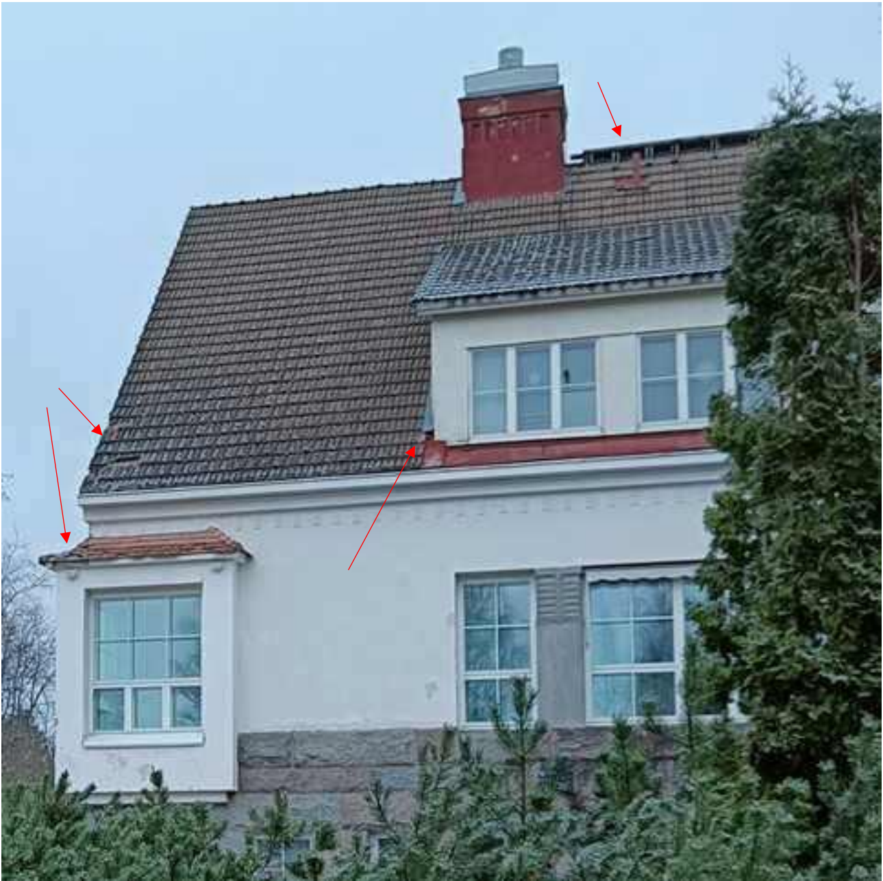
Kuva 1 Vesikaton nykykunto, yleiskuva.
