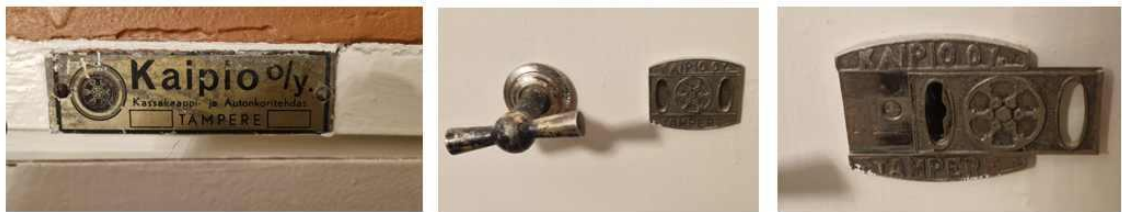
Kuva 3 Teräsoven merkinnät ja lukitusjärjestelmä, Kaipio Oy.
