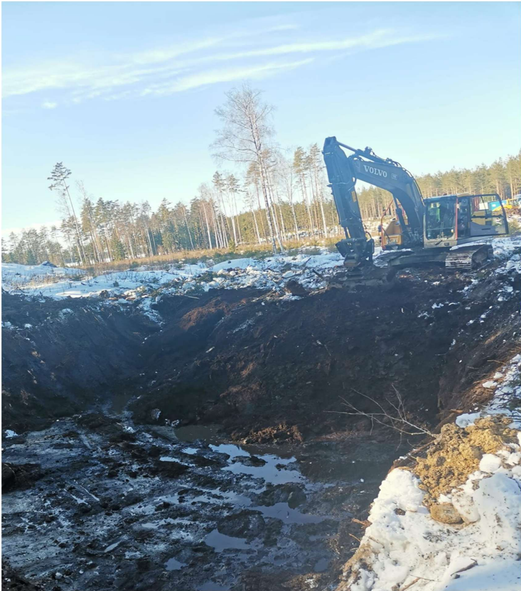
Kuvio 1. Tiepohjan massanvaihdon kaivamista etukäteen aukikaivuuna.
