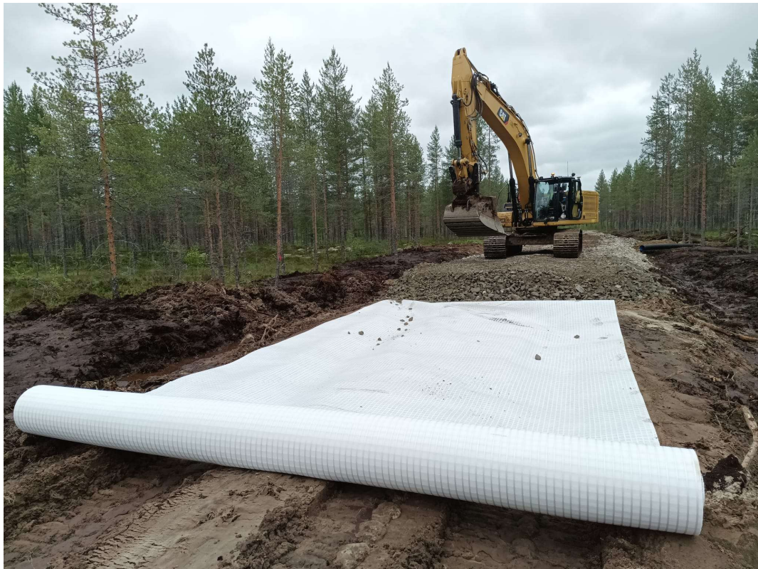
Kuvio 3. Yhdistelmälujite asennettuna tierakenteeseen (Keski-Suomen Betonirakenne Oy 2025)
