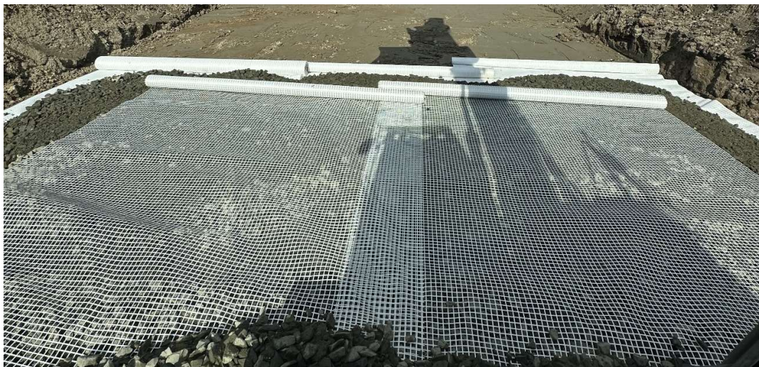
Kuvio 4. Yhdistelmälujite asennettu leikkauspinnalle ja geoverkko asennettuna jakavan kerroksen päälle (Keski-Suomen Betonirakenne Oy 2025)
