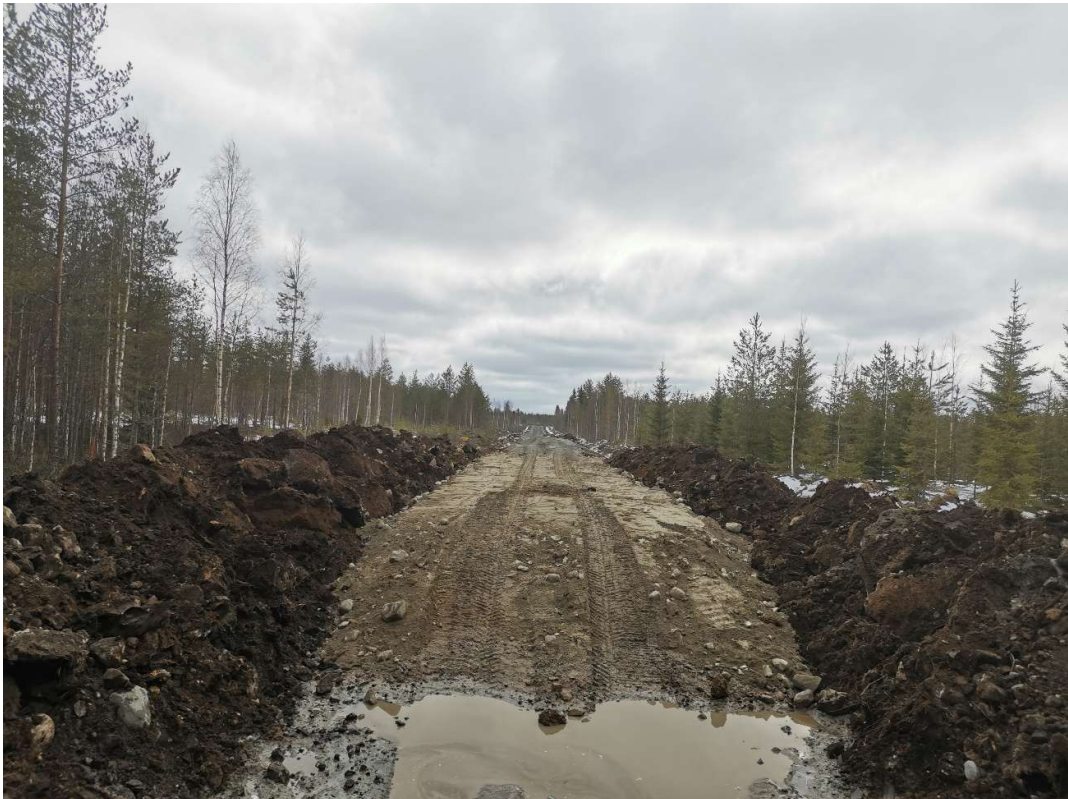
Kuvio 2. Massanvaihdon pengertäyttö etukäteisen aukikaivuun jälkeen
