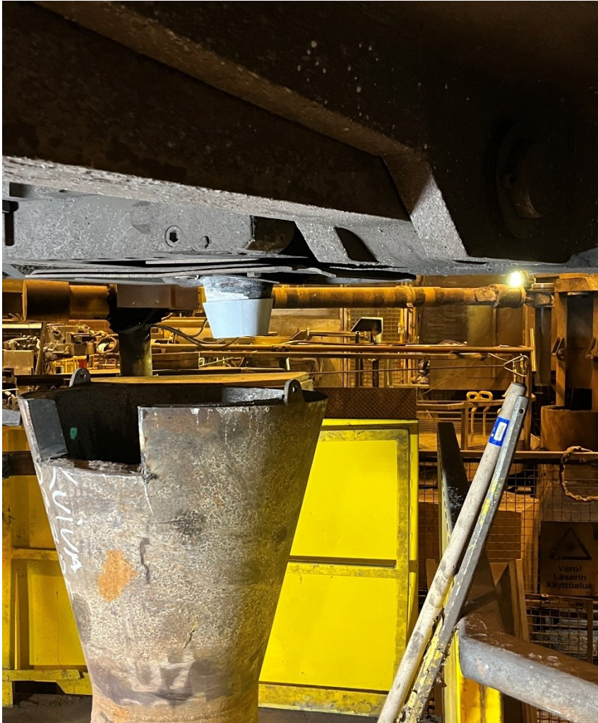
KUVA 11. kuvassa näkyy alasuutiili, johon on laitettu tiiviste paikalleen.
