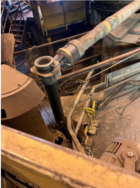
KUVA 15. Kuvassa robotti ja suihkunsuojaputki JVK6.
