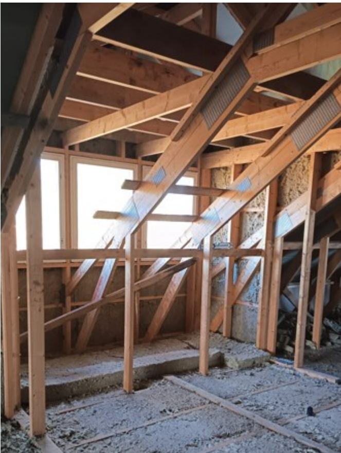
Kuva 7. Kattolyhdyn kattotuolit.
