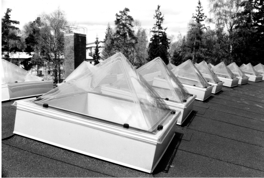
KUVA 6. Pyramidi kupujen jonoasennus. Kannelmäki, Helsinki (Keraplast 2013b.)
