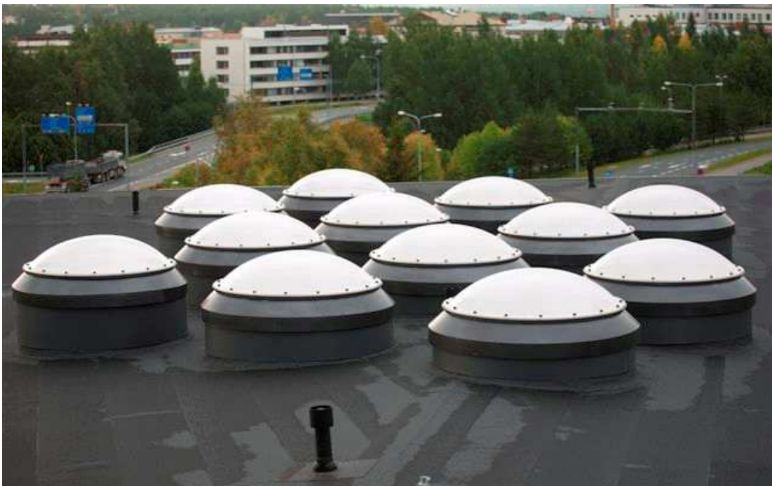
KUVA 5. MP-kattovalokupukenttä. Metsähallituksen toimitalo Pilke, Rovaniemi (Keraplast 2013b.)
