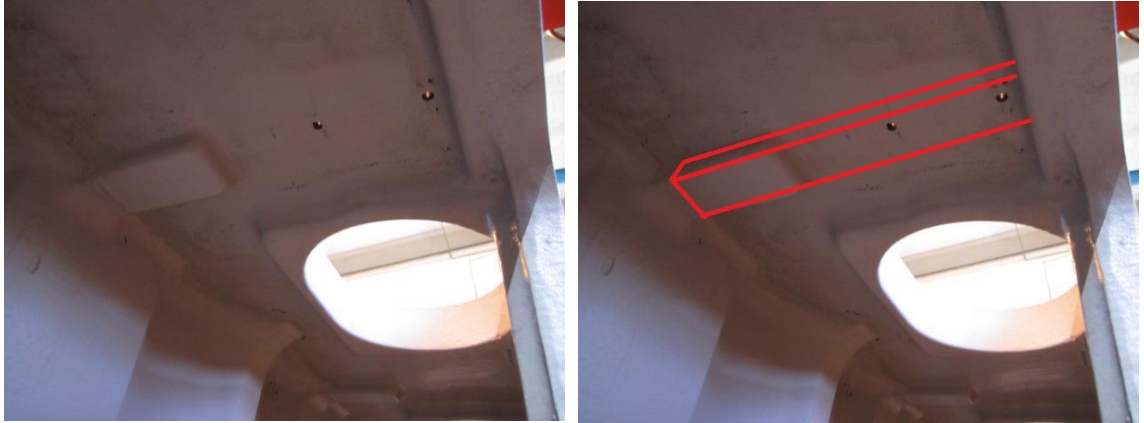
Kuva 18, Vasemmalla läpi menneet poraukset ilmatilaan, oikealla miltä ruuvipussin tulisi näyttää (Siirilä 4/15).
