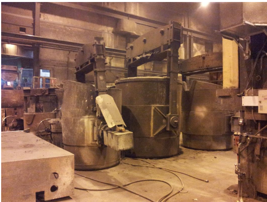
Kuva 7. Erikokoisia valusenkkoja Karlstadin valimossa, Siirilä (2/15)
