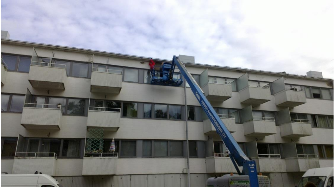
Kuva 2. Peltikatto Helsinki. (Heinonen 2015).
