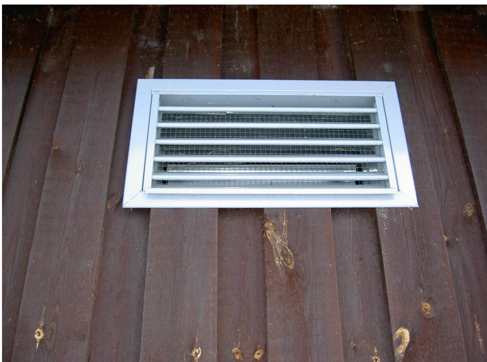
Kuva 3. Ilmastointiaukon suojaaminen ritilällä ja verkolla. (Sainmaa 2006)
