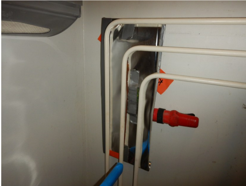
Kuva 16. Perinteinen filmi asennettuna kuvattavien käyttövesiputkien taakse korroosiokuvauksessa. Filmi on suojatussa kotelossa (foliokotelo kuvassa).
