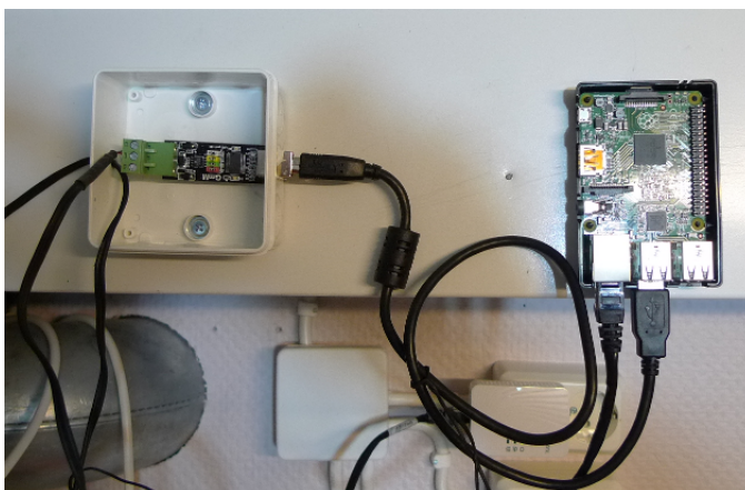
Kuva 3: RS485 muuntimen ja Raspberry Pi 2:n asennus seinään
