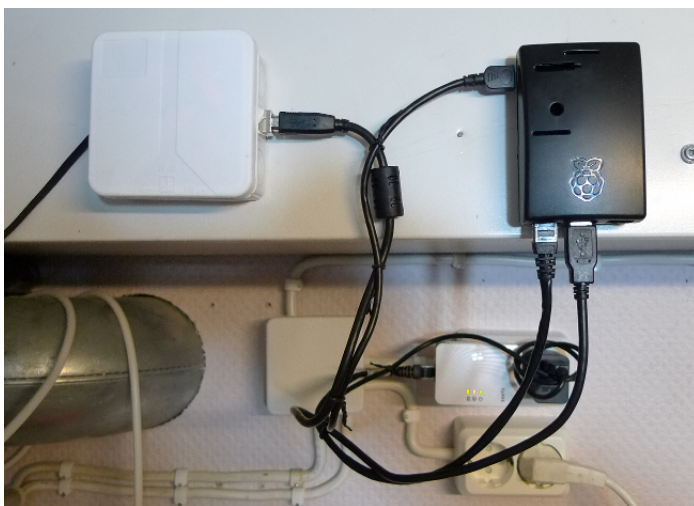
Kuva 4: Fyysinen asennus valmis
