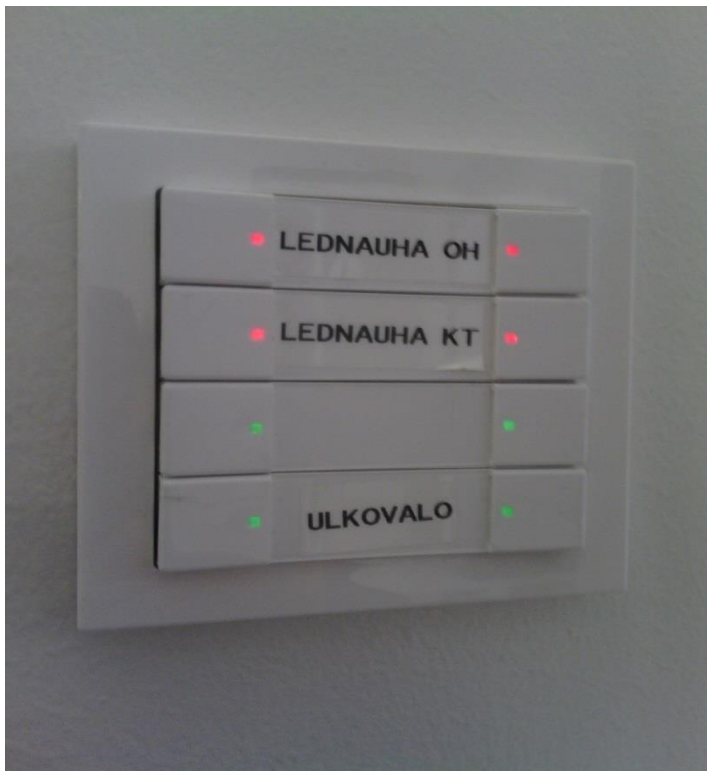
KUVA 17. KNX-järjestelmän 4-osainen painike merkattuna (Lämsä 2015-02-27.)
