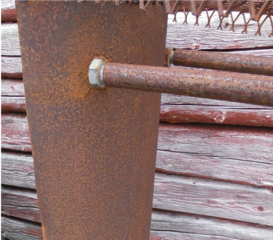
Kuva 1. Yleinen korroosio
