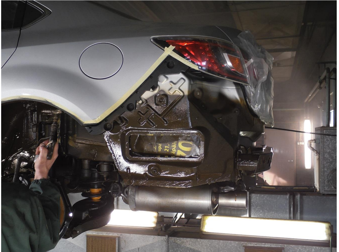
Kuva 22. Alustansuoja-aineen jälkeen. Alustansuoja-aine ruiskutetaan alustaan, pyöräkoteloihin ja muille kulutukselle alttiille pinoille.
